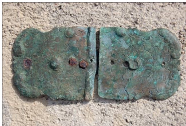
Obr. 23: Mirkovice, dům čp. 1, barokní kování zazděné v obezdávce jižní stěny jizby u jihozápadního nároží v úrovni spodní hrany jižního prahového trámu (foto L. Kodýdek).
