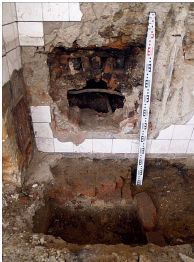
Obr. 29: Mirkovice, dům čp. 1, částečně odkryté ústí pece s předpeční jámou v sondě 2/2013 (foto J. Havlice).
