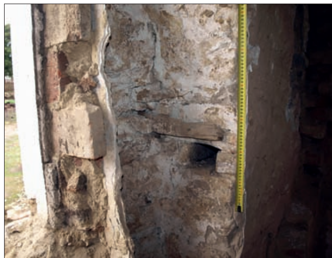
Obr. 16: Mirkovice, dům čp. 1, detail západní špalety vstupu s dochovanou dřevěnou skobou západky – vodbičkou – a kapsou pro závoru (foto M. Špínarová).
