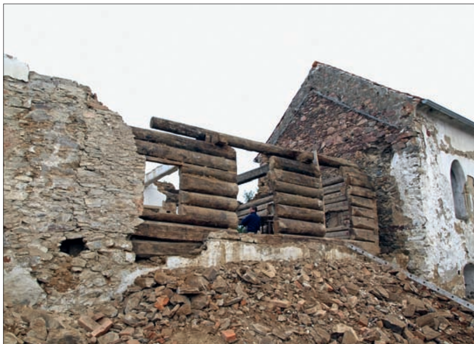
Obr. 12: Mirkovice, dům čp. 1, pohled na vnější líc jižní roubené stěny jizby, vlevo patrná nepravidelná spára oddělující přízdívku z 19. století.
