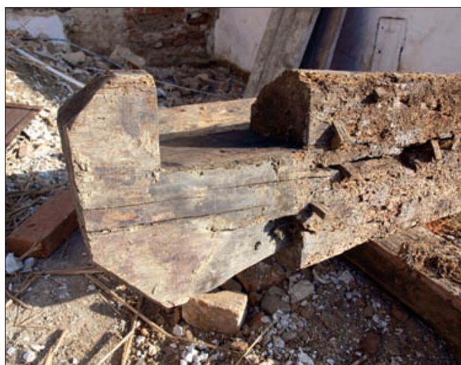
Obr. 15: Mirkovice, dům čp. 1, detail precízního provedení dlabů na jednom z trámů stěny jizby.
