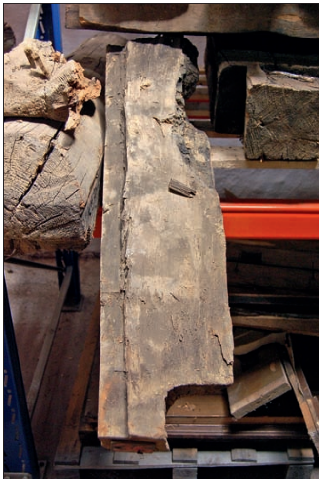
Obr. 32: Mirkovice, dům čp. 1, jeden z vyjmutých dubových překladů nad původním vstupem do síně (datováno 1405/1406), vpravo dole lůžko točnice dveří. Vlevo drážka dokládající druhotné použití tohoto prvku (foto L. Kodýdek).
