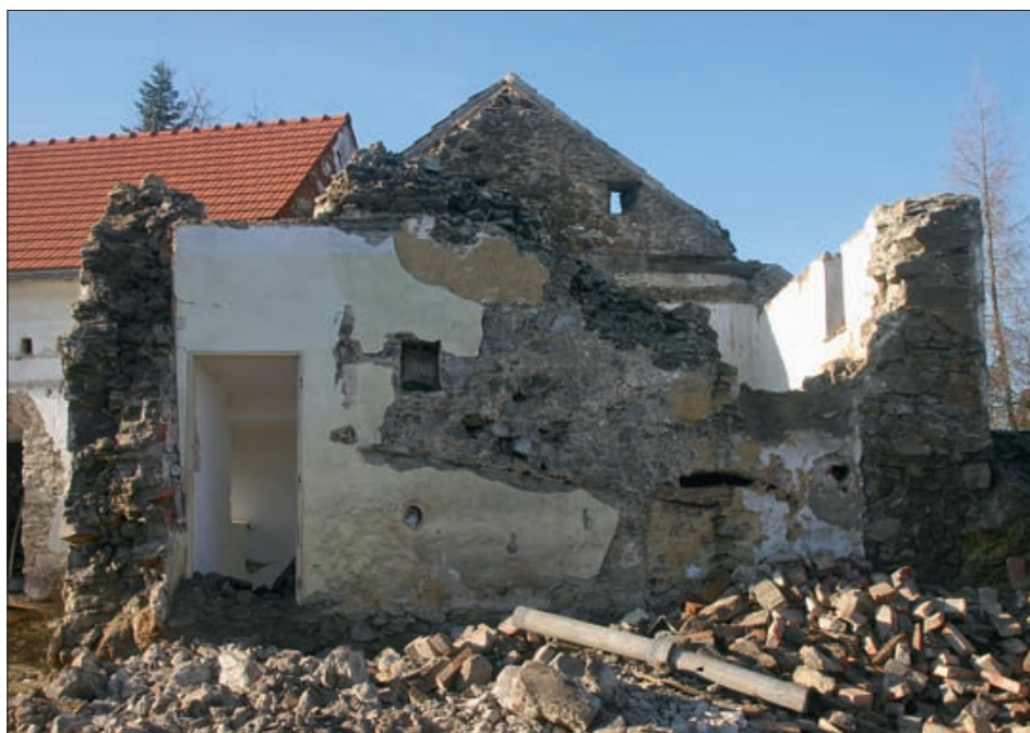
Obr. 18: Mirkovice, dům čp. 1, pohled na západní stěnu síně těsně před jejím zbouráním, vpravo dole je vidět zazděný vstup do zahloubeného přízemí komorového dílu (foto M. Špinarová).
