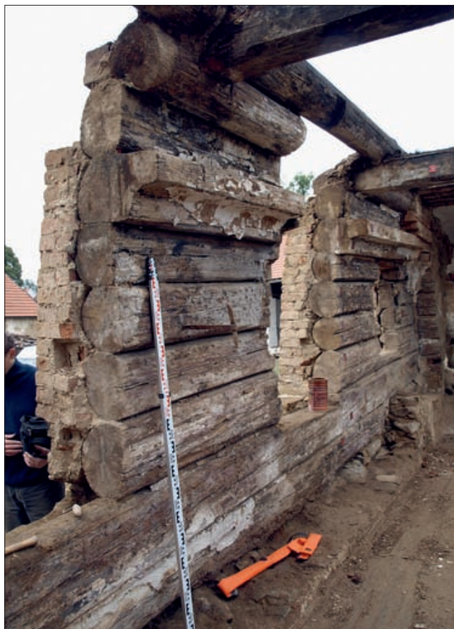
Obr. 7: Mirkovice, dům čp. 1, jižní stěna jizby s vystupující římsou.
