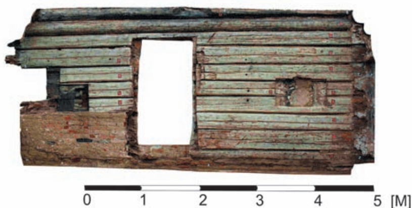
Obr. 4: Mirkovice, dům čp. 1, fotogrammetrie východní štítové stěny jizby (zpracování P. Mudra).
