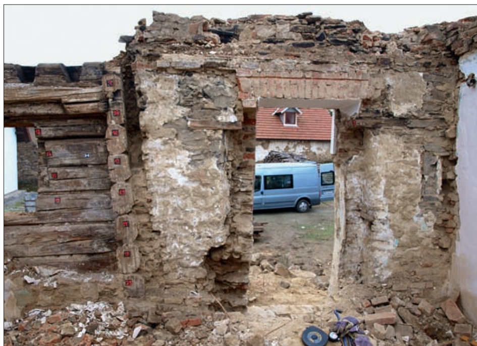
Obr. 11: Mirkovice, dům čp. 1, zdivo jižní stěny síně s původním vstupem, vpravo do vstupu dodatečně zmodernizované středověké okno, překlady nad vstupem jsou datovány do roku 1405–1406.
