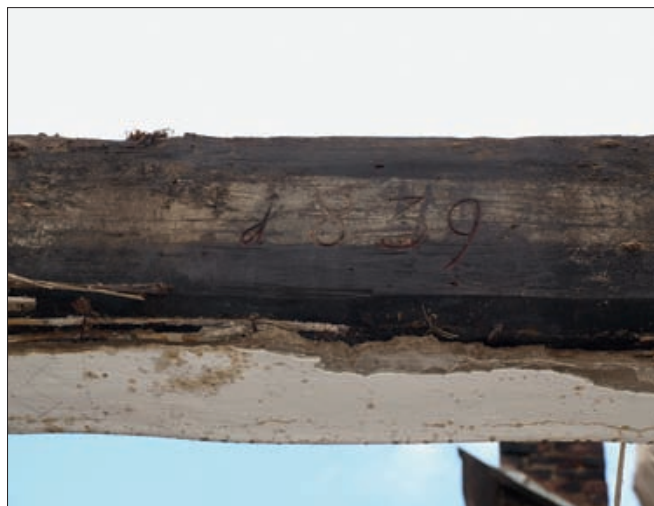
Obr. 14: Mirkovice, dům čp. 1, detail jednoho ze dvou stropních průvlaků s letopočtem 1839, kdy byla snížena původní vysoká jizba na dnešní úroveň.
