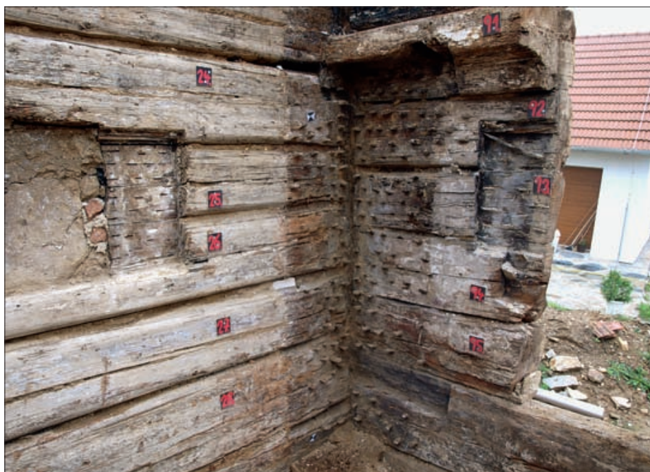
Obr. 9: Mirkovice, dům čp. 1, detail pozůstatku konstrukce neznámého účelu v jihovýchodním koutu jizby (foto M. Špinarová).
