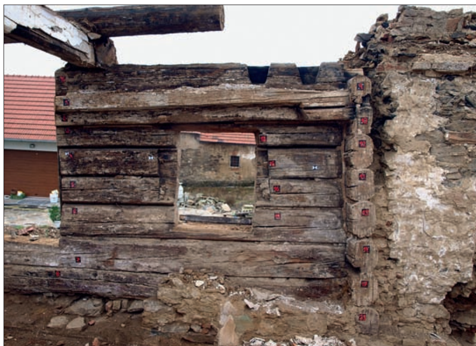
Obr. 10: Mirkovice, dům čp. 1, pohled do jihozápadního koutu roubené jizby. Dobře je čitelná odříznutá příčka oddělující zdivo síně, nad dodatečně zvětšeným oknem římsa a dva dlaby pro uložení trámů polenice.
