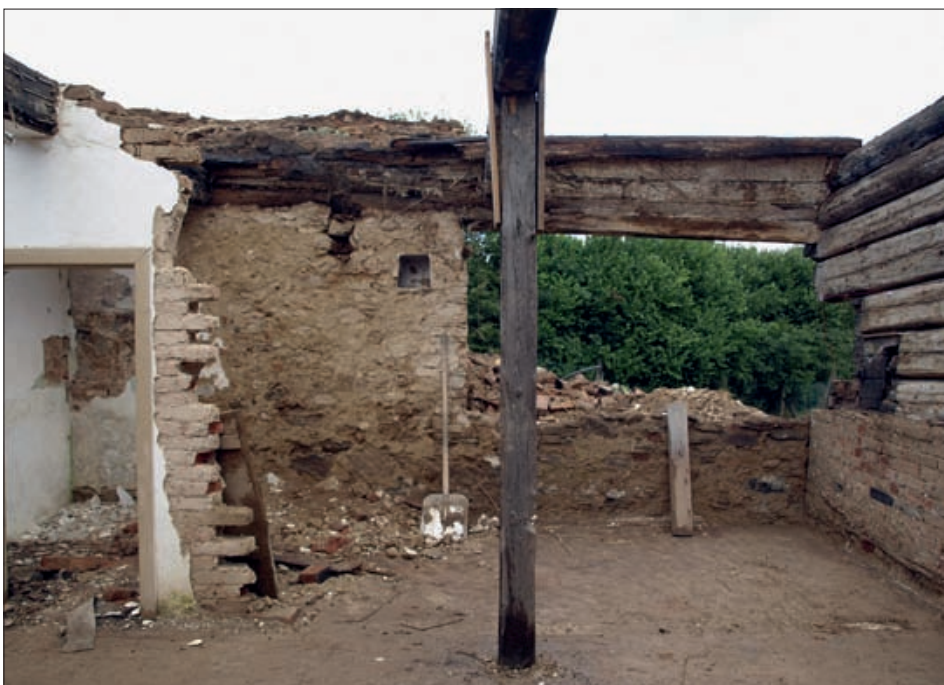
Obr. 13: Mirkovice, dům čp. 1, severní stěna jizby s mladším snad barokním podezděním, ve kterém je výklenek se skříňkou a vlevo od něj otisk vzpěry zaniklého původního průvlaku vysoké jizby.
