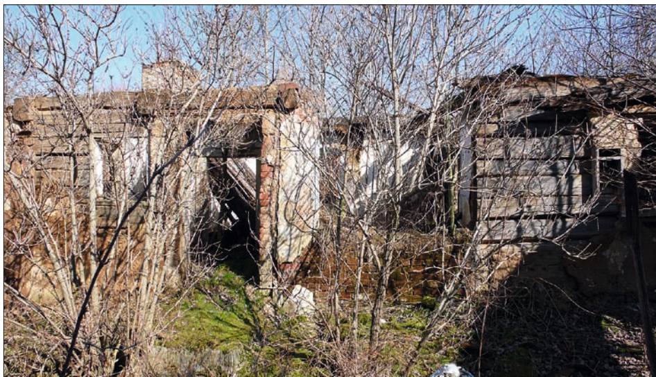
Obr. 7: Lišina, usedlost čp. 46, západní (zápražní) strana roubeného domu se vstupem do bývalé síně, vpravo přední díl se světnicí (stav 2012).
