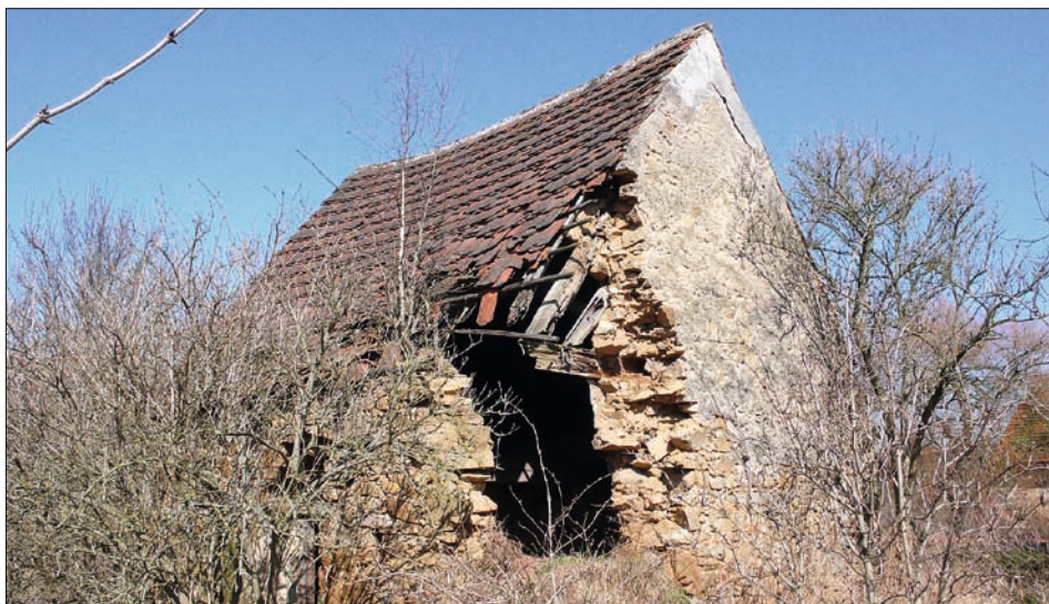
Obr. 8: Lišina, usedlost čp. 46, zadní sýpka stojící v hloubce dvora v ose za obytným stavením, pohled od jihu, respektive jihozápadu. Vlevo západní strana se vstupem, vpravo jižní průčelí (stav 2012).
