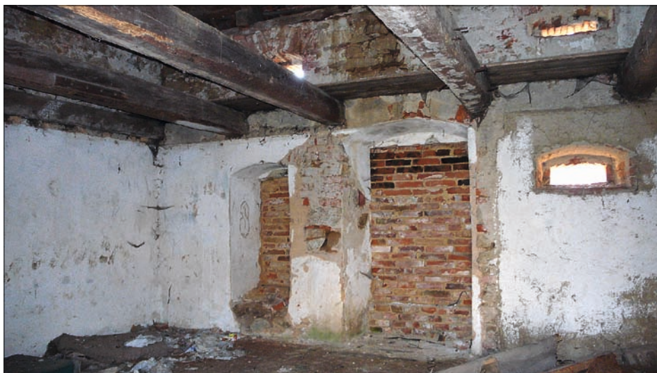
Obr. 11: Líšina, dvůr čp. 46, sýpka situovaná v čele statku proti obytnému stavení, pohled do interiéru, jihozápadním směrem. Dřevo použité ve stavbě bylo kácené podle dendrochronologického průzkumu v roce 1845 (stav 2012).
