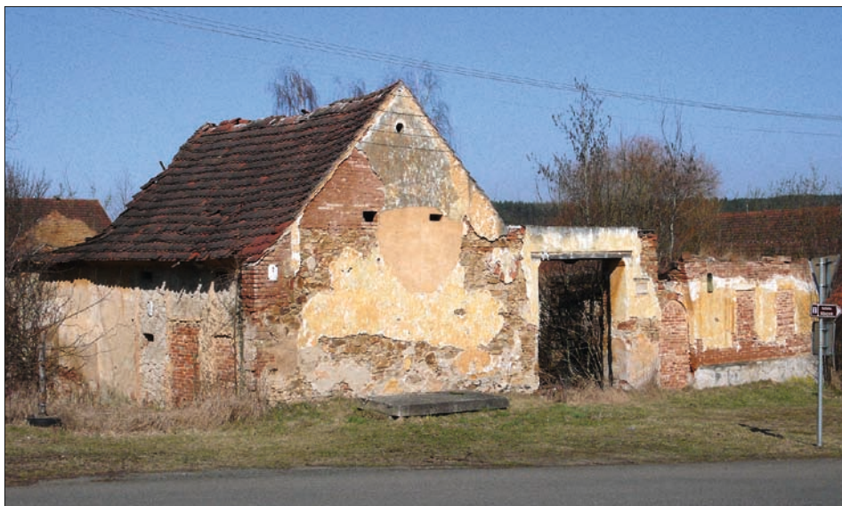
Obr. 6: Lišina (okres Plzeň-jih), jižní (návesní) průčelí statku čp. 46. V levé části stojí sýpka, kladená dendrodatací do 40. let 19. století, v části pravé pak sekundárně vyzdvižený zděný štít, přilehlý k původně roubenému domu, vystavěnému v období kolem roku 1800 (stav 2012).
