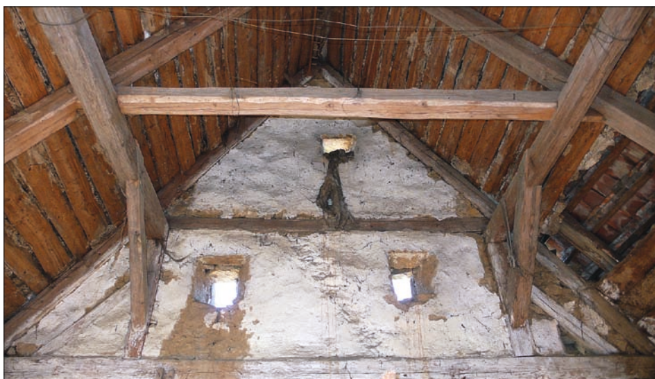
Obr. 10: Líšina, dvůr čp. 46, sýpka za domem. Pohled z interiéru na vnitřní stranu severní stěny s dobře patrným pokrytím spodního krovu bedněním, opatřeným hliněným lepenцем (stav 2012).
