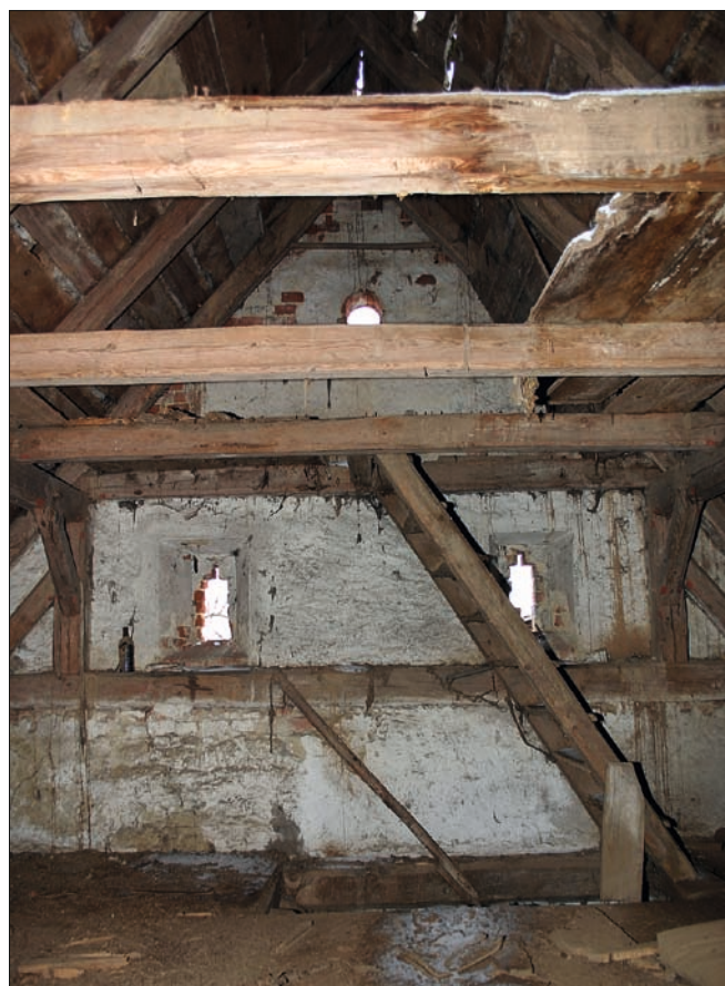
Obr. 2: Ves Touškov, sýpka v čp. 25, interiér, podkrovní část, pohled ke štítu (stav 2006).
