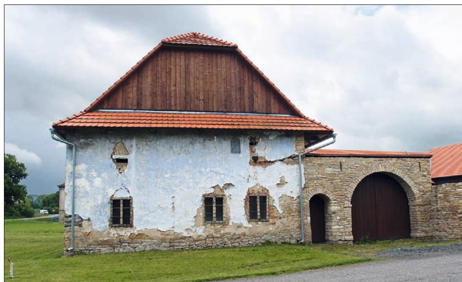
Obr. 26: Hrušová, čp. 10, čelní pohled na obytný dům se zřetelnou svíslou spárou mezi prvním a druhým traktem
