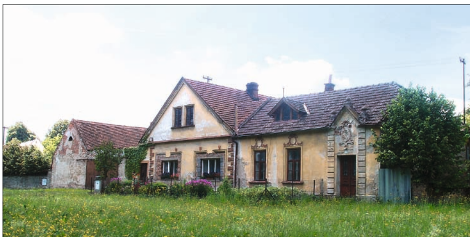
Obr. 25: Hrušová, čp. 15, výměnek se secesním tvaroslovím a samostatným vchodem přestavěný v roce 1914.
