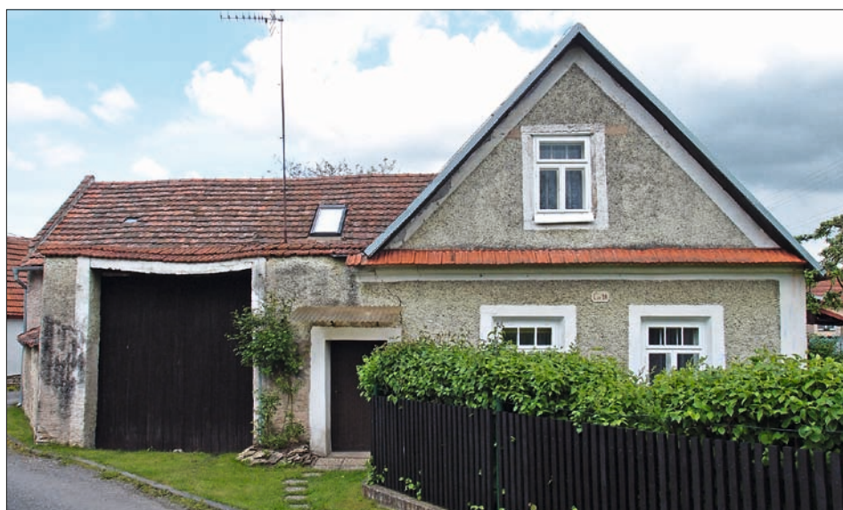
Obr. 17: Hrušová, čp. 34, klasická podoba mladšího domkářského stavení s malým uzavřeným dvorkem a stodůlkou fungující zároveň jako kolna.
