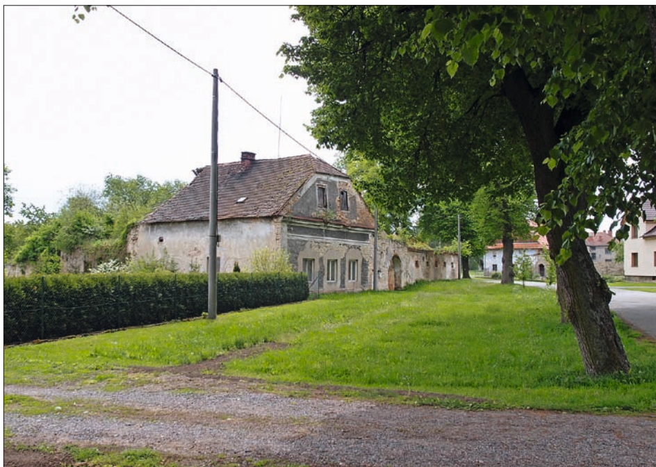
Obr. 6: Hrušová, čp. 9, usedlost z počátku 19. století. Jednotlivé budovy kopírují nepravidelný tvar stavební parcely. Částečně ubouraný obytný dům má polopatrový charakter s vysokou světnicí, jejíž výška byla během pozdější adaptace alespoň opticky snížena pomocí vložené omítkové římsy. Původní dýmník byl nahrazen tahovým komínem (všechny snímky J. Švec, 2014, není-li uvedeno jinak).
