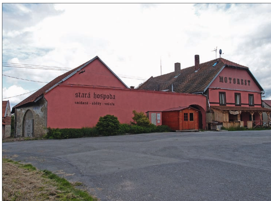
Obr. 7: Hrušová, čp. 1, budova hostince postavená nejpozději na počátku 19. století, poznamenaná nevhodnými adaptacemi v posledních desetiletích.
