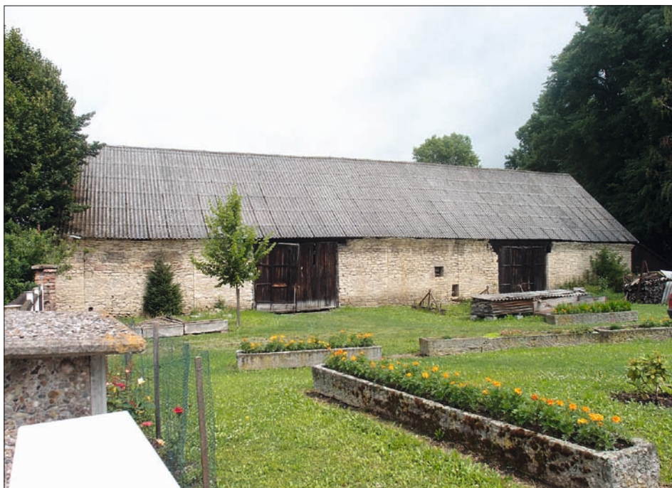
Obr. 8: Hrušová, čp. 30, původně pilířová stodola postavená po požáru v roce 1847 byla následně v roce 1864 prodloužena o další mlát a sjednocena pod společnou římsu.
