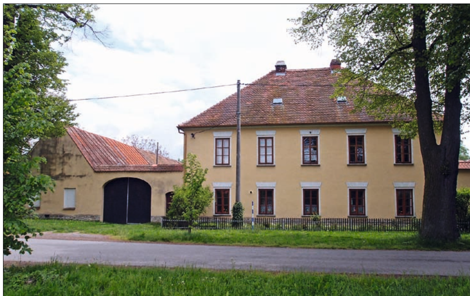
Obr. 34: Hrušová, čp. 8, čelní pohled na obytný dům a jeden z hospodářských traktů.
