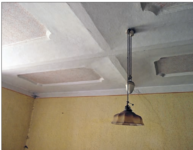
Obr. 33: Hrušová, čp. 30. Nové stropy vložené do obytného domu během adaptace v průběhu 90. let 19. století jsou tvořené plochými cihelnými klenbami se zrcadly klenutými do křížového pole z ocelových traverz.
