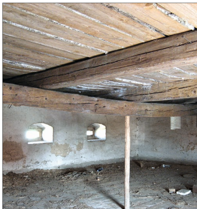
Obr. 29: Hrušová čp. 10, velká sýpková komora v prvním patře třetího dílu domu. Strop je tvořený půlpovaly překrytými lepenec (stav 2010).
