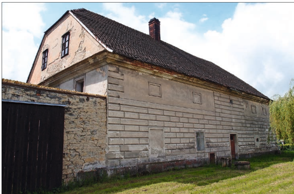
Obr. 24: Hrušová, čp. 30. Historizující fasáda s bosážemi a slepými okny provedená během adaptace domu v průběhu 90. let 19. století. Falešná pískovcová podezdívka je tvořená tenkými deskami.
