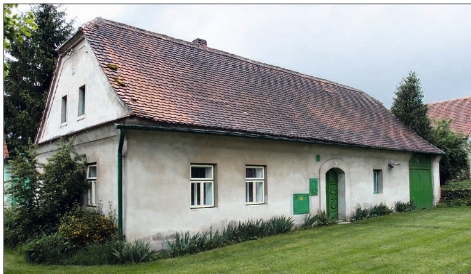
Obr. 16: Hrušová, čp. 40, pohled na vstupní stranu chalupnického stavení datovaného vročením ve štítě k roku 1844. Další adaptace proběhla v roce 1932.
