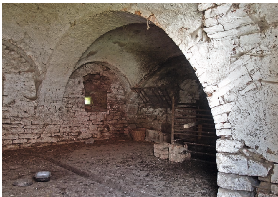
Obr. 23: Hrušová, čp. 15, zaklenutí chlévů postavených v 60. letech 19. století cihelnými placovými klennami klenutými do podélných i příčných pasů.
