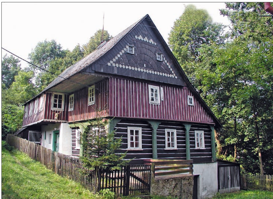
Obr. 16: Merboltice, usedlost čp. 141 s navazující plužinou (lán číslo 15). Fotografie bývalého výminku čp. 192 v západní části areálu, pohled od severozápadu (foto A. Sellnerová, srpen 2005).
