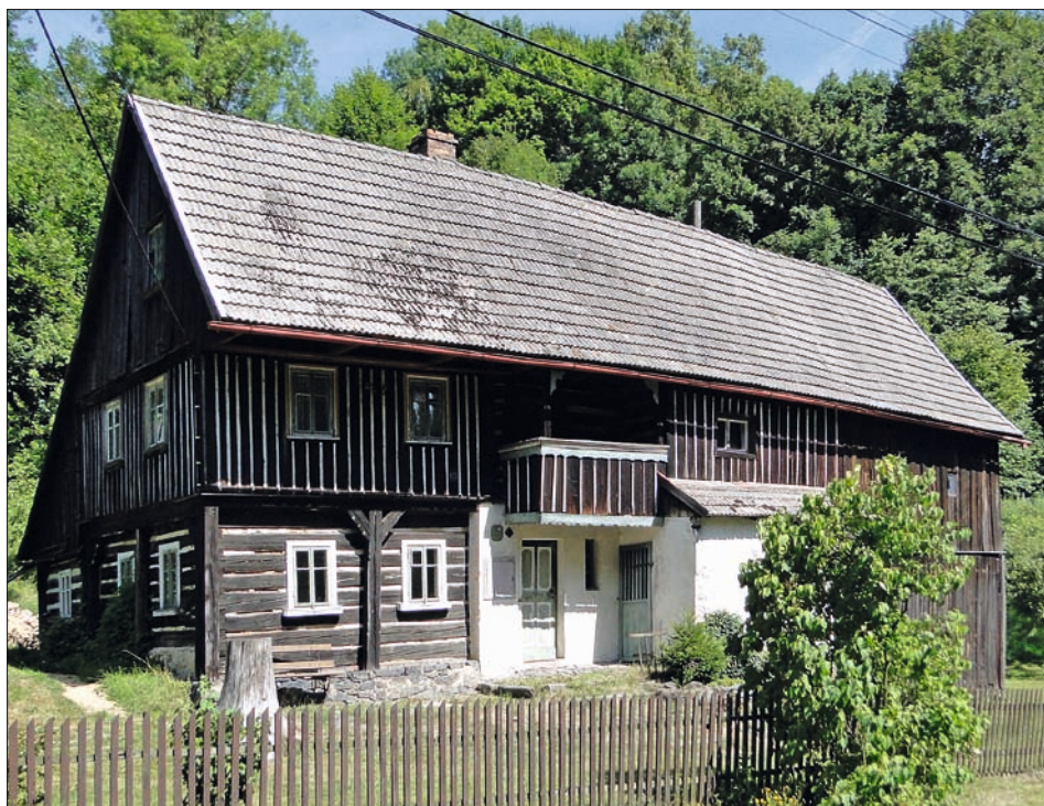
Obr. 3: Merboltice, pohled od jihozápadu na dům čp. 63, který stojí v severní části obce. Jde o jeden z dokumentovaných objektů v rámci tohoto projektu v roce 2013 (foto A. Sellnerová, září 2011).
