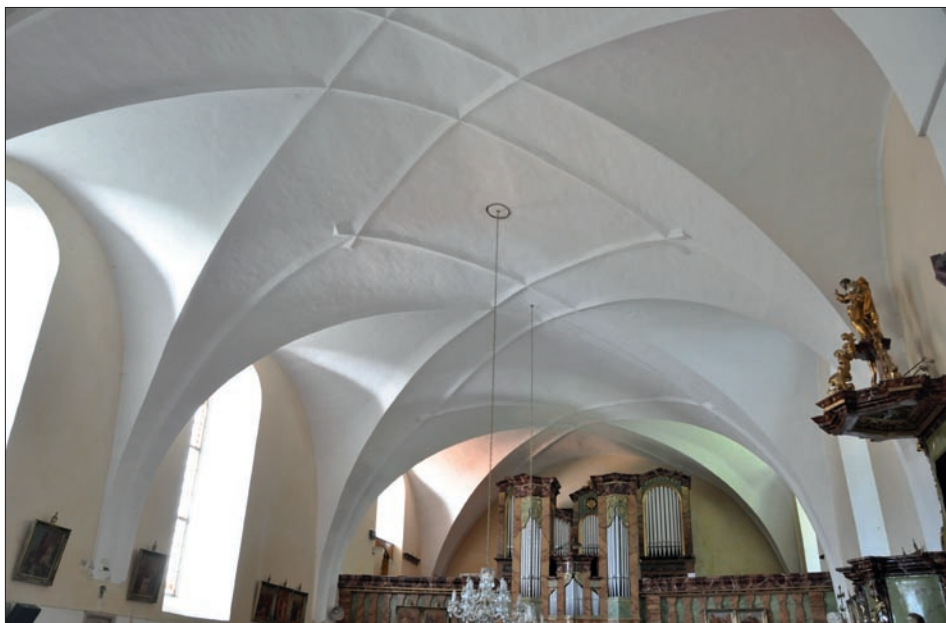
Obr. 7: Neustupov, kostel Nanebevzetí P. Marie, loď s dodatečně vloženou renesanční klenbou, pohled od východu (foto J. Veselý, 2013).
