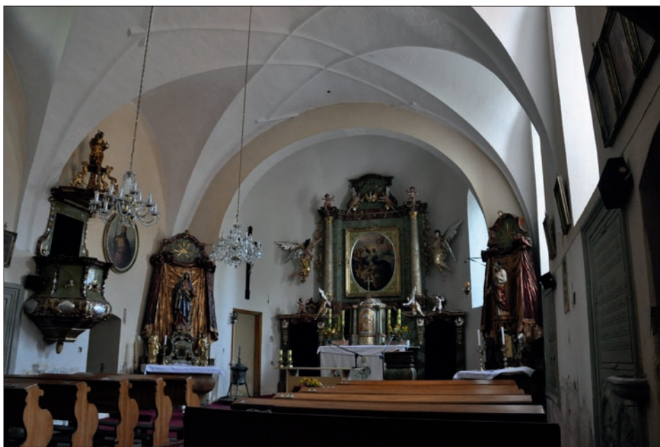
Obr. 8: Neustupov, kostel Nanebevzetí P. Marie, loď s dodatečně vloženou renesanční klenbou, pohled od západu (foto J. Veselý, 2013).
