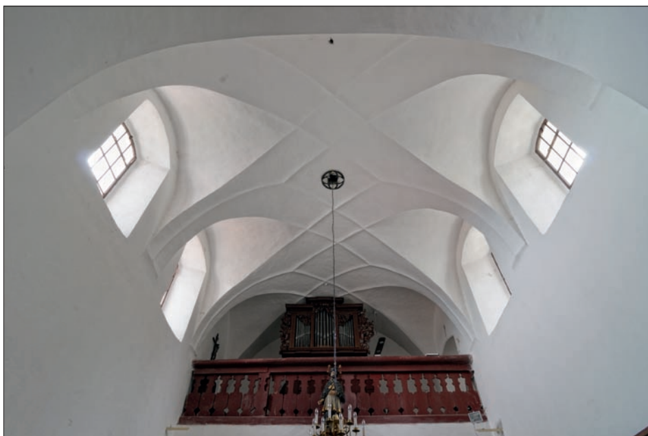
Obr. 12: Tožice (okres Benešov), kostel sv. Martina, renesanční, dodatečně vložená klenba pozdně románské lodi (foto Z. Neustupný, 2015).
