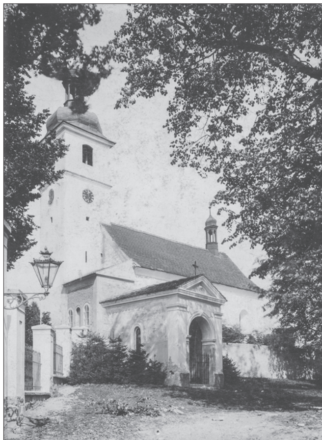
Obr. 5: Neustupov, kostel Nanebevzetí P. Marie. Pohled od jihozápadu. Zachycena barokizovaná podoba věže před puristickými úpravami z 20. let 20. století, při nichž zanikl i přístavek při západním průčelí lodi (foto z pozůstalosti A. Podlahy, nedatováno; Sběrka fotografické dokumentace NPÚ GnŘ).
