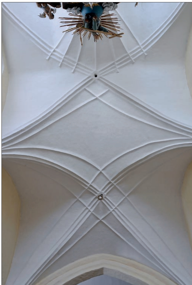
Obr. 10: Střeziměř (okres Benešov), kostel sv. Havla, renesanční, dodatečně vložená klenba gotického presbytáře (foto Š. Kolářová, 2015).
