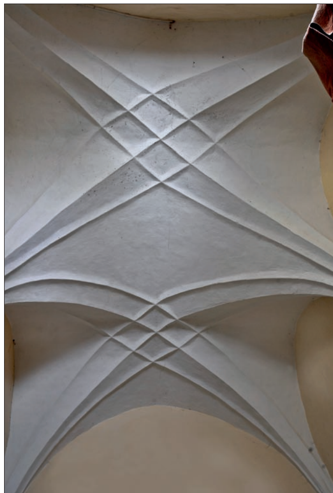
Obr. 11: Střeziměř, kostel sv. Havla, renesanční, dodatečně vložená klenba gotické sakristie (foto Š. Kolářová, 2015).
