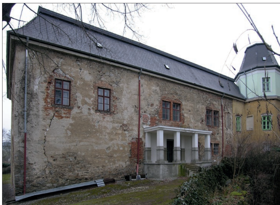
Obr. 3: Neustupov, zámek. Ke kostelu orientované průčelí východního křídla, jehož jádro tvoří někdejší pozdně gotická tvrz. Na fasádě dochované zbytky sgrafitové omítky (foto J. Kypta, 2015).
