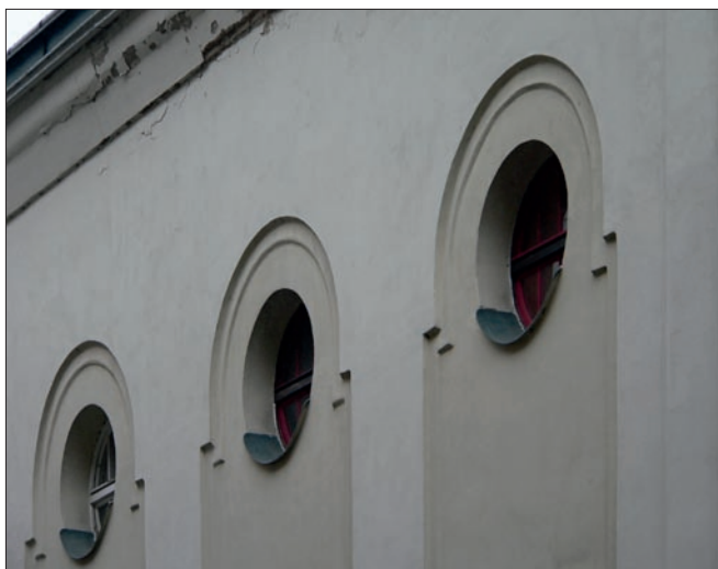
Obr. 14: Liberec, kino Varšava – detail horní partie fasády hlavního průčelí členěného vpadlými poli zakončenými plnými oblouky se sedmi okny, prosvětlujícími někdejší hromadné garáže situované nad kinosálem (foto J. Zeman, prosinec 2013).
