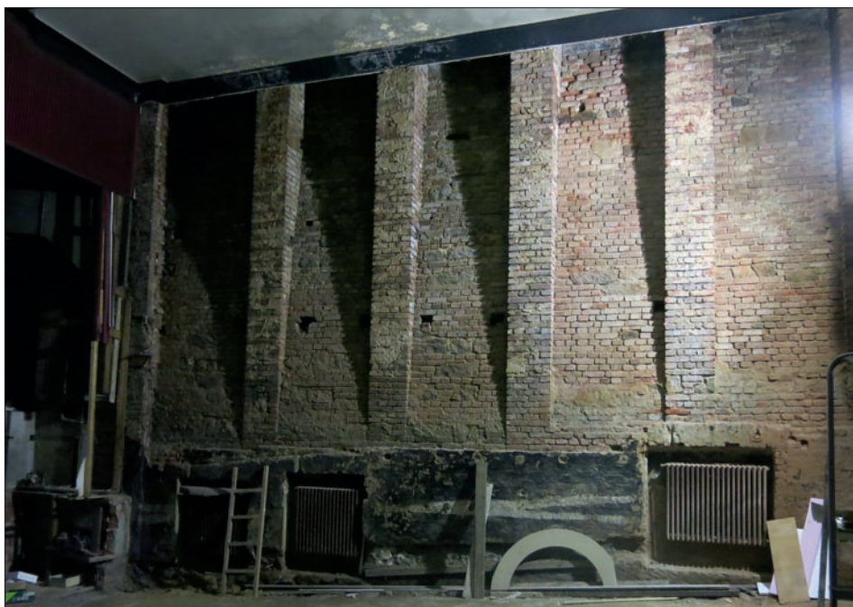
Obr. 24: Liberec, kino Varšava – stěny kinosálu po odstranění novodobých úprav svislých konstrukcí, které zamezovaly cirkulaci vzduchu v sále (foto A. Řičánková, leden 2015).
