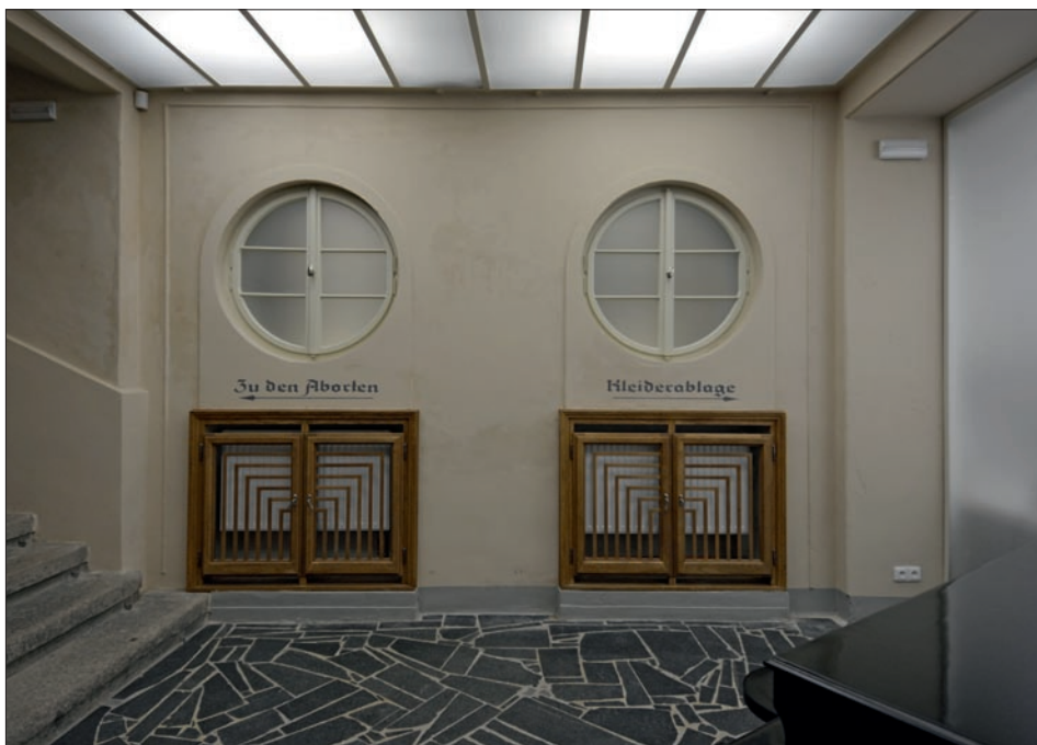
Obr. 19: Liberec, kino Varšava – zadní prostor vstupního foyer s obnoveným podhledem z mléčného skla, kryjícím osvětlení zavěšené přímo pod stropem. Nově jsou osazeny také kopie původních oken a dřevěných krytů topení. Obnoveny jsou i původní písmomalířské nápisy (foto P. Šmídek, březen 2015).
