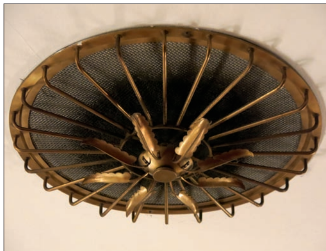
Obr. 25: Liberec, kino Varšava – detail dekorativního krytu stropní ventilace (foto A. Řičáňková, prosinec 2013).
