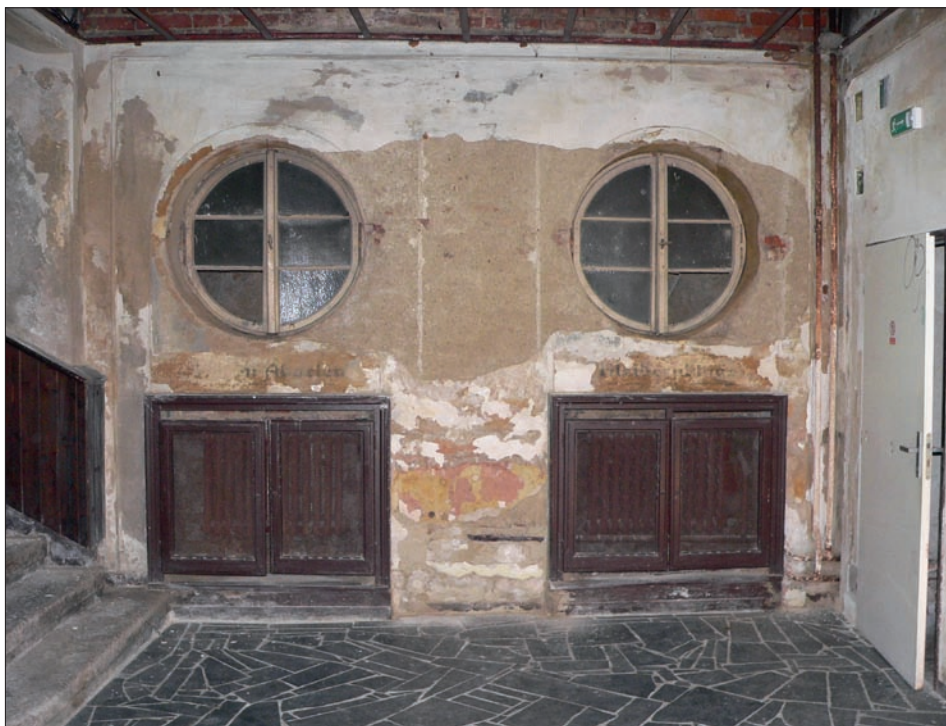
Obr. 18: Liberec, kino Varšava – kruhová okna v zadní části vstupního foyer ústící do svislých větracích průduchů, které tvořily součást důmyslného systému odvětrávání jinak uzavřeného prostoru (foto A. Řičánková, prosinec 2013).
