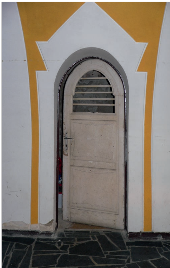
Obr. 22: Liberec, kino Varšava – detail art décoových rámových dveří v dělící šijtí ústících do skladovacích prostor (foto J. Zeman, prosinec 2013).
