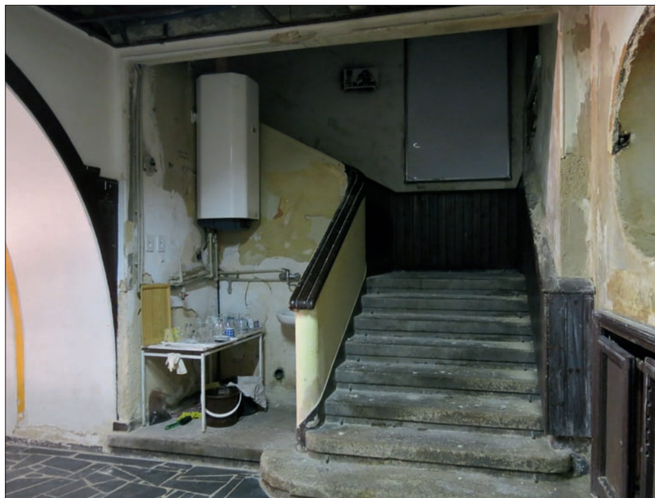
Obr. 20: Liberec, kino Varšava – schodiště stoupající ze vstupního vestibulu do patra, v jehož ohybu se původně nacházela drobná kamenná kašna s florálním dekorem (foto A. Řičánková, prosinec 2013).
