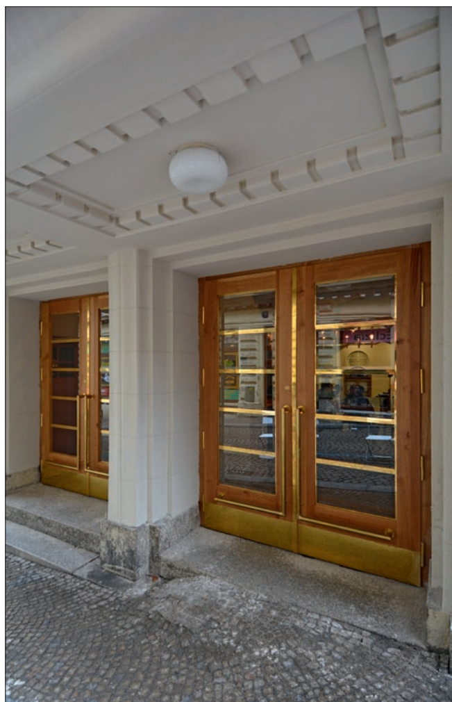
Obr. 13: Liberec, kino Varšava – sdružený hlavní vstup do kina s novými dveřními výplněmi vyrobenými dle původní plánové dokumentace, které nahradily nevhodné novodobé typové kovové dveře (foto P. Šmídek, duben 2015).
