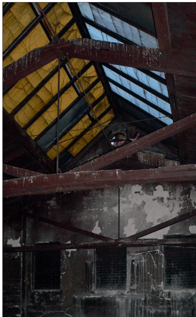
Obr. 34: Liberec, kino Varšava – interiér někdejších hromadných garáží v prostoru nad kinosálem s patrnou konstrukcí krovu a prosklenou střechou (foto J. Zeman, prosinec 2013).
