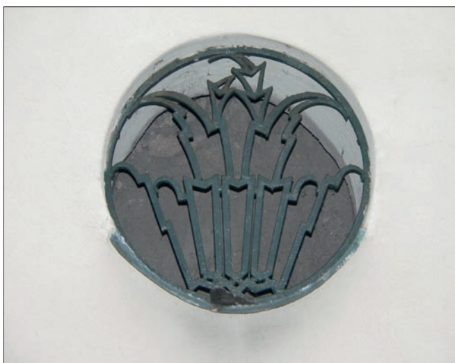
Obr. 15: Liberec, kino Varšava – detail jednoho ze sedmi kruhových větracích otvorů s art décoovou mřížkou na hlavním průčelí, využívaných původně k odvětrávání kinosálu (foto J. Zeman, prosinec 2013).
