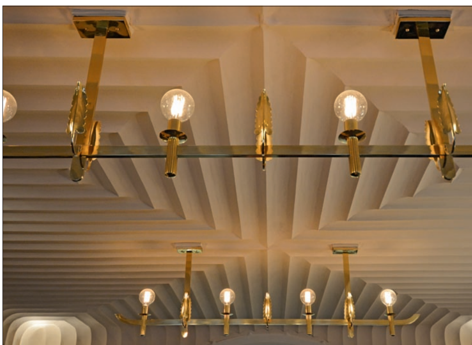
Obr. 32: Liberec, kino Varšava – detail znovu osazených, restaurovaných mosazných svítidel ve foyer (foto P. Šmídek, duben 2015).
