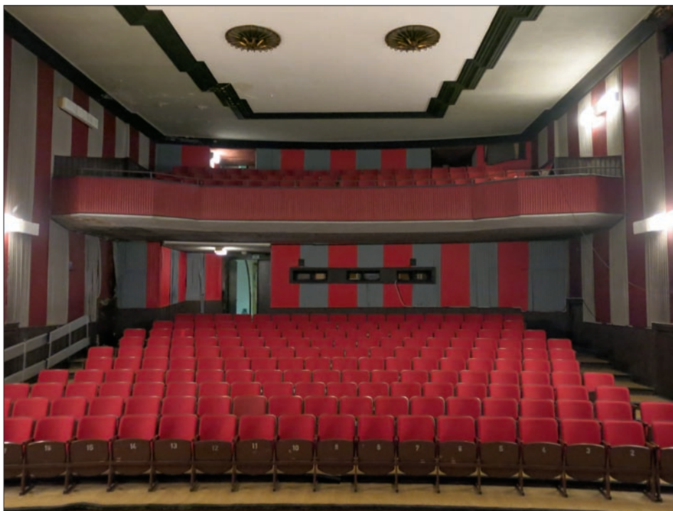
Obr. 23: Liberec, kino Varšava – pohled do kinosálu směrem od jeviště, na němž je patrný nevhodný kožený obklad stěn a balkónu ze 70. let 20. století (foto A. Řičánková, prosinec 2013).
