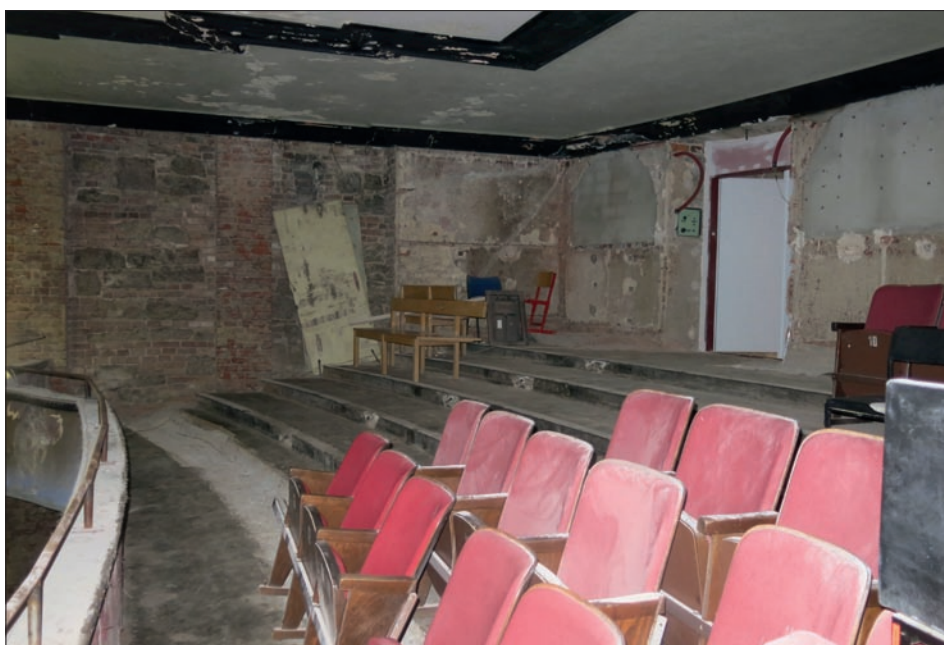
Obr. 30: Liberec, kino Varšava – pohled na balkón po odstranění koženkových obkladů stěn z počátku 70. let (foto A. Řičánková, leden 2015).
