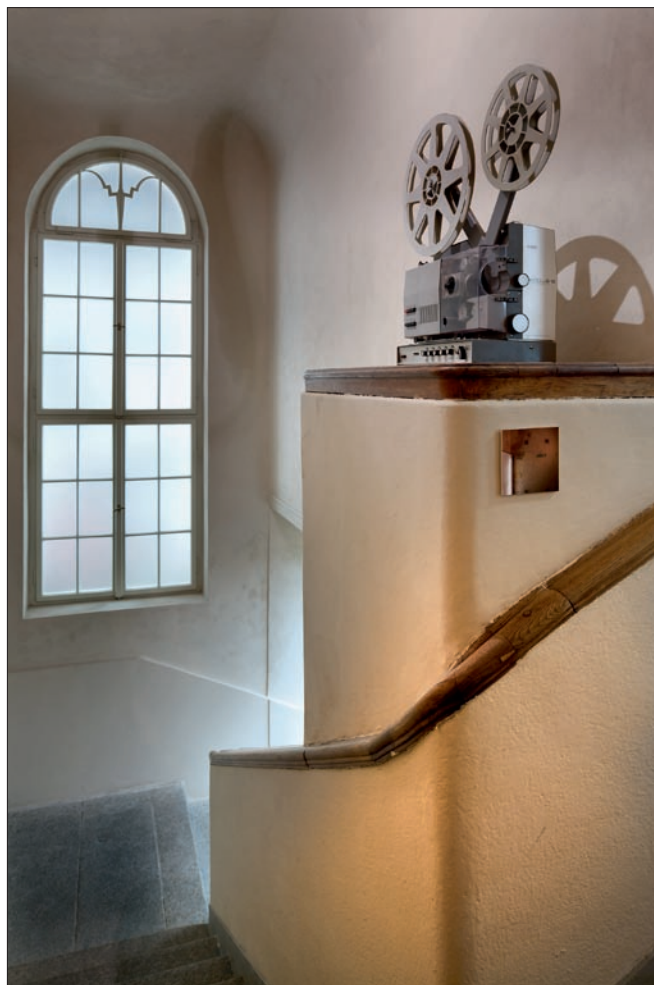
Obr. 27: Liberec, kino Varšava – velkoformátové art décové okno nad podestou schodiště do patra, tvarová a materiálová kopie vzhledem k napadení veškerých dřevěných prvků dřevokaznými houbami (foto A. Jungmann, březen 2015).
