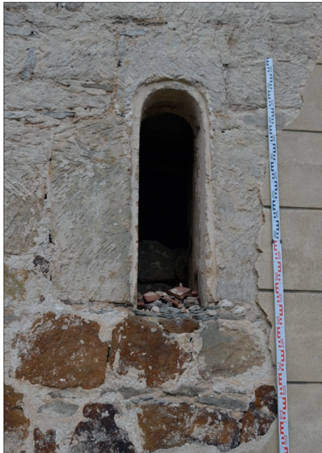
Obr. 10: Drchlava, kostel – detail podoby románského okenního otvoru po opadu klasicistní omítky.
