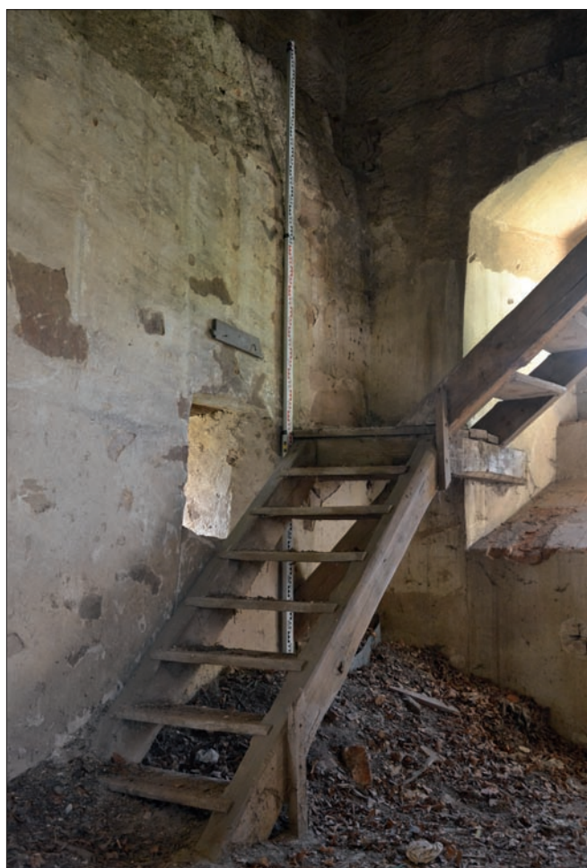
Obr. 12: Drchlava, kostel – detail zčásti zazděného románského okna v jižní stěně věže překrytého mladším schodištěm; vpravo špaleta okna a záklenek mladšího klasicistního okna; nahoře nad záklenkem ústupek ve zdivu, kde navazuje již mladší kvádrové zdivo.
