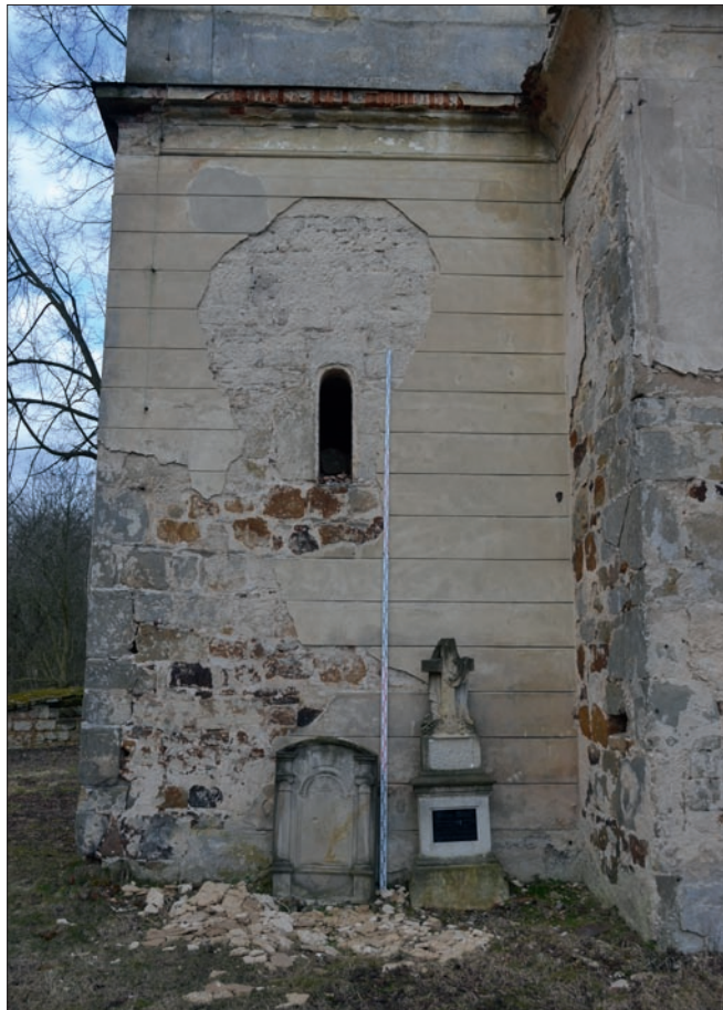
Obr. 9: Drchlava, kostel – pohled na jižní průčelí západní věže s okenním otvorem v románském zdivu dosahujícím k mezípatrové římsě.
