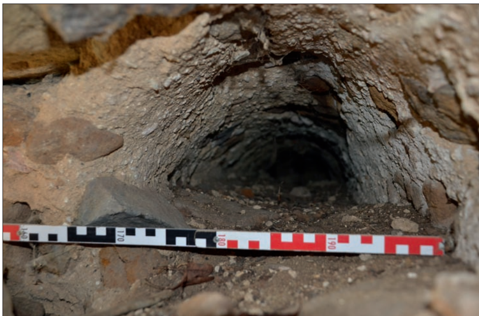
Obr. 6: Drchlava, kostel – detail negativu po vyhnité dřevěné výztuze v síle zdiva u jihozápadního nároží lodi (2014).
