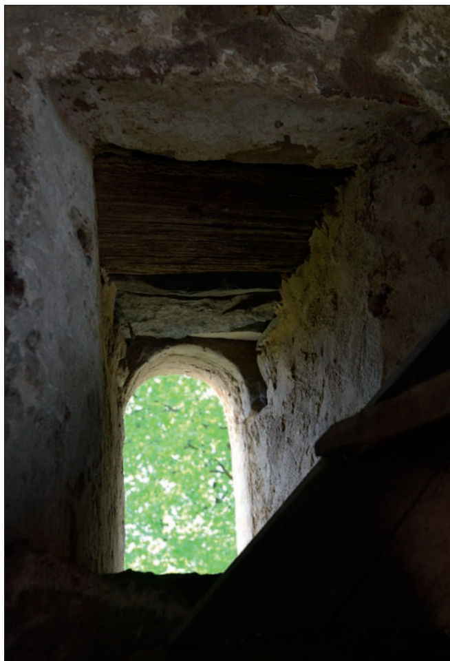
Obr. 14: Drchlava, kostel – detail okenní niky románského otvoru s omítanými špaletami a překladem tvořeným omítaným pískovcem, dřevěnou výztuhou datovanou dendrochronologicky na přelom let 1214/1215, neo-mítanými kameny a navazujícím pískovcovým překladem s vysekaným plným obloukem románského okna.
