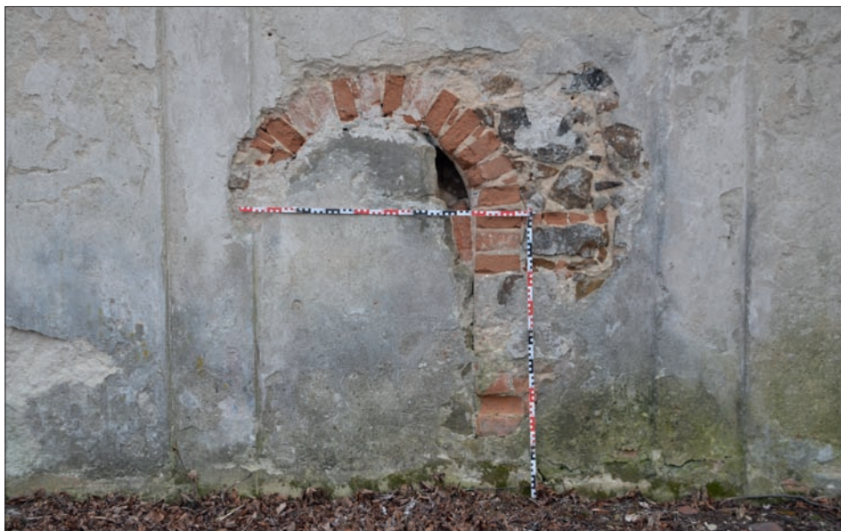
Obr. 8: Drchlava, kostel – otvor s půlkruhovým záklenkem z vysokých cihel u severozápadního nároží lodi, hypoteticky datovaný jako renesanční.
