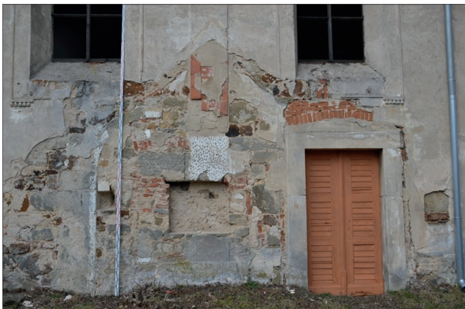
Obr. 7: Drchlava, kostel – pohled na náleзовou situaci vývoje vstupu v jižním průčelí lodi. Zleva je čitelný relikt románského otvoru profilovaný ústupkem a dochovanou částí plného oblouku. Na lizéně je patrný vrchol otisku stříšky zmizelé předsíně, jež náležela k druhému baroknímu vstupu, který dokládá cihelný záklenek, a pod ním pak překlad z možné mladší úpravy otvoru využívající druhotně románský prvek. Dveřní otvor vpravo náleží poslední klasicistní úpravě.
