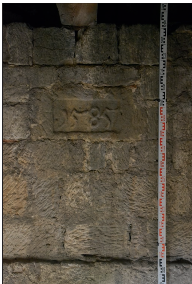
Obr. 13: Drchlava, kostel – detail mladšího kvádrového zdiva nad ústupkem v horních partiích prvního patra věže s kvádrem nesoucím letopočet 1585.
