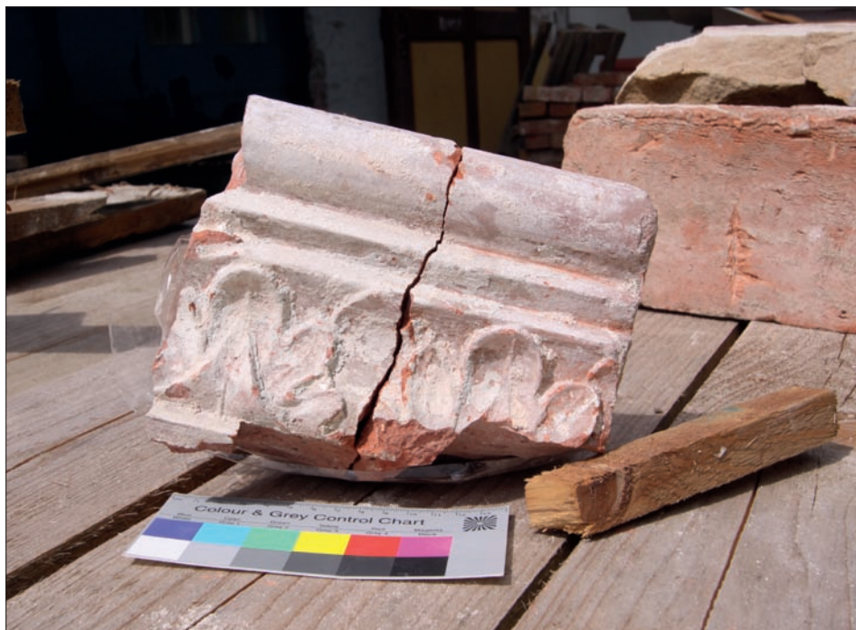
Obr. 12: Kladruby nad Labem, (okres Pardubice), zámek čp. 1, terakotová římsovka, nalezena ve zdivu při vyjímání reliéfního ostění, poloha patrná na obr. 7f, stěna 2.23a (foto...).
