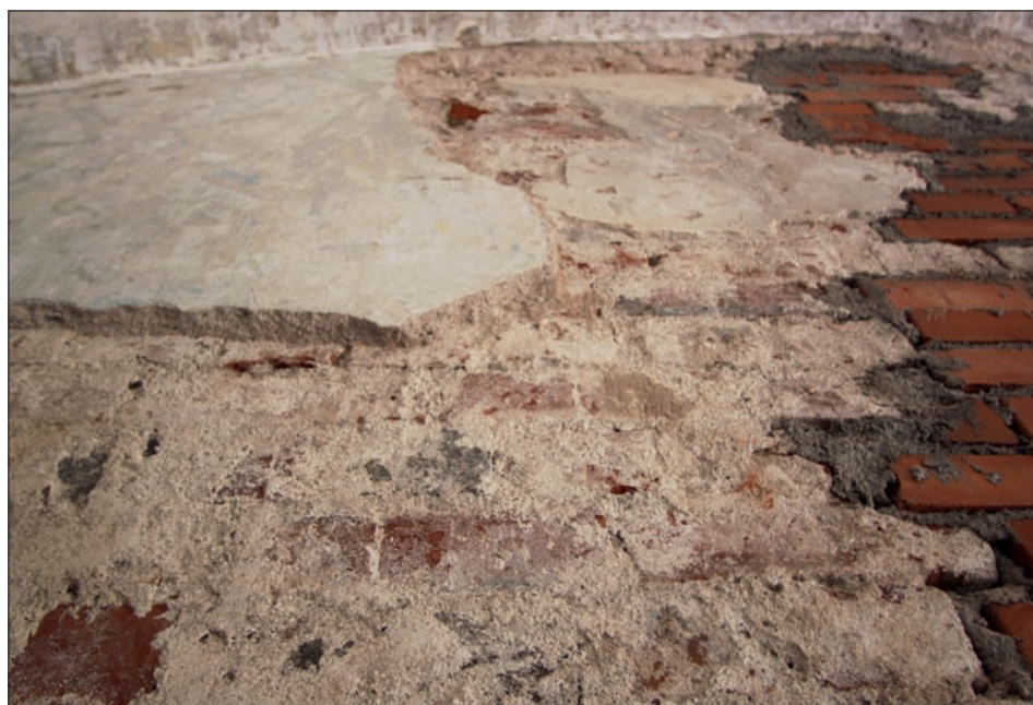
Obr. 9: Kladruby nad Labem, (okres Pardubice), zámek čp. 1, spodní pohled na charakteristický hladký povrch pernštejnské zdiva. Stěna 1.07 b, většina povrchu zničena proskrabáním spár během stavby (foto...).
