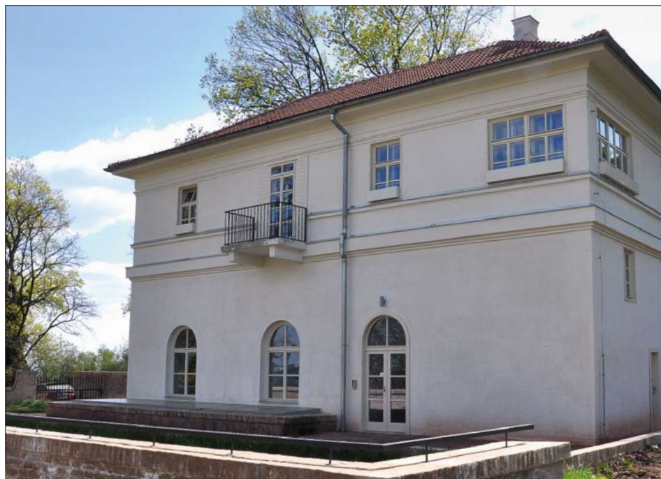
Obr. 10: Brno – Špilberk, fotografie současného stavu objektu „Hlídky 4“ od severu (foto A. Navrátil).
