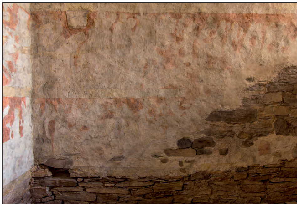
Obr. 6: Broumov, malby v suterénu fary. Zlomky pekla na severozápadní stěně – stav po restaurování (foto J. Dienstbier, 2015).
