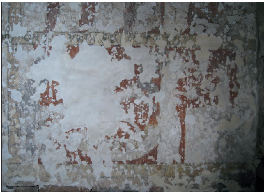
Obr. 2: Broumov, malby v suterénu fary. Detail pekla s Triumfem smrti – stav po vytmelení a opravě starších tmelů.
