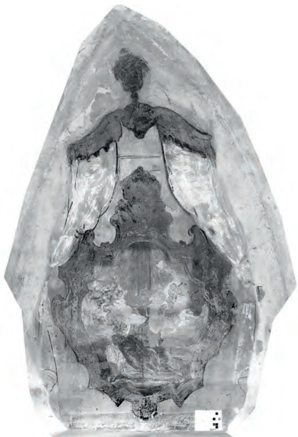
Obr. 5: Veliš, hřbitovní kaple se sochou anděla Posledního soudu, nástěnná malba Piety, snímek pořízený metodou LSI – laserové skenování v intenzitě.
