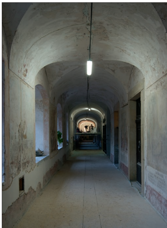
Obr. 5: Kuks, pohled do chodby v průběhu restaurování, po očištění stěn (foto M. Jiráček, 2014).
