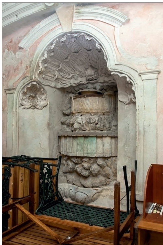
Obr. 21: Milešov, zámek – vodní kaskáda je ústředním motivem plastické výzdoby sala terreny (prostor 2.11) v polozahloubeném suterénu východního křídla (foto K. Podroužek, 2013).
