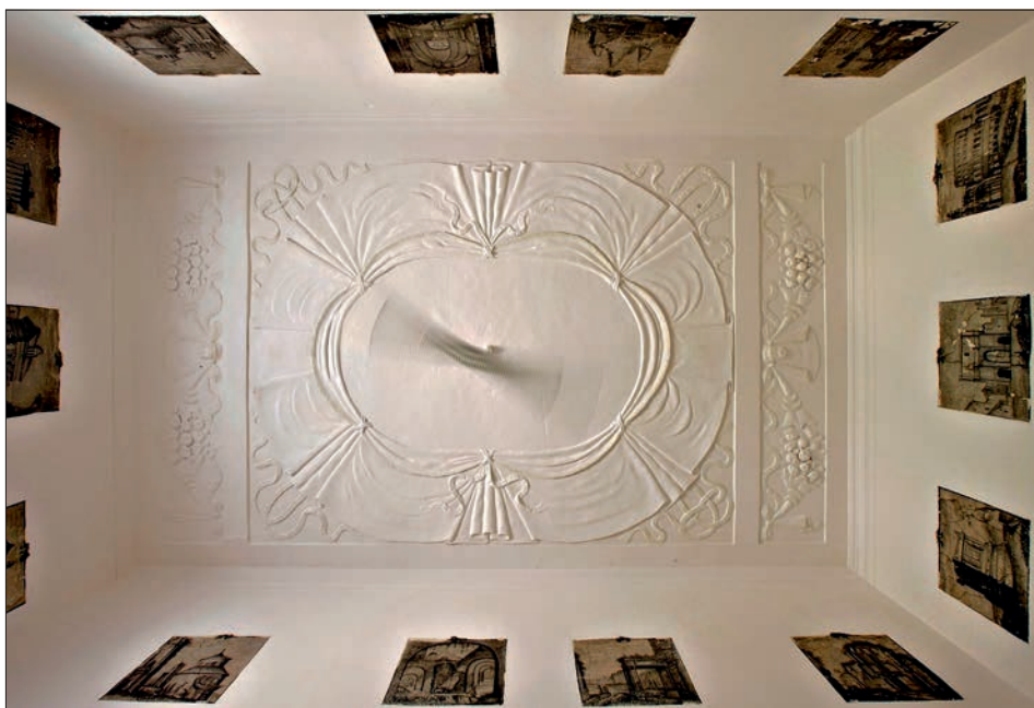
Obr. 16: Milešov, zámek – ústředním motivem raně barokní štukové výzdoby stropu kabinetu (prostor 4.15) v patře severního křídla je rozprostřený baldachýn s rytými erby Kašpara Zdeňka Kaplíře (foto M. Frouz, 2013).
