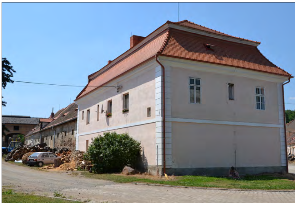
Obr. 18: Čeminy, objekt správy dvora s navazující hospodářskou budovou od jihovýchodu.
