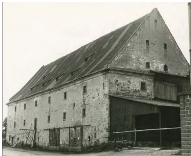
Obr. 5: Žďár, barokní sýpka v areálu dvora od severu, fotografie dokumentuje starší stav střechy s pálenou krytinou a pultovými vikýři dvou sýpkových podlaží v podkrovní (foto J. Žižka, kol. 1977).
