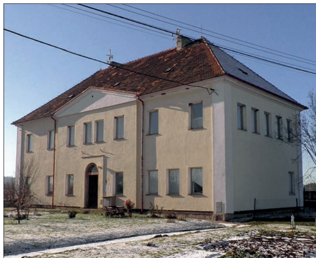
Obr. 18: Malý Bor (okr. Klatovy), škola čp. 90, současný stav budovy, pohled od severovýchodu.
