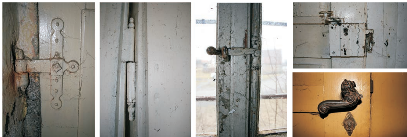
Obr. 32: Detaily použitého kování: zleva, nahoře – dveřní křížový závěs vchodových dveří školy v Malém Boru; uprostřed – dveřní zapuštěný závěs zakončený kuželkou ze školy v Těchonících; vpravo – rozvora typu españoleta užitá pro zavírání oken v Těchonících; zleva, dole – krabicový zámek ze školy v Těchonících; vpravo – litinová klika ze školy v Břežanech (stav 2013, 2014).
