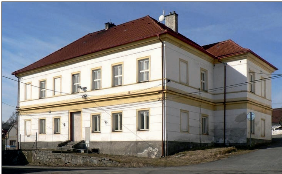
Obr. 15: Velenov (okr. Klatovy), škola čp. 83, současný stav budovy, pohled od severovýchodu.
