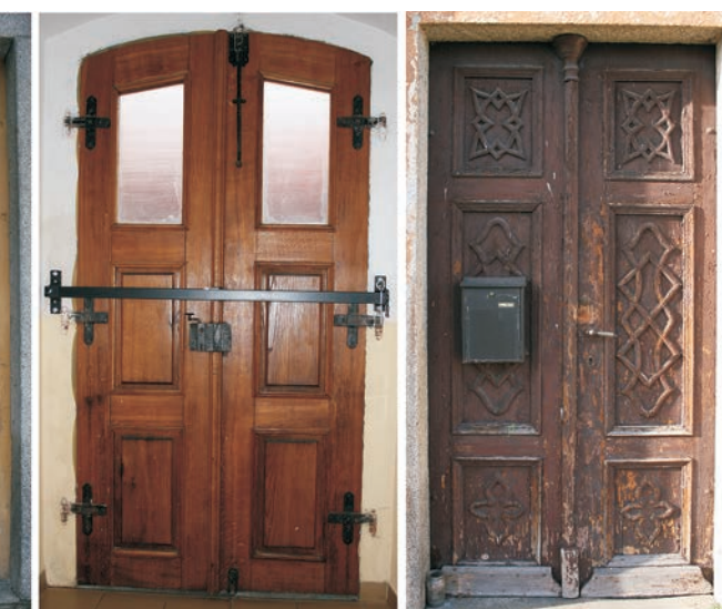
Obr. 31: Vchodové dveře školních budov: zleva – Břežany; uprostřed – Chanovice; vpravo – Malý Bor (stav 2013, 2014).
