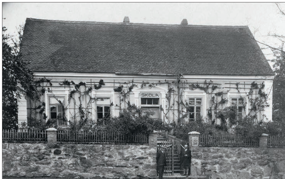
Obr. 29: Veřechov (okr. Klatovy), objekt čp. 42, stav budovy v 1. polovině 20. století, foto od jihu (reprofoto, fotografická sbírka K. Jiříčka, uloženo v Městském muzeu Horažďovice).
