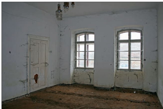
Obr. 17: Těchonice, škola čp. 13, interiér stavby, místnost v západní části v přízemí, která byla součástí bytu řídícího učitele.
