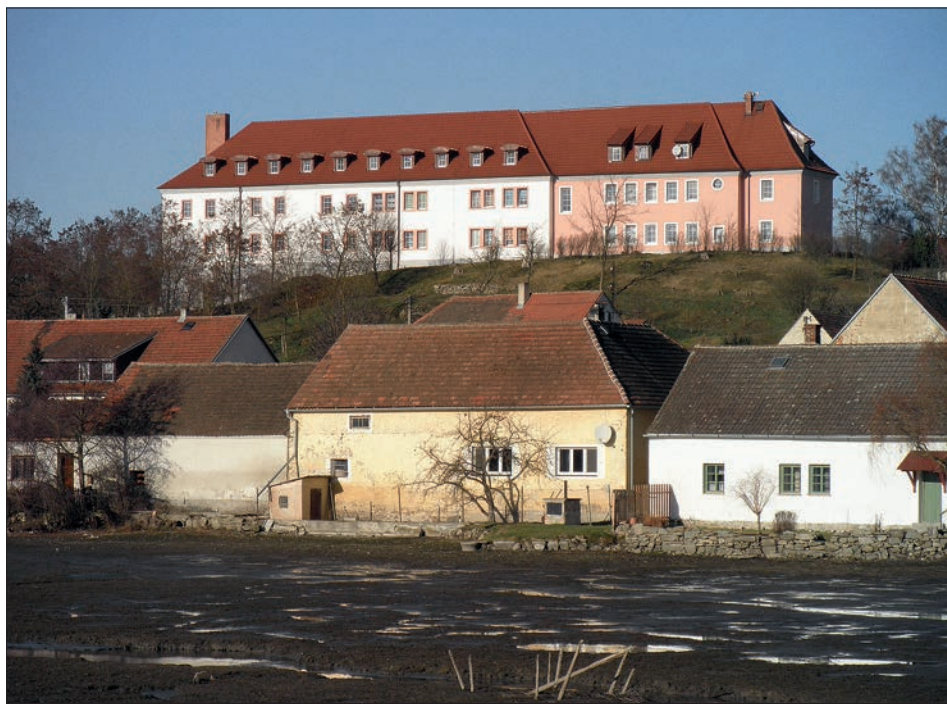
Obr. 30: Velký Bor (okr. Klatovy), objekt čp. 49 bývalého špitálu přestavěného na školu, současný stav budovy, foto od jihu přes Velkoborský rybník.
