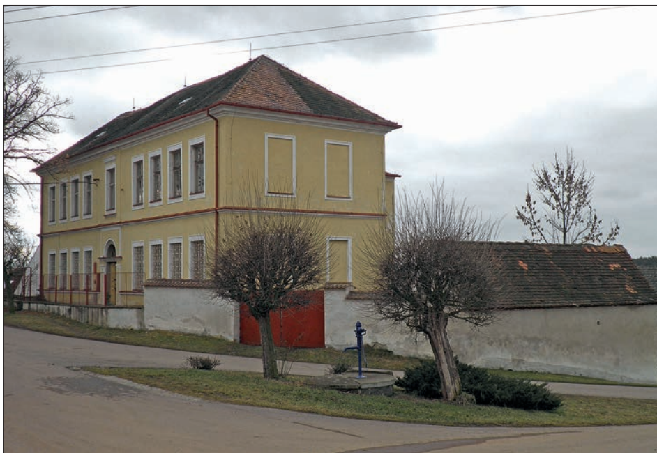
Obr. 24: Břežany, škola čp. 118, současný stav budovy, pohled od severovýchodu.
