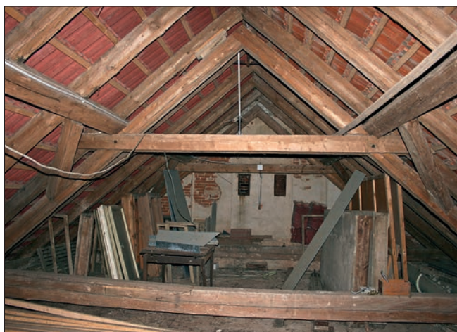
Obr. 25: Slatina (okr. Klatovy), pohled do krovu hlavní budovy.
