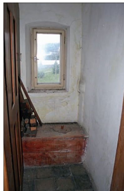
Obr. 23: Břežany, interiér patra, suché záchody umístěné v přístavce (stav 2013).
