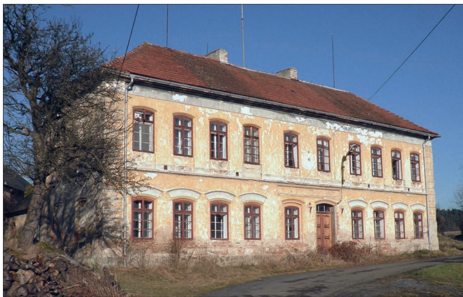
Obr. 16: Těchonice (okr. Klatovy), škola čp. 13, současný stav budovy, pohled od jihu.
