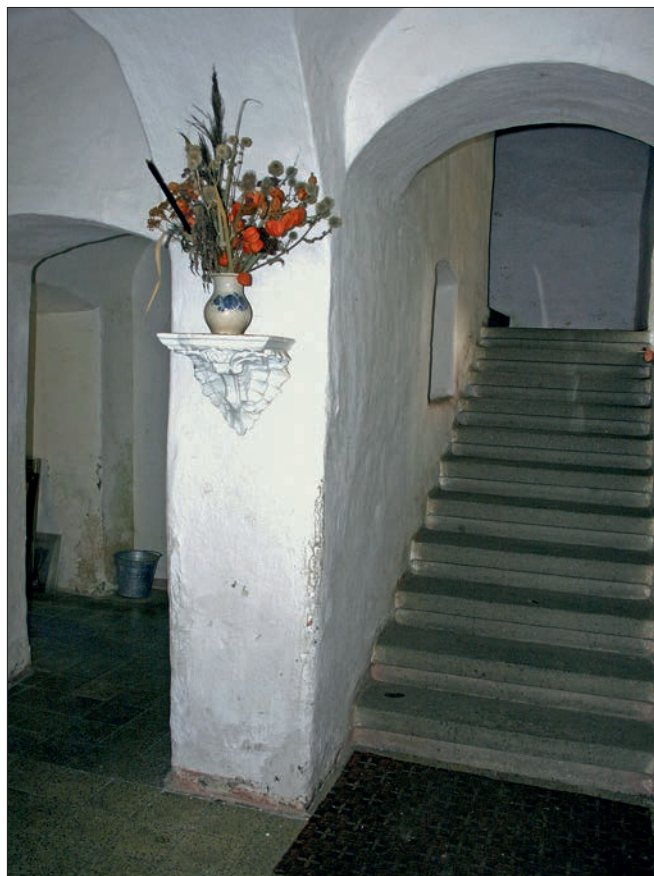
Obr. 11: Kváňovice, škola čp. 37, interiér vstupní síně v přízemí se schodištěm a navazující chodbou.
