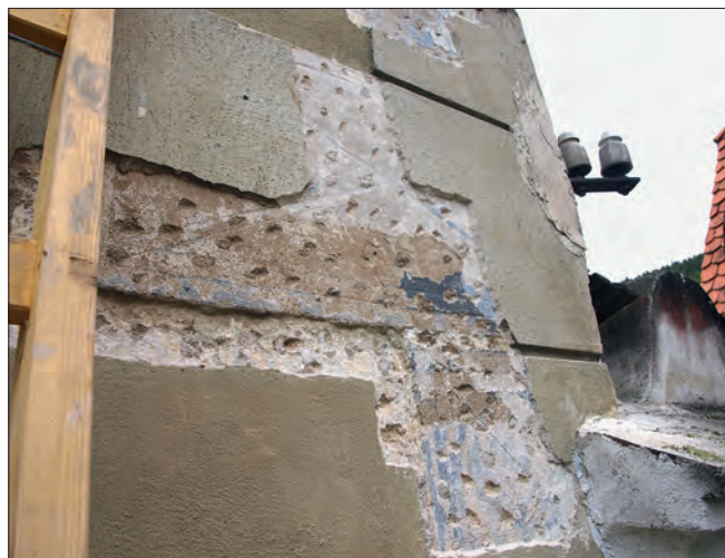
Obr. 12: Staré Dobrkovice, mlýn čp. 1, detail nárožní rustiky jihovýchodního průčelí domu (foto D. Šnejd, 2015).
