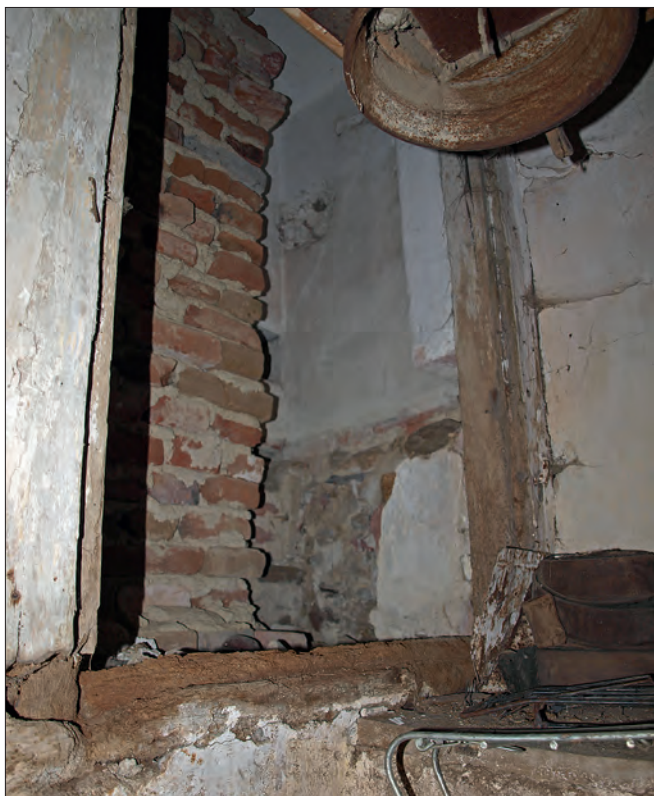
Obr. 20: Staré Dobrušky, mlýn čp. 1, mlýnice, pohled do prostoru záchodu, vpravo je čitelný otisk konstrukce sedací části toalety, odkládací nika a zazděné větrací (?) otvory. Zazdívká vlevo je novodobá (foto D. Šnejd, 2015).
