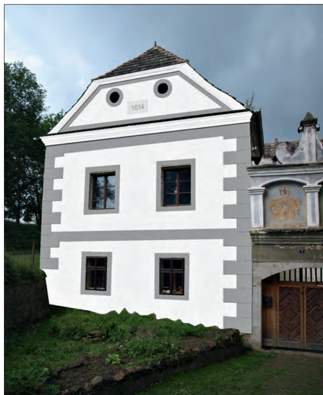
Obr. 11: Staré Dobrkovice, mlýn čp. 1, jihovýchodní průčelí domu, podoba raně barokní úpravy ještě ze 17. století (foto L. Vejvodová, 2015).
