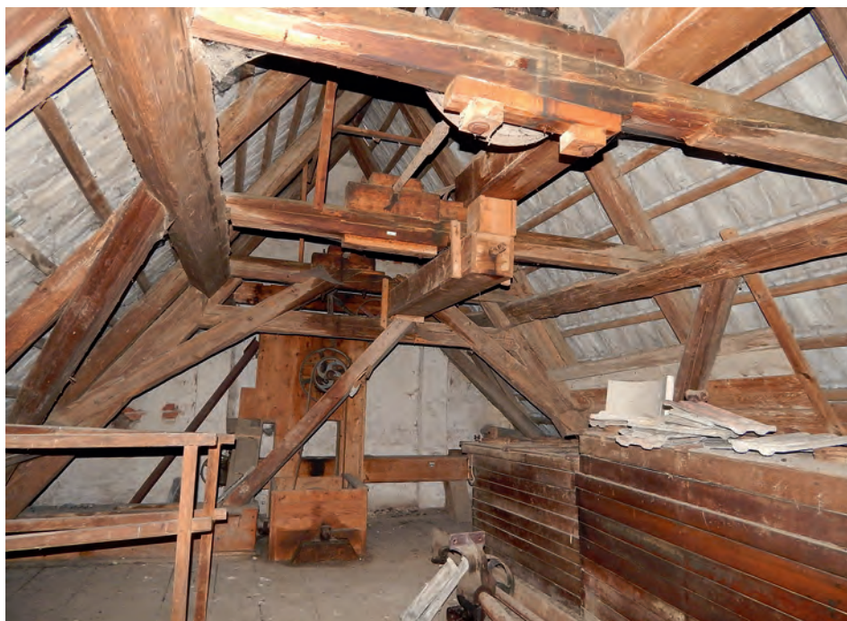
Obr. 21: Staré Dobrkovice, mlýn čp. 1, pohled do podkrovní mlýnice, do konstrukce krovu ze 17. století byla v 1. polovině 20. století vložena technologie uměleckého mlýna (foto J. Bloch, 2015).
