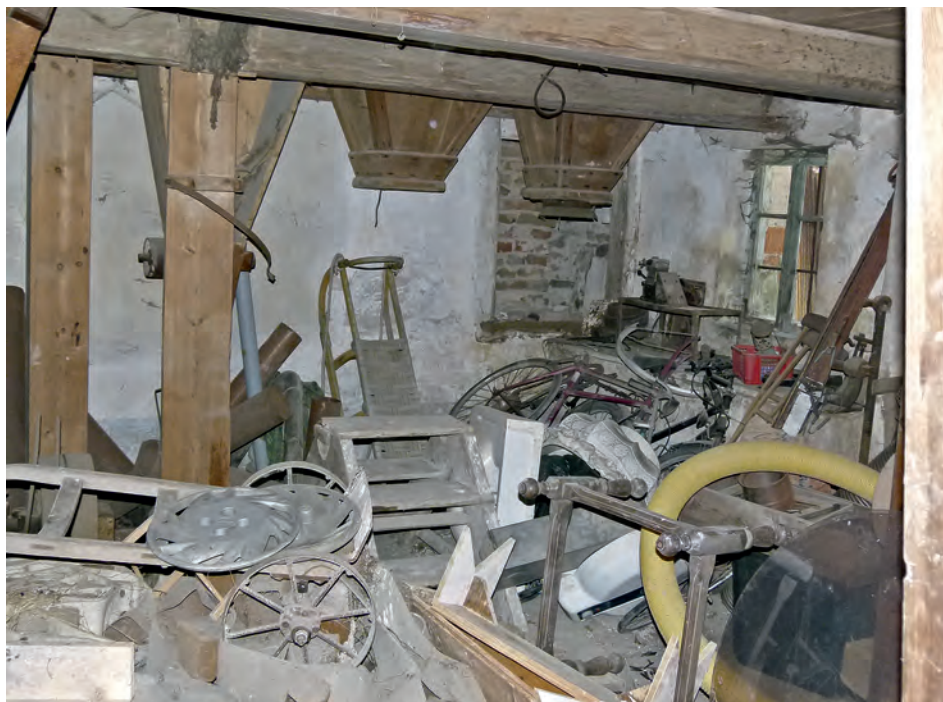
Obr. 19: Staré Dobrušky, mlýn čp. 1, interiér v prvním patře mlýnice, práh vstupu na záchod a blok zdiva pod oknem vpravo ukazují úroveň horní podlahy mlýnské hranice, která stála při návodní zdi. Stávající okno je vybouráno v parapetním zdivu okna ze 17. století, okenní nika si uchovála původní podobu (foto J. Hansová, 2015).
