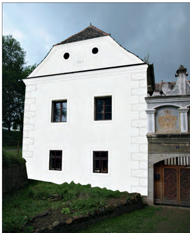
Obr. 10: Staré Dobrkovice, mlýn čp. 1, jihovýchodní průčelí domu, podoba pozdně renesanční úpravy z počátku 17. století (foto L. Vejvodová, 2015).
