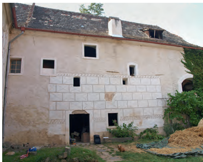
Obr. 13: Staré Dobrkovice, mlýn čp. 1, dvorní průčelí mlýnice, vpravo je viditelná analyticky naznačená spára v místě rozhraní etapy z 16. a počátku 17. století (foto D. Šnejd, 2015).
