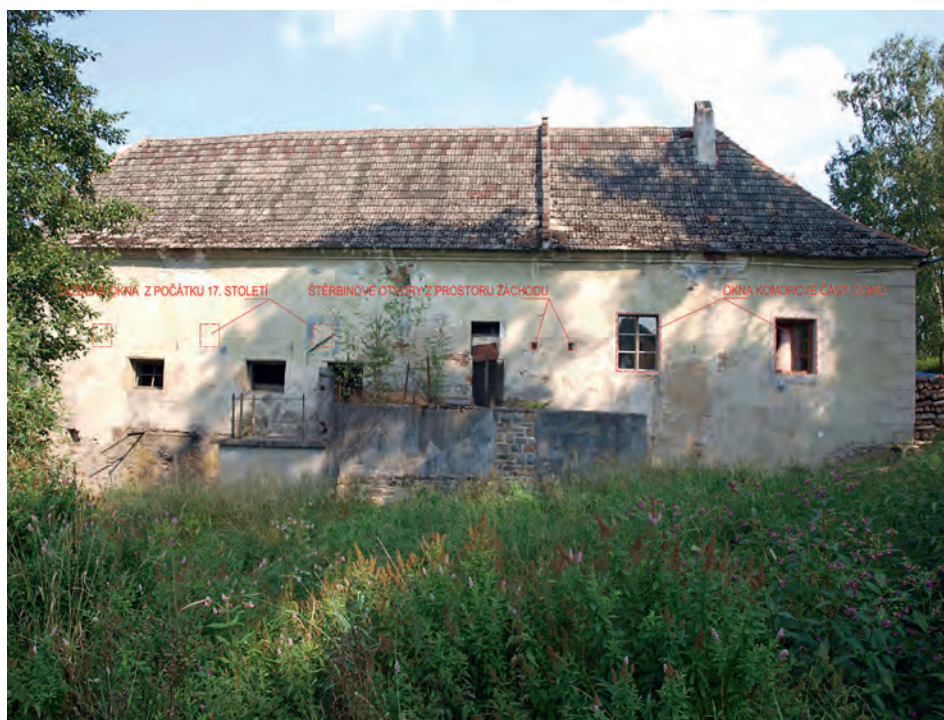
Obr. 14: Staré Dobrkovice, mlýn čp. 1, pohled od západu na část návodní (sz) strany mlýnice a přilehlé průčelí domu s vyznačenými nálezy (foto D. Šnejd; kresba L. Vejvodová, 2015).
