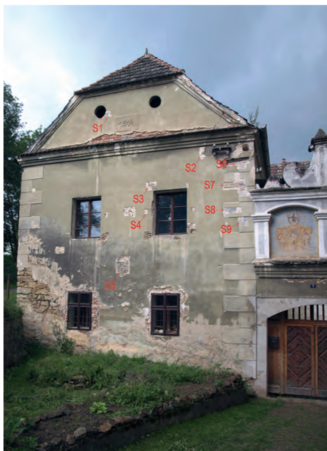
Obr. 9: Staré Dobrkovice, mlýn čp. 1, jihovýchodní průčelí domu se zákresem sond, současný stav (foto D. Šnejd, 2015).
