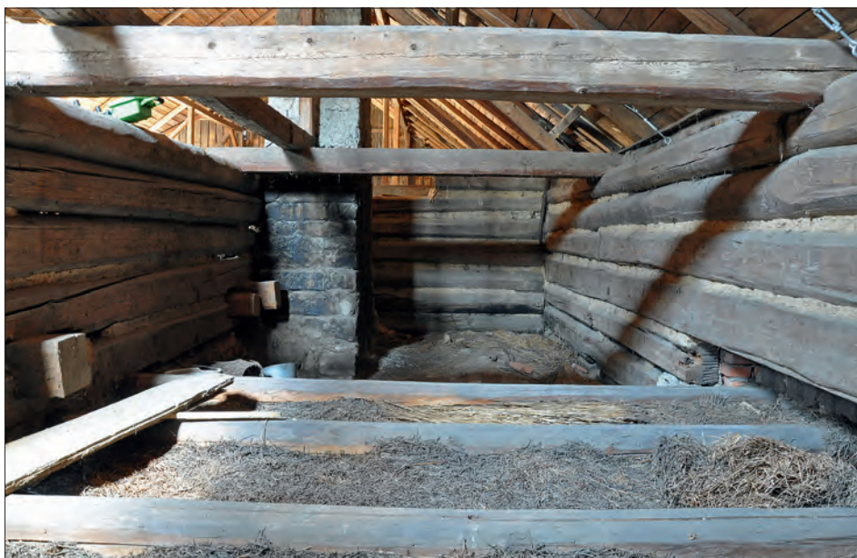
Obr. 25: Frýdštejn, usedlost čp. 21 – prostor nad druhým traktem obytného dílu, pohled od jihovýchodu. V popředí stropní trámy světničky, v pozadí vložené mladší těleso dymníku a klenba černé kuchyně (foto T. Konvalinková, srpen 2015).
