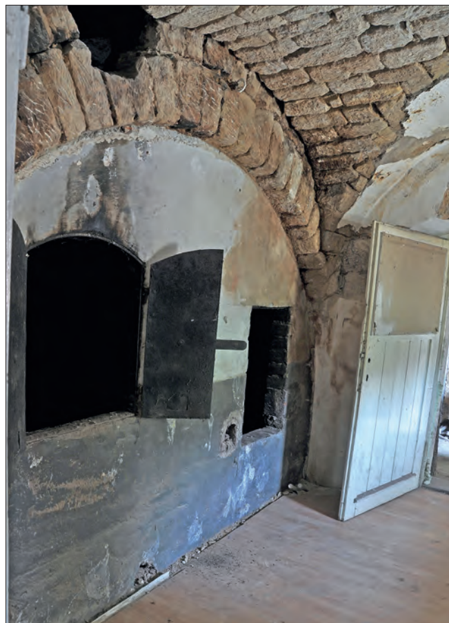
Obr. 17: Frýdštejn, usedlost čp. 21 – černá kuchyně, mladší zazdívka nízký topeniště (foto M. Ouhrabka, srpen 2015).
