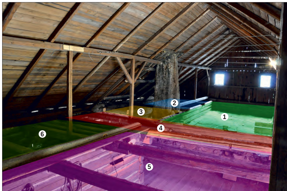
Obr. 31: Frýdštejn, usedlost čp. 21 – grafické znázornění původní dispozice obytné části a patra: 1 – světnice; 2 – světnička; 3 – kuchyně; 4 – síň; 5 – jihozápadní komora; 6 – severovýchodní komora (foto M. Ouhrabka, červenec 2015).
