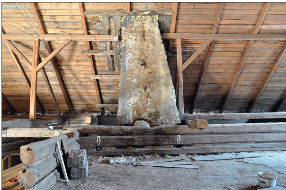
Obr. 24: Frýdštejn, usedlost čp. 21 – horní průběh mezitraktové stěny obytného dílu, šipkami vyznačeny stopy po konstrukci dřevohlíněného dymníku (foto T. Konvalinková, srpen 2015).
