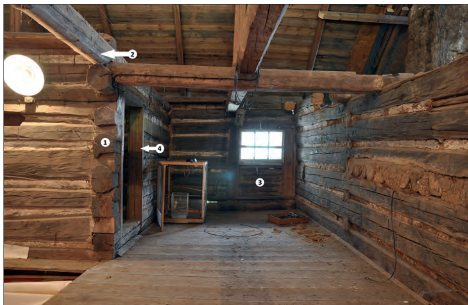
Obr. 20: Frýdštejn, usedlost čp. 21 – síň v patře pohled od jihozápadu: 1 – druhotně seříznutá roubená stěna mezi síní a komorou; 2 – horní průběžný stropní trám komory s dochovaným otiskem vápenného nátěru po vymazávce spáry; 3 – druhotně zaslepený vstupní otvor na pavlač, která zpřístupňovala severovýchodní komoru; 4 – následně vyříznutý dveřní otvor pro zpřístupnění severovýchodní komory přímo ze síně (foto M. Ouhrabka, červenec 2015).
