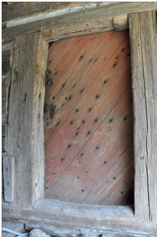
Obr. 13: Frýdštejn, usedlost čp. 21 – detail vstupu jihozápadní komory (foto M. Ouhrabka, červenec 2015).
