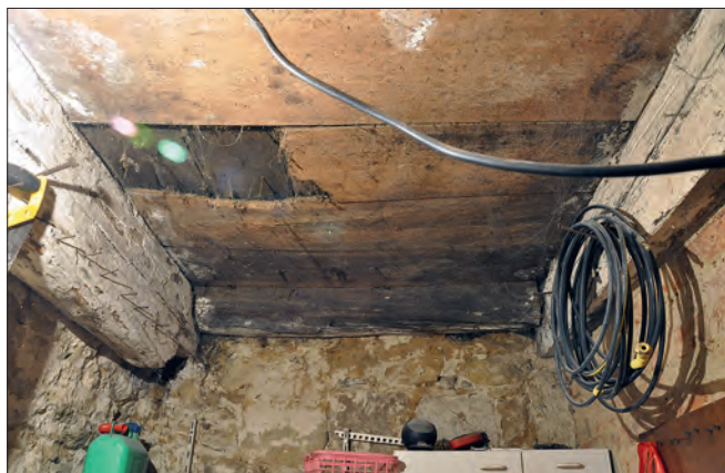
Obr. 18: Frýdštejn, usedlost čp. 21 – boční prostor síně, dochovaný stropní trám a část obvodové stěny původního roubeného chléva (foto M. Ouhrabka, červenec 2015).
