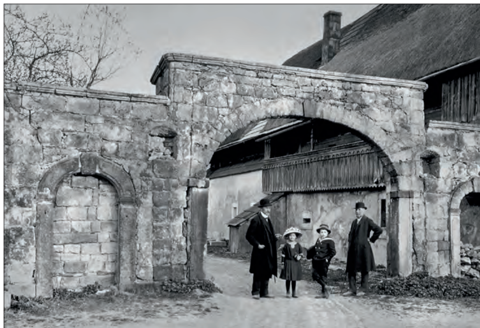
Obr. 3: Frýdštejn, usedlost čp. 21, pohled od severu, přelom 19. a 20. století. Na historickém snímku je dobře patrný průběh severozápadní pavlače a obvodové zdivo obytného dílu předstupující před dochovaným roubeným věncem polopatra (soukromá sbírka, nedatováno).
