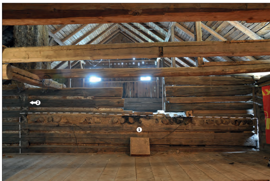
Obr. 22: Frýdštejn, usedlost čp. 21 – pohled na roubený blok obytné části z horní síně: 1 – prostor světnice s povalovým stropem; 2 – horní průběh roubené mezitraktové stěny, vymezující světnici od černé kuchyně a světničky (foto M. Ouhrabka, červenec 2015).
