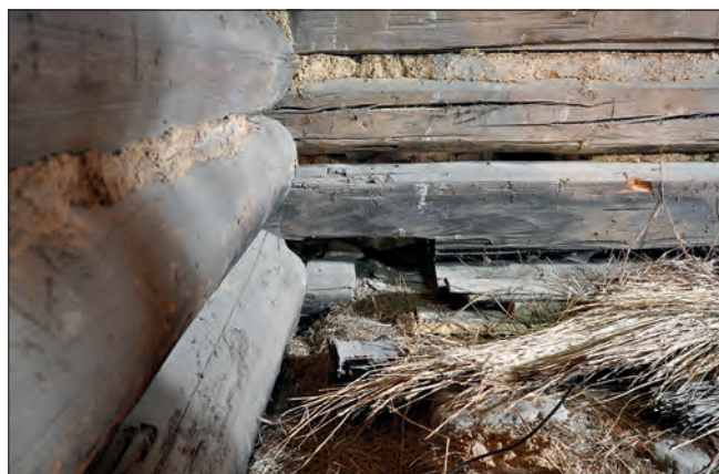
Obr. 27: Frýdštejn, usedlost čp. 21 – detail kapsy po pruku dřevohlíněného dymníku označený v předchozím snímku 1a (foto M. Ouhrabka, červenec 2015).
