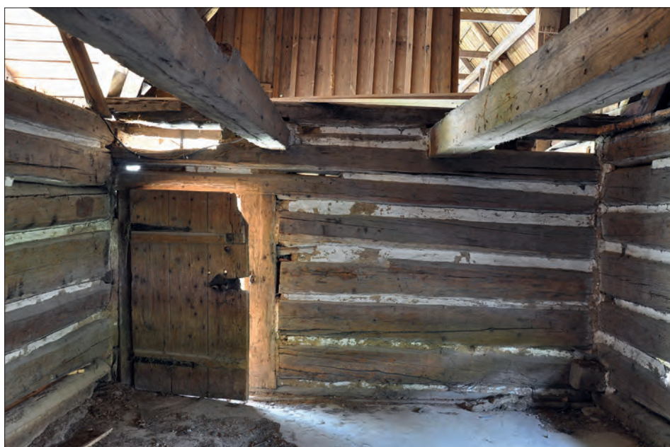
Obr. 29: Frýdštejn, usedlost čp. 21 – interiér jihovýchodní komory (foto M. Ouhrabka, červenec 2015).
