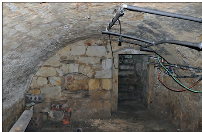
Obr. 19: Frýdštejn, usedlost čp. 21 – interiér sklepa (foto M. Ouhrabka, červen 2012).
