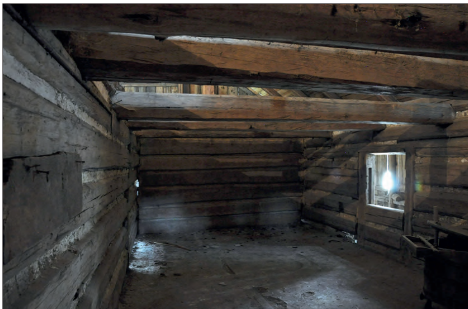
Obr. 28: Frýdštejn, usedlost čp. 21 – interiér severovýchodní komory s druhotně zaslepenými dveřmi na pavlač a skříšší za vloženou přepážkou imitující roubení (foto M. Ouhrabka, červenec 2015).
