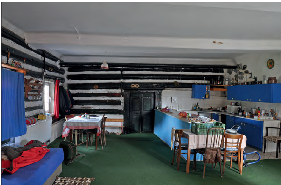
Obr. 14: Frýdštejn, usedlost čp. 21 – světnice, pohled na vstup ze síně a průchod poletnice pod zaomítaným povalovým stropem (foto M. Ouhrabka, srpen 2015).
