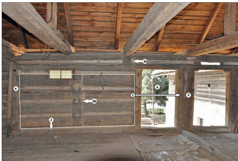
Obr. 21: Frýdštejn, usedlost čp. 21 – situace posunutí části jihozápadní obvodové stěny síně a komory v patře (vyznačeno bílým rámečkem): 1 – označení původního umístění roubené stěny v dlabu zárubně dveřního vstupu (5); 2 – dlab po zárubni dveřního otvoru; 3a – zhlaví uříznutého horního trámu stěny mezi komorou a síní; 3b – posunutá zhlaví trámů seřízlé roubené stěny původně umístěné v úrovni 3a; 4 – původní levá zárubeň vstupních dveří ze síně na pavlač; 6 – druhotný dveřní vstup do síně vzniklý posunutím roubení (foto T. Konvalinková, srpen 2015).
