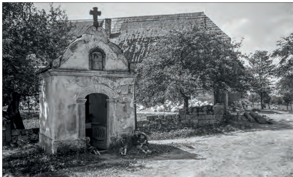
Obr. 4: Frýdštejn, usedlost čp. 21, pohled od severovýchodu, počátek 20. století. Historické podobě střechy dominuje rozměrný kabřinec nad severozápadním štítem. Deponování stavebního materiálu nemá prokazatelnou souvislost se stavebními úpravami domu (fotografická sbírka Severočeského muzea v Liberci, foto R. Ginzel, nedatováno).
