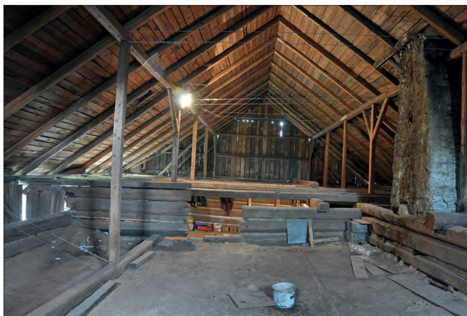
Obr. 23: Frýdštejn, usedlost čp. 21 – celkový pohled do podstřeší od jihovýchodního štítu (foto M. Ouhrabka, červenec 2015).
