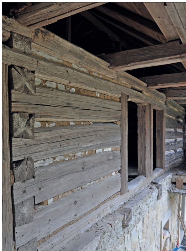
Obr. 12: Frýdštejn, usedlost čp. 21 – jihozápadní průčelí, část obvodové stěny patra. Vstupy do komory a síně v patře byly přístupné po pavlačí, dnes odříznuté a dochované v reliktu. Rybinové spoje v nároží zvýrazňují vápnem malované ondrejské kříže. Okapová vaznice v pravé horní části snímku byla původně umístěna v pozici pozednice (foto M. Ouhrabka, červenec 2015).
