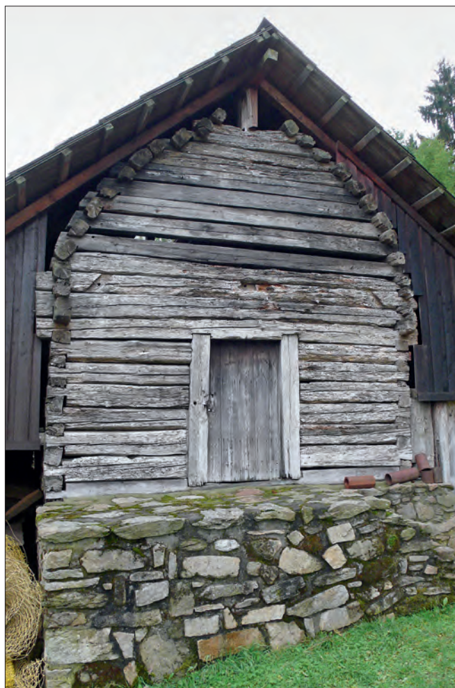
Obr. 2: Chanovice (okres Klatovy), roubená sýpka s klenbou původně stojící na Klatovsku v Petrovicích u Měčína, dnes součást Expozice lidové architektury Muzea Dr. Hostaše v Klatovech.
