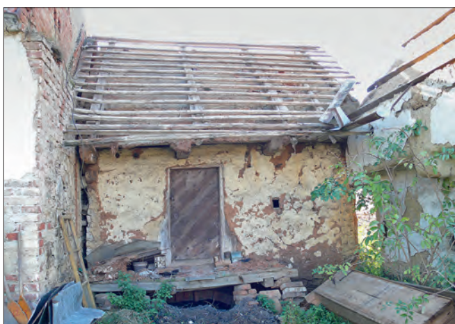
Obr. 8: Močerady, usedlost čp. 21 – severozápadní kout dvora. Pohled na východní (nádvoří) stranu sýpky ležící v linii západní strany statku. Objekt dosud kryje hlinitý lepenec a v ose vstupu lze spatřit klenbu sklepa (stav 2008).
