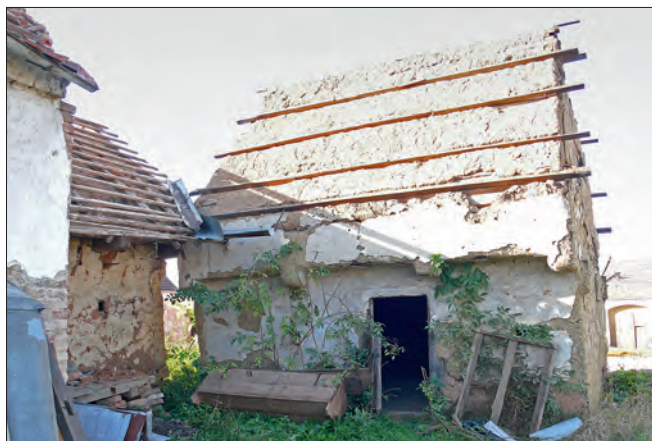
Obr. 10: Močerady, usedlost čp. 21 – severozápadní kout, severní strana. Pohled ze dvora na jižní stranu roubené sýpky z let 1819–1821.
