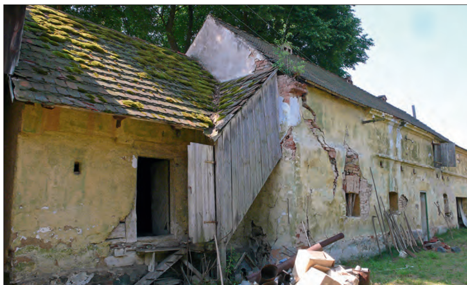
Obr. 18: Neuměř (okres Domažlice), usedlost čp. 2 – pohled od obytného stavení na nádvorní stranu sýpky (vlevo), vybavené hliněným lepenecem. Stav před demolicí přilehlých chlévů.
