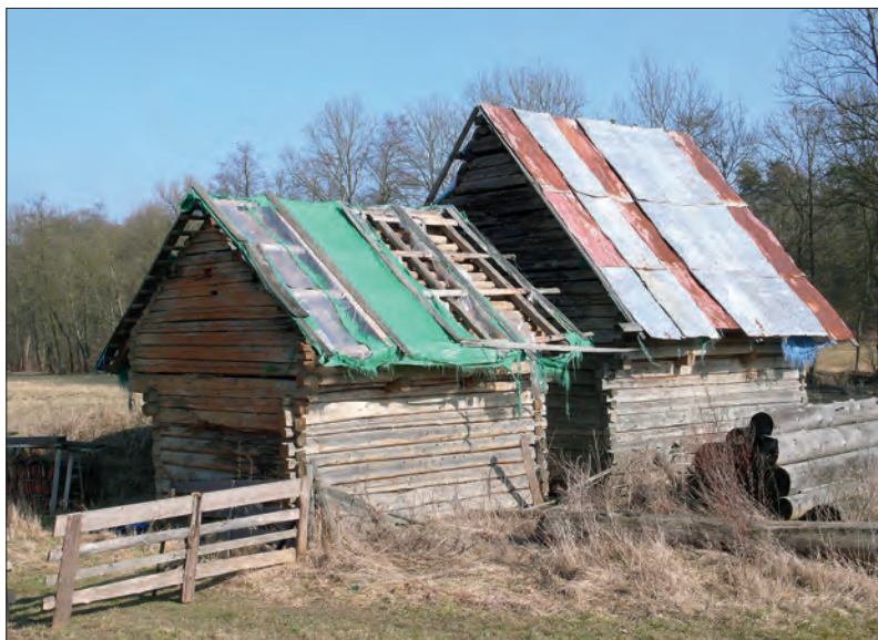
Obr. 19: Ohůčov, roubené sýpky z močeradské usedlosti čp. 21 po přemístění na pozemek ležící při jižním okraji vsi. Pohled od západu. Vlevo sýpka z 80. let 18. století (původně stojící při západní straně usedlosti čp. 21), vpravo sýpka z 1. čtvrtiny 19. století (původně stojící při severní straně dvora Močerady čp. 21).
