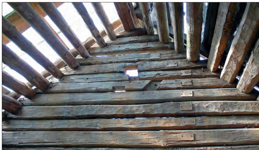
Obr. 17: Ohůčov, roubená sýpka původně situovaná při západní straně usedlosti čp. 21 v Močeradech, datovaná dendrochronologií do období let 1781–1789. Interiér podstřešní komory, část pod hřebenem, stav již bez vnějšího ochranného hliněného lepenice.
