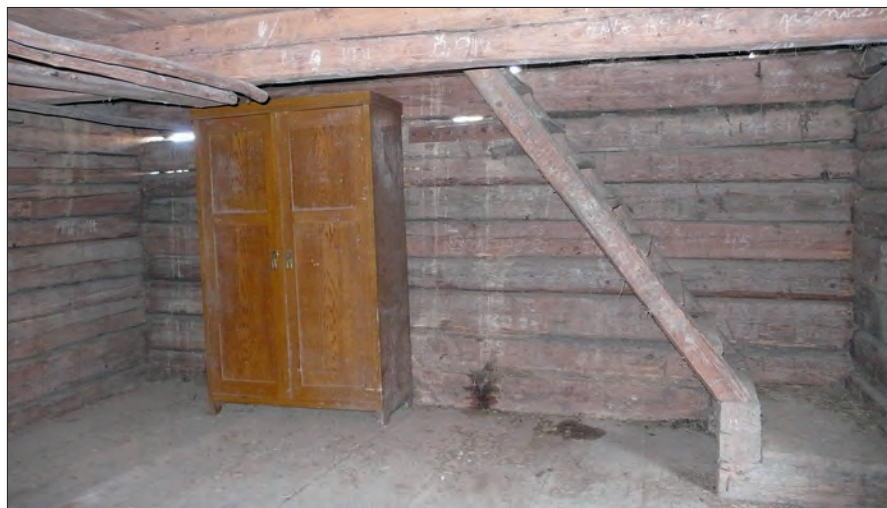
Obr. 13: Močerady, usedlost čp. 21, roubená sýpka při severní straně dvora. Interiér přízemí s žebříkovým schodištěm do podstřešní komory (stav 2008).
