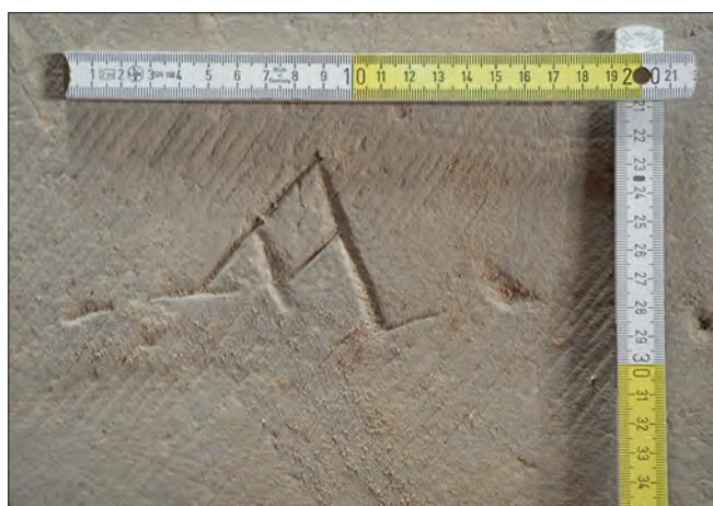
Obr. 9: Bělá pod Bezdězem, klášter: a – pískovcová deska gotického původu druhotně užitá v konstrukci barokní menzy v černé kapli; b – detail kamenické značky se stopami po opracování na horní ploše desky.
