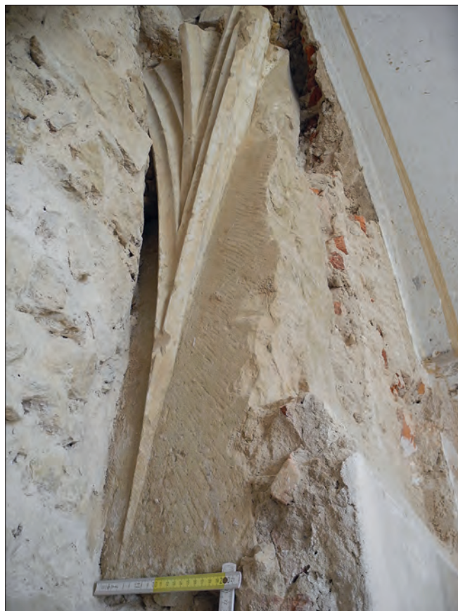
Obr. 5: Bělá pod Bezdězem, klášter – detail výběhu trojice žeber.
