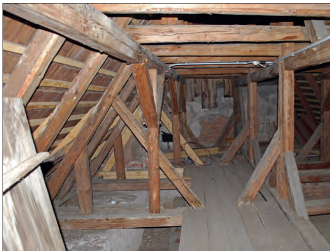
Obr. 9: Jánský Vrch, zámek, pohled do krovu severozápadního křídla.
