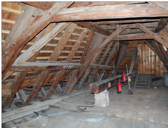
Obr. 10: Jánský Vrch, zámek, pohled do krovu severního renesančního paláce.
