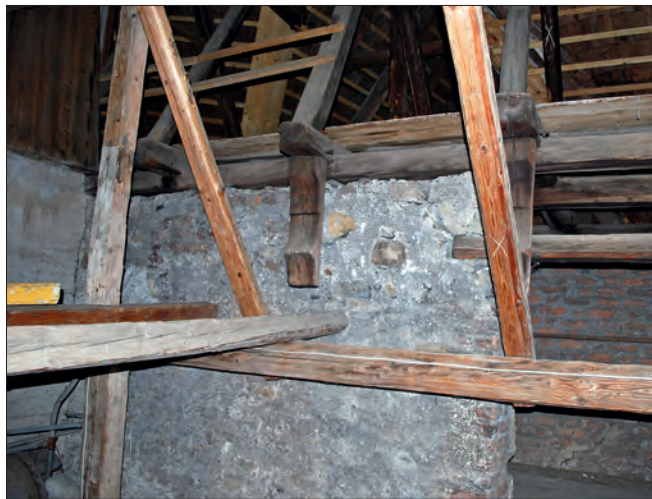
Obr. 7: Janský Vrch, zámek, detail krovu obranné chodby s prvky zarážek.
