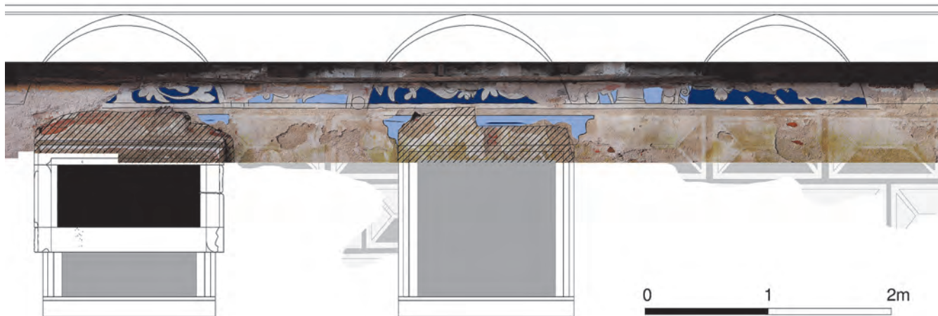
Obr. 4: Orlice, zámek – jižní fasáda, fragment lunetové římsy a nadokenních říms fáze REN2b. Zvýrazněny plochy s barevnými úpravami (fotoplán E. Racková, 2011).
