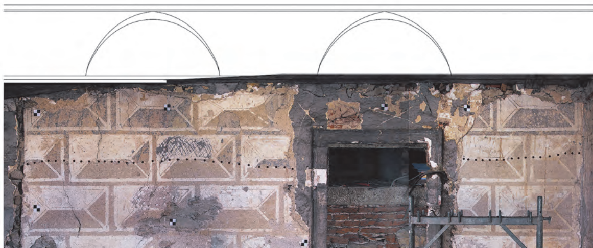
Obr. 7: Orlice, zámek – severní fasáda, západní část segmentu mezi rizality. Iluzivní stín lunetové římsy (fotoplán E. Racková, 2012).
