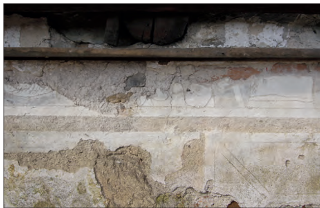
Obr. 6: Orlice, zámek – jižní fasáda, fragment lunetové římsy a nadokenní římsy. Na nadokenní římsě vlevo zbytky barevné úpravy ve světlejším tónu, tmavší linie naznačující profilaci. Výše vlevo fragment lunety, uprostřed náběh fabionu, upravo patka sloupu (foto E. Racková, 2011).
