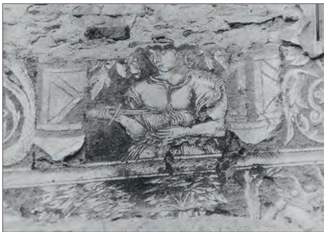
Obr. 3: Orlice, zámek – jižní fasáda, Sebevražda Lukrécie, po 1565. Na fotografii je zachyceno sgrafito REN1 před sejmutím a deponováním. Figura je anatomicky mírně deformovaná, ale řemeslná úroveň provedení je velmi vysoká. V plochách pod příložkami dřevěného patra REN1 zachováno sgrafito REN2c. Rytmus příložek dřevěného patra REN2 byl jiný, sgrafito REN2c původně výjev částečně překrývalo (foto J. Slavík, 1991).
