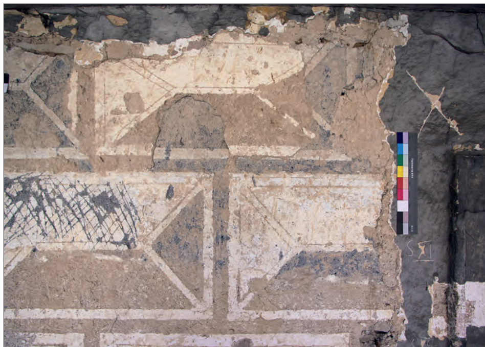
Obr. 8: Orlice, zámek – severní fasáda, západní část segmentu mezi rizality, druhá etapa druhé renesanční fáze (REN2b). První řada psaníček pod římsou se zbytkem překryvu psaníčky poslední etapy (REN2c), na plnohodnotnou sgrafitovou omítku navazuje žlutavé intonaco bianco převrstvující zbytek fasády. Ve spáře mezi omítkami na hranici šedé a okrové zbytky neodrytého intonaca naneseného v prvním kroku na tmavě šedou omítku.
