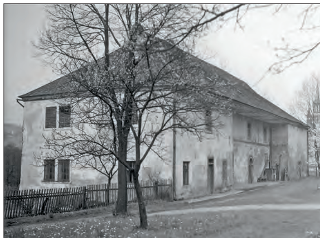
Obr. 1: Orlice (okres Ústí nad Orlicí), zámek – pohled od SZ. Stav objektu před devastujícími stavebními úpravami a celkovým zchátráním fasády (foto Tuháček, 1967; fotoarchív NPÚ ÚOP v Pardubicích, č. negativu n13561).
