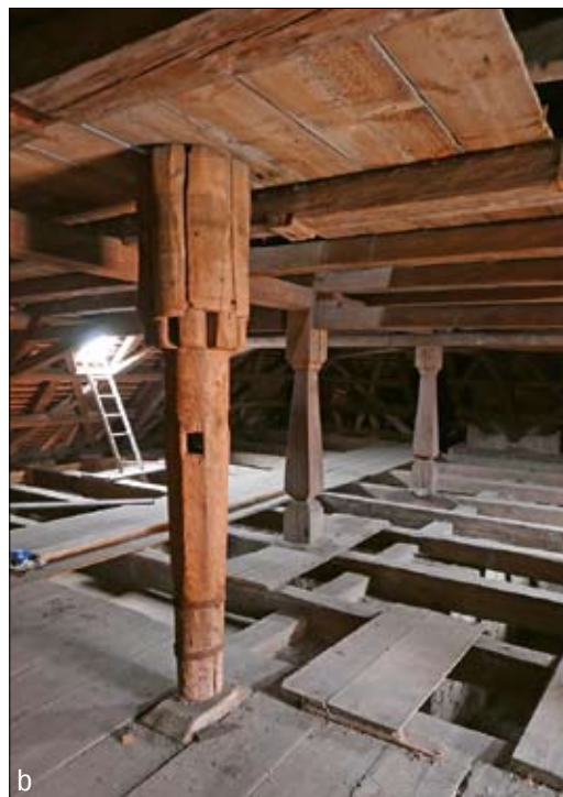
Obr. 52: Chlum sv. Maří – probošství, půdní prostor nad hlavním křídlem: a – schéma plné vazby nepravého mansardového krovu středního pavilonu; b – pohled do prostoru mansardy na barokní vrátek a dva vyřezávané sloupky. Náročné uměleckořemeslné provedení detailů i dochované technické prvky dělají ze zdejších barokních krovů památku unikátní nejen v kontextu Čech (foto a kresba P. Macek, 2015).
