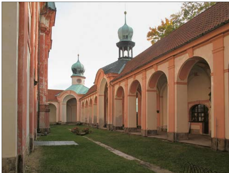
Obr. 32: Chlum sv. Maří – ambit, celkový pohled z nádvoří areálu jihovýchodním směrem (foto P. Priknerová, 2015).
