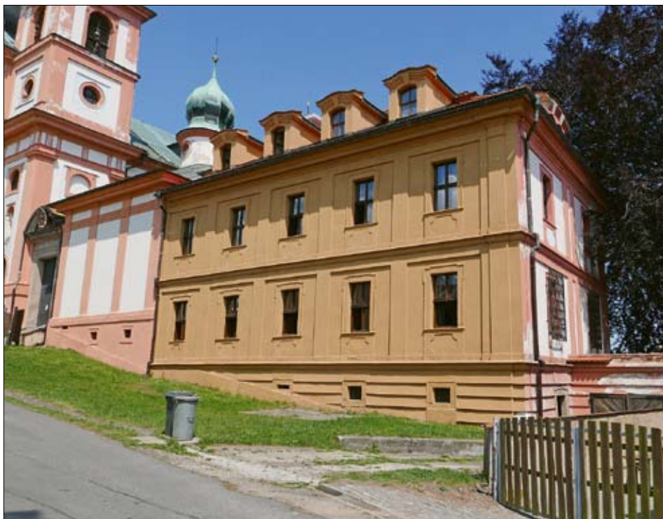
Obr. 53: Chlum sv. Maří – bývalá škola, exteriér, pohled na západní fasádu (foto P. Macek, 2015).
