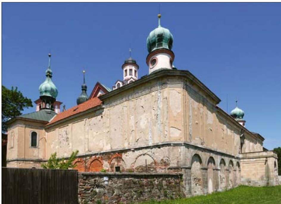
Obr. 31: Chlum sv. Maří – ambít, celkový pohled na exteriér jihovýchodního nároží (foto J. Bachtík, 2015).
