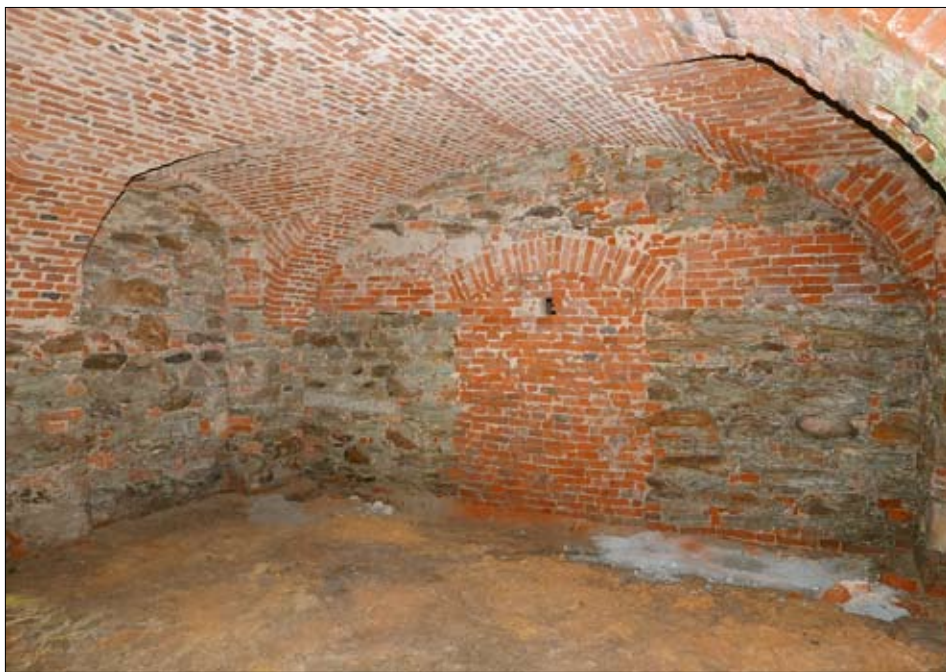
Obr. 50: Chlum sv. Maří – probošství, pohled do prostorů přízemí. Vzhledem k terénní konfiguraci slouží přízemí probošství jako suterén. Většina zdejších konstrukcí proto nikdy nebyla omítána nebo jinak zdobena – celé prostory se tak nacházejí v autentickém stavu dokládajícím postupy barokního zednického řemesla (foto P. Macek, 2015).
