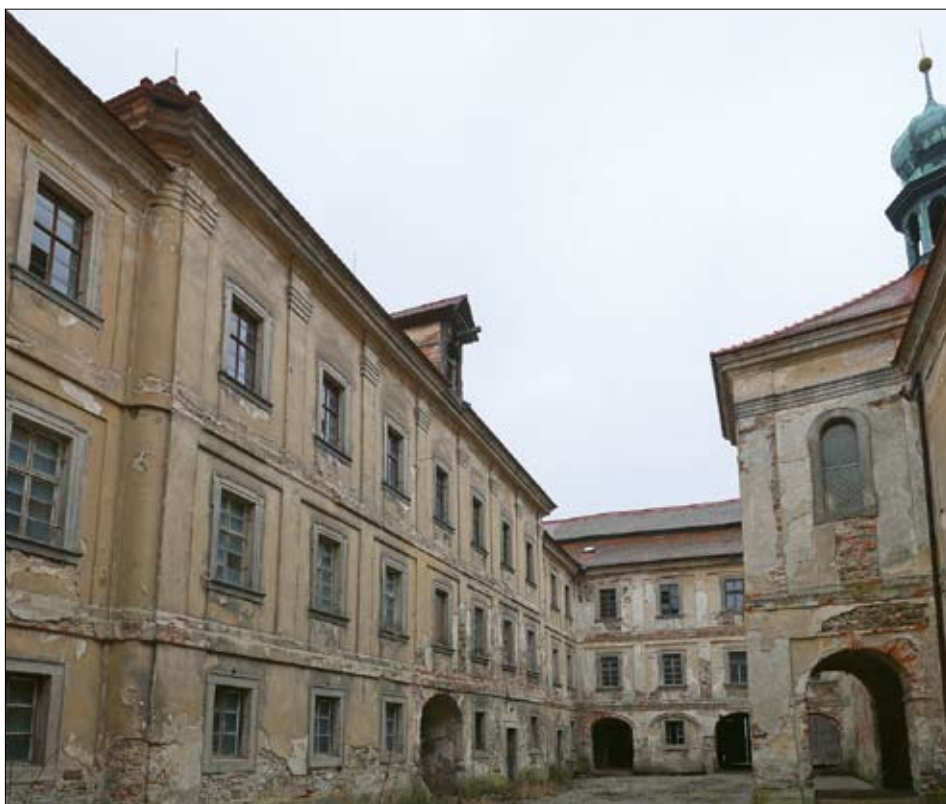
Obr. 47: Chlum sv. Maří – proboštství, pohled do nádvoří. Vpravo vnější severní fasáda ambitu s rizalitem boční kaple (foto P. Macek, 2015).
