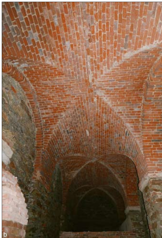
Obr. 45: Chlum sv. Maří – ambit, suterén: a – v severním křídle ambitu zaujmou netypické „vějířové“ klenby; b – pro srovnání typické dobové křížové klenby, použité ve východním křídle suterénu (foto P. Macek).
