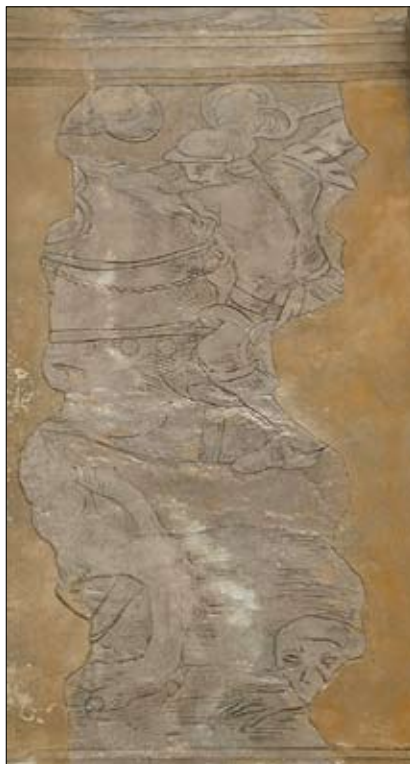
Obr. 8: Hrubá Skála – zámek, renovovaná sgrafitová výzdoba západního křídla, detail.
