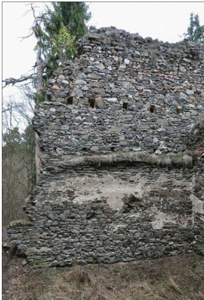
Obr. 17: Budova druhotně vložená do oblouku hradby jádra, západní část interiéru s pohledem k severu (srov. obr. 16). Dole přizemí se zbytkem náběhu valené klenby, nad ním řada druhotných kapes stropu z druhé stavební fáze (2016).
