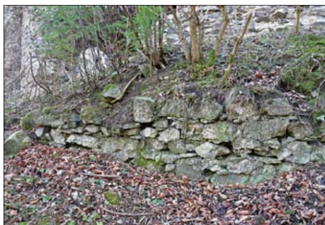
Obr. 53: Tarasní zídka severně od budovy v oblouku hradby hradního jádra, která probíhá zhruba v linii vnějšího líce zaniklé hradby (srov. obr. 27 – půdorys přízemí; 2016).
