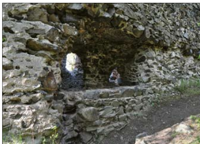
Obr. 14: Budova druhotně vložená do oblouku hradby jádra, detail negativu svislého (dřevěného?) prvku v severní zdi (vlevo dole). Vlevo otisk zaniklé hradby, uprostřed dochovaná část podkopu s průrazy do východní místnosti, vpravo novodobá zazdívká části pásového podkopu (2016).
