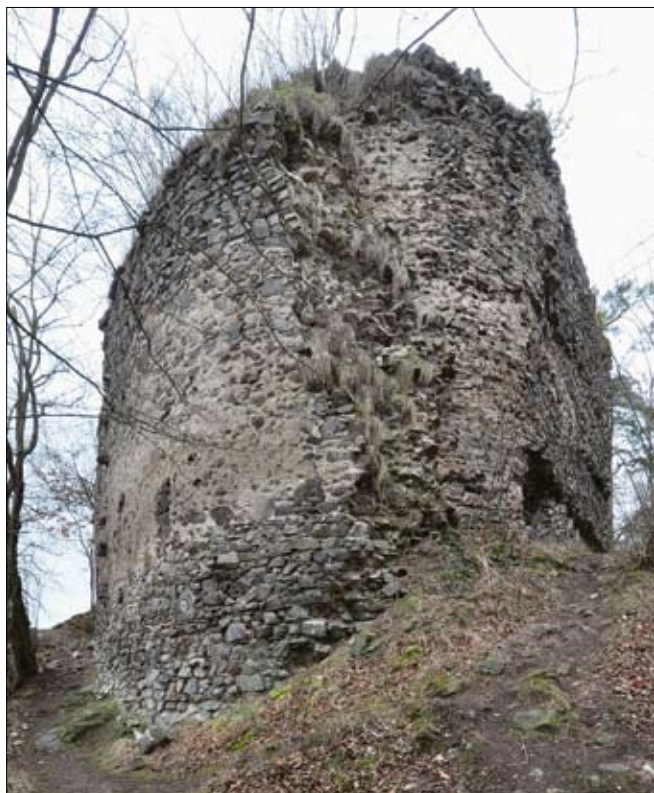
Obr. 9: Oblouková část hradby jádra v pohledu od východu (srov. obr. 5). V pravé části snímku hradba zanikla, a tím došlo k obnažení zdiva druhotně vložené budovy. Zcela vpravo dole vodorovné podkopání zdi budovy, z větší části zazděné po roce 2000 (2016).
