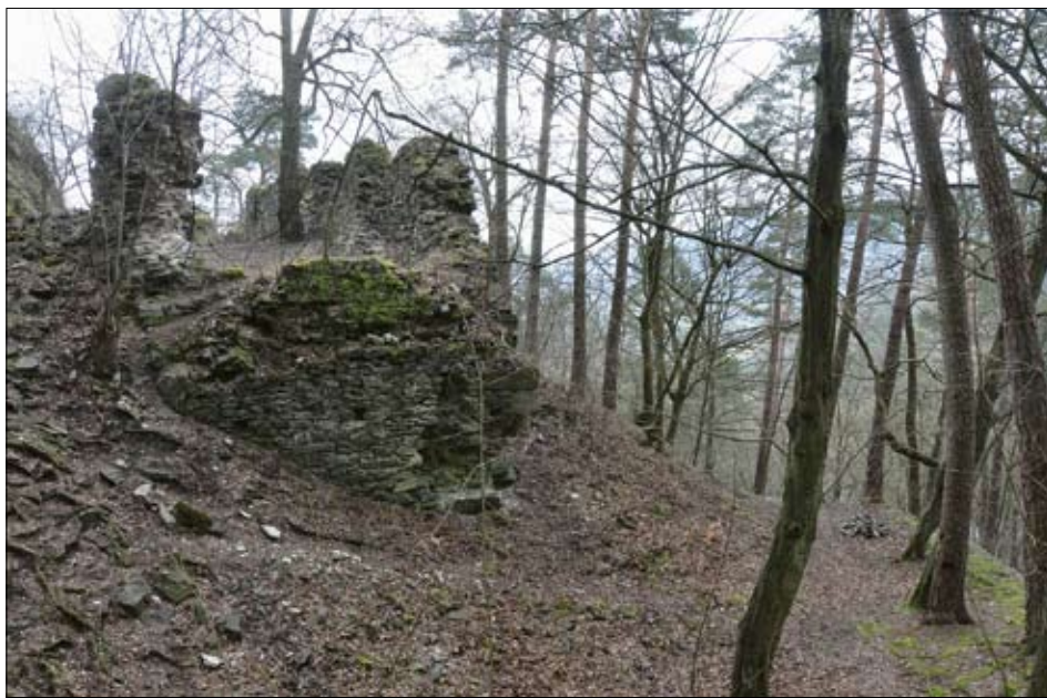
Obr. 44: Hlavní průčelí severozápadní branky v pohledu přes příkop, z konce valu. V pozadí prostor západního parkánu. Vpravo dole terénní „bašta“ v zakončení příkopu (2016).
