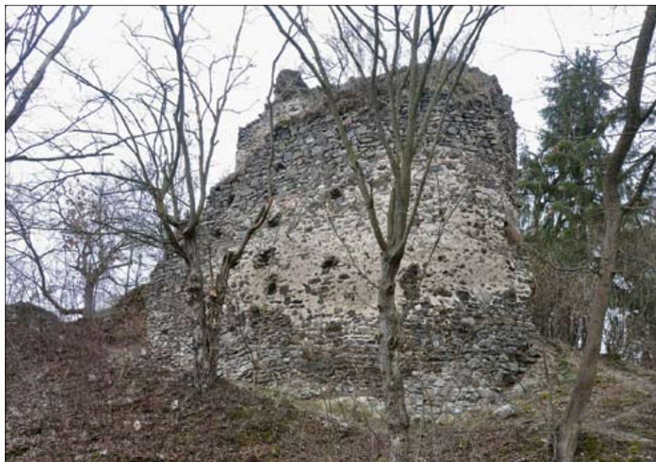
Obr. 5: Dochovaná část obloukové části hradby jádra, pohled od jihovýchodu. V ploše líce se zbytky malty jsou patrné kotvy, které napomáhaly připojení zaniklé přízdívky. Kaverny těsně nad úrovní skalního podloží (srov. obr. 8) byly po roce 2000 zazděny (2016).
