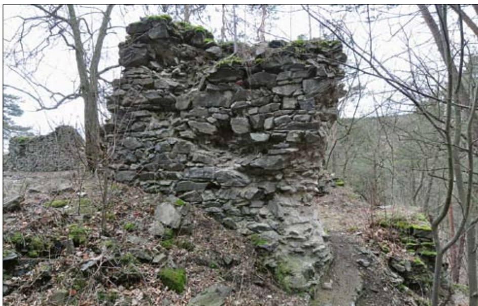
Obr. 45: Východní boční průčelí stejné branky se stopami „šmorců“ pro navázání parkánové zdi (2016).
