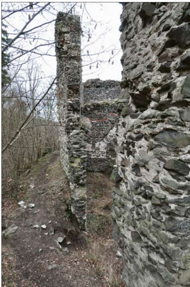
Obr. 15: Budova druhotně vložená do oblouku hradby jádra, pohled na severní obvodovou zeď od západu. Vlevo stála zcela zaniklá hradba, uprostřed průhled do přízemí budovy, vpravo v popředí nelicované zakončení západní obvodové zdi, která na spáru přiléhala k hradbě (2016).
