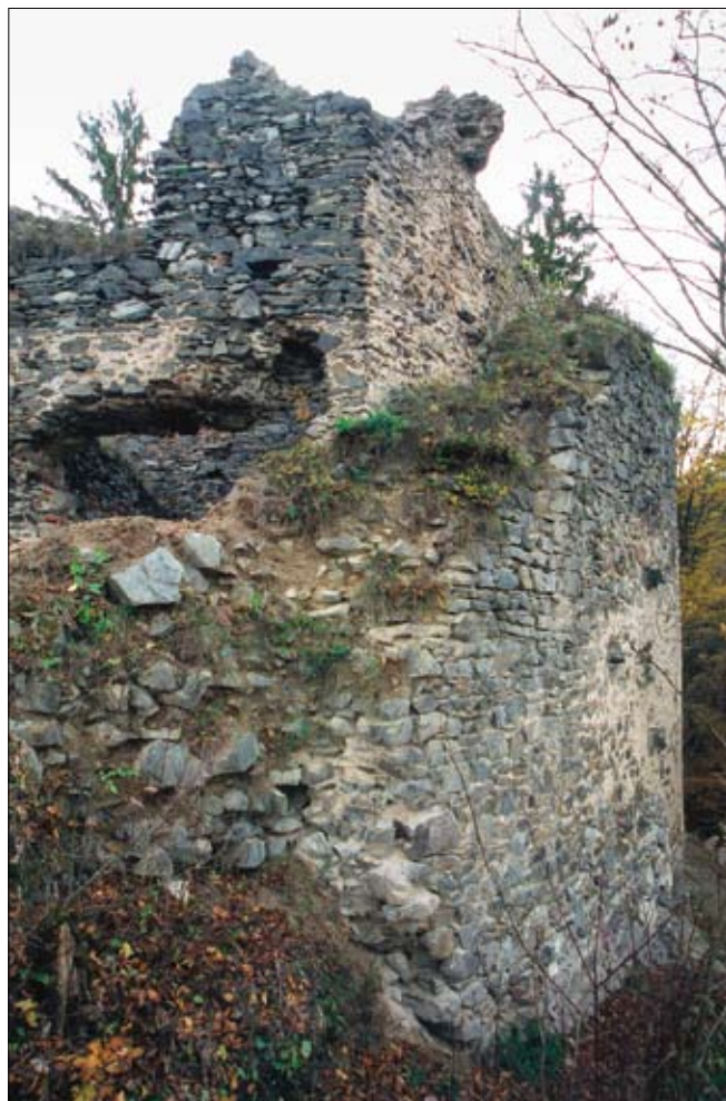
Obr. 10: Oblouková část hradby jádra v pohledu od jihu. Vpravo líc s kotvami (srov. obr. 5–9), v popředí zbytek navazujícího přímého (východního) úseku hradby. Nahoře část druhotně vestavěné budovy – vlevo jižní průčelí s vylámaným oknem východní místnosti, vpravo nelicovaný rub východní zdi, obnažený v důsledku zániku horní části starší hradby (2001).
