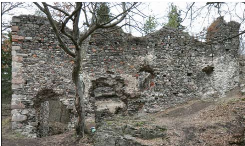
Obr. 11: Jižní průčelí budovy druhotně vložené do oblouku hradby jádra. Vpravo dvě okna přízemí, vlevo vchody do přízemí a sklepa. Nahoře stopy tří otvorů 1. patra (2016).
