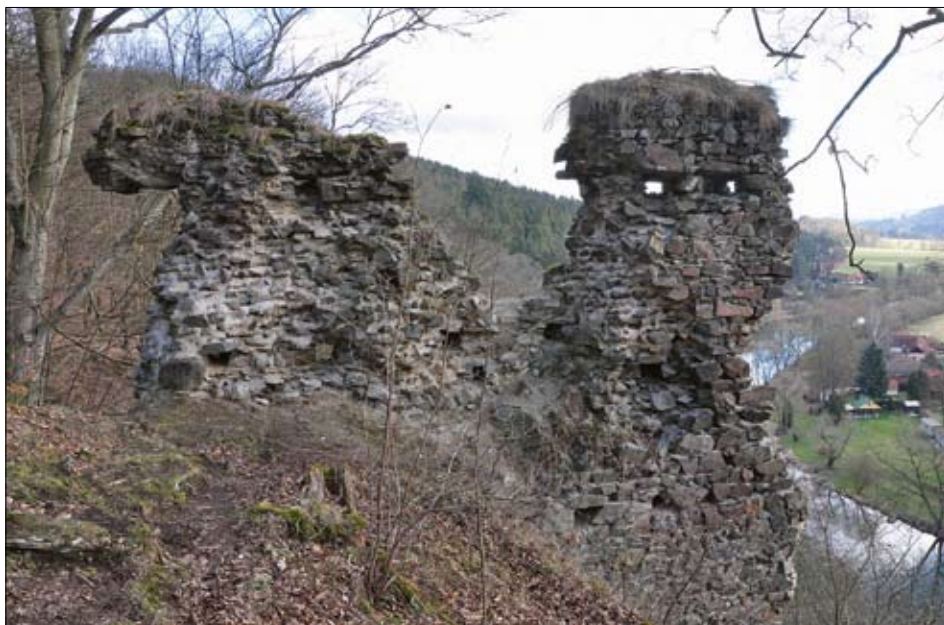
Obr. 34: Úsek parkánové zdi se stopami ochozu, vnitřní strana v pohledu od západu. Vpravo nahoře dva otvory po radiálně uložených nosnících (2016).
