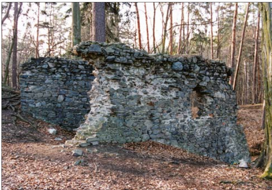
Obr. 38: Severní brána parkánu v pohledu od jihovýchodu, stav před opravou po roce 2000. Ve východní zdi nahoře několik prakových projektílů (2001).
