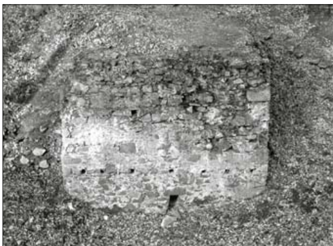
Obr. 41: Zděné předmostí severní brány parkánu v pohledu přes příkop (1999).
