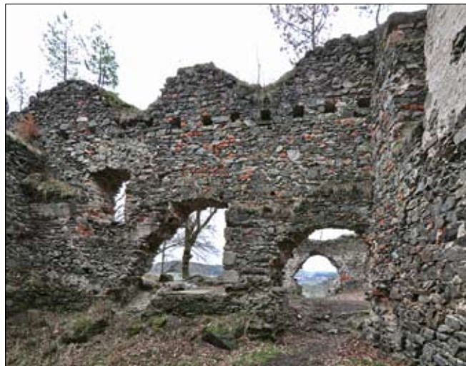
Obr. 18: Budova druhotně vložená do oblouku hradby jádra, západní část interiéru s pohledem k jihu. Vpravo dole otvor na místě vchodu do sklepa, uprostřed vchod do přízemí (vlevo dole zbytek okénka do sklepa), vlevo okénko přízemí (vlevo od něj zbytek náběhu valené klenby). Téměř celá tato jižní zeď budovy byla vystavěna ve druhé stavební fázi, kdy zde také vznikl trámový strop. První fázi náleží jen část zdi s okénkem vlevo, včetně několika kapes stropu nad ním (2016).
