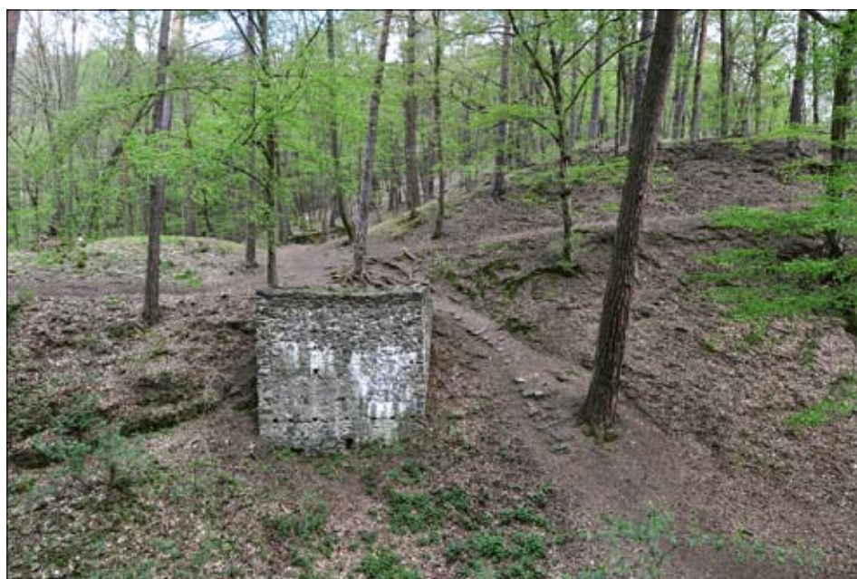
Obr. 50: Pohled ze severní parkánové brány přes příkop. Vlevo od zděného předmostí nižší val s širokým temenem, vpravo úsek vyššího valu s úzkým ostrým temenem (2016).
