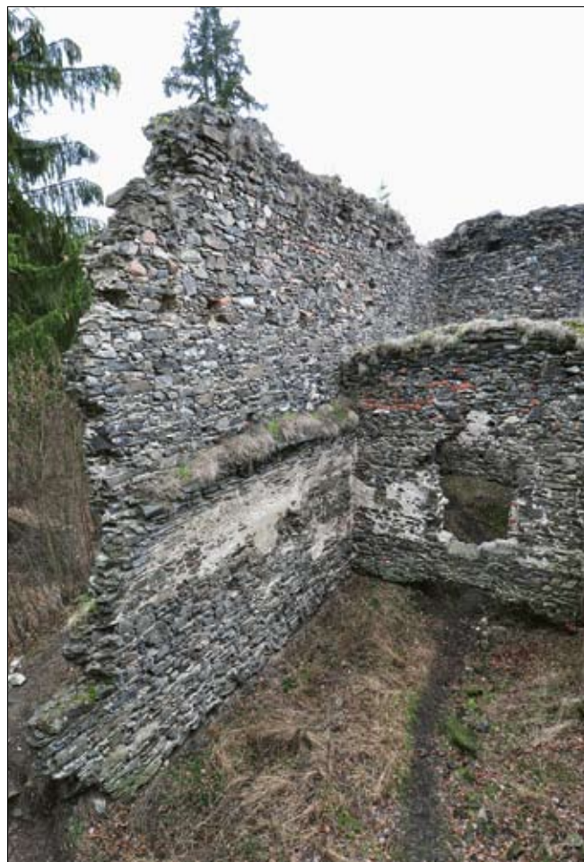
Obr. 16: Budova druhotně vložená do oblouku hradby jádra, západní část interiéru s pohledem k severovýchodu (srov. obr. 17). Vpravo dělicí zeď mezi místnostmi v přízemí, s průchodem. Pod průchodem chybějící zdi-vo na místě zaniklé klenby sklepa. Zeď byla zvýšena po zániku valené klenby přízemí (2016).
