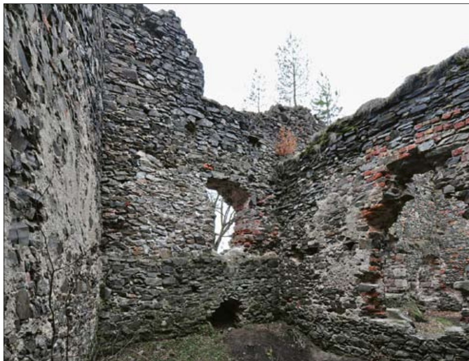
Obr. 22: Budova druhotně vložená do oblouku hradby jádra, východní část interiéru s pohledem k jihozápadu. Na jižní stěně dole okénko zaniklého sklepa, výše okno přízemí (vlevo od něj vyzdívka po roce 2000), nahoře stopy okna nebo vchodu. Vpravo příčka s průchodem mezi místnostmi přízemí (2016).
