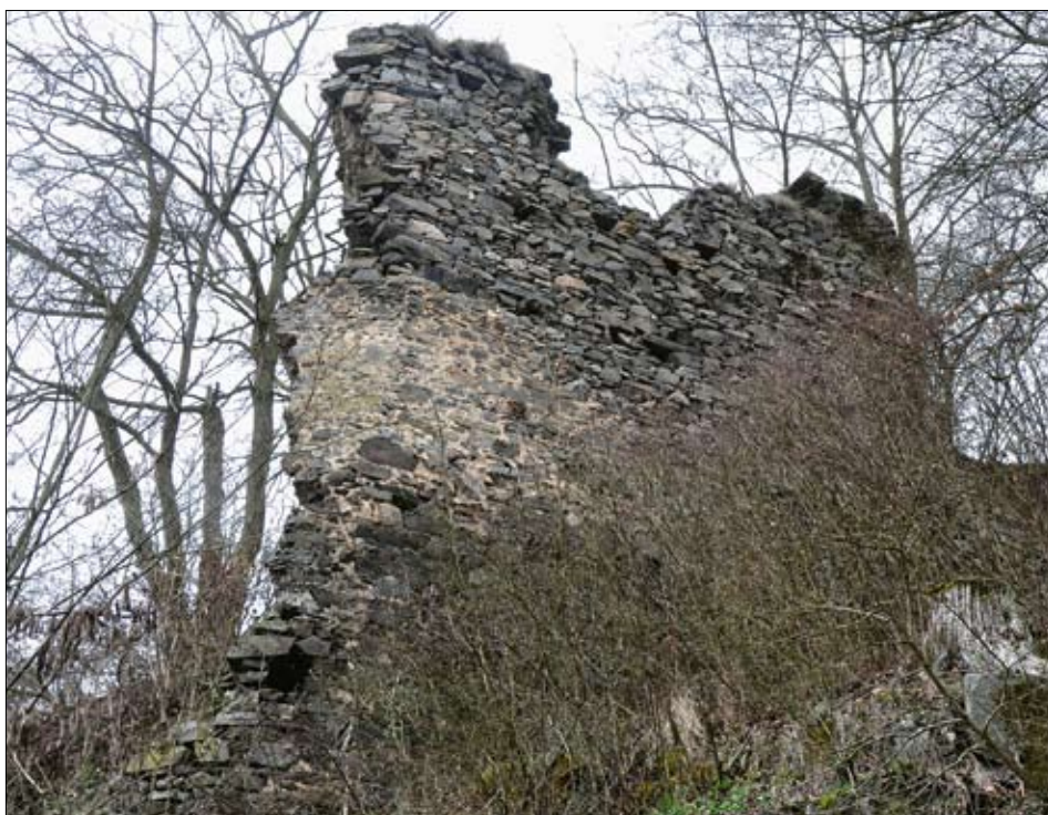
Obr. 33: Vnější líc úseku parkánové zdi se stopami ochozu (srov. obr. 32) v pohledu od jihovýchodu. Vlevo nepravidelně zaoblené nároží (2016).
