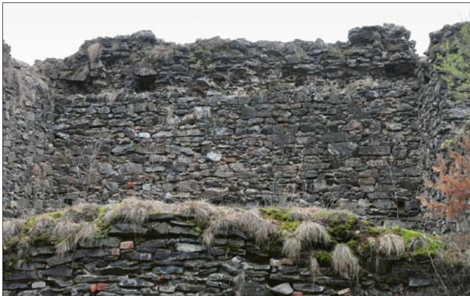
Obr. 24: Budova druhotně vložená do oblouku hradby jádra, východní část interiéru, detail horní části východní stěny s otvory nejasného původu a účelu. V popředí koruna příčky (2016).
