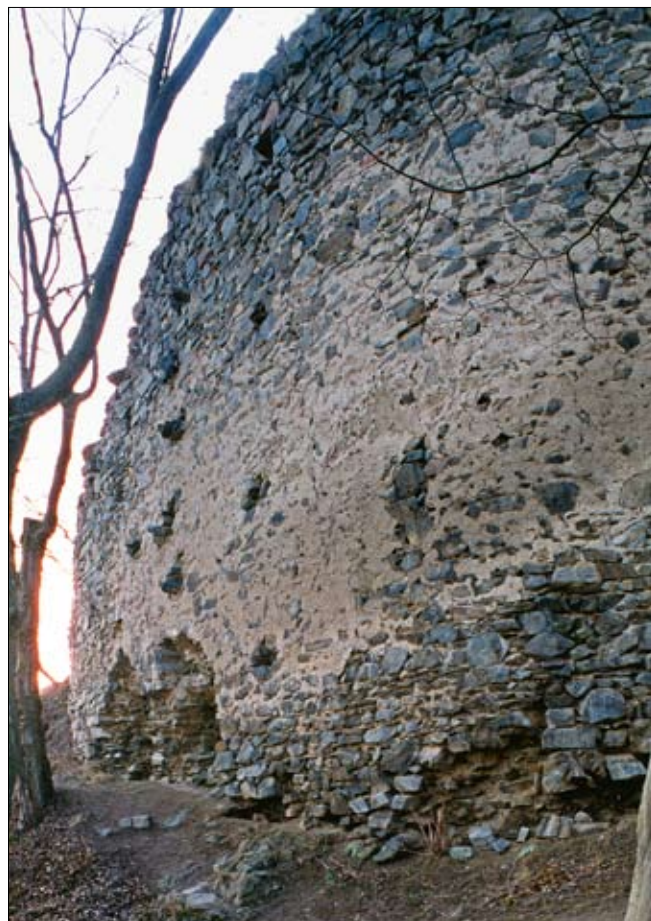
Obr. 8: Detail části líce hradby s kotvami (srov. obr. 5, 6 a 7), stav před zazděním kaveren v dolní části, které patrně souvisely se zbořením (podkopáním) přízdívky, nebo se snahou zbořit tuto (dochovanou) část hradby (2001).
