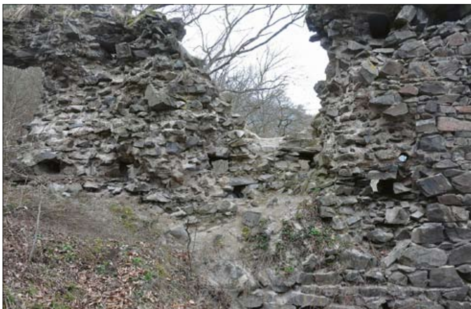
Obr. 35: Úsek parkánové zdi se stopami ochozu, vnitřní strana v pohledu od jihozápadu, detail (srov. obr. 34). Ve střední části snímku dvě řady otvorů po vodorovných hranolových prvcích těsně nad sebou, mezi nimi konstrukční spára. Zcela vpravo těsně nad spárou otvor po oblém nosníku lešení (srov. obr. 36; 2016).
