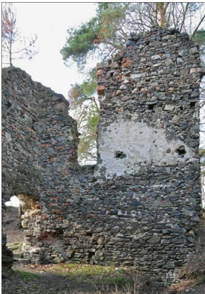
Obr. 20: Budova druhotně vložená do oblouku hradby jádra, západní část interiéru s pohledem k západu. Na stěně z první stavební fáze zbytky omítky přízemí (s otiskem valené klenby), zcela vpravo svislé zakončení zdi (s „kotvou“ nahore), přiléhající na spáru k dnes zaniklé obvodové hradbě. Vlevo od okna zdivo z druhé fáze, dole vchod do sklepa. Nahore okénko 1. patra, změněné ve 2. fázi na vchod (2016).
