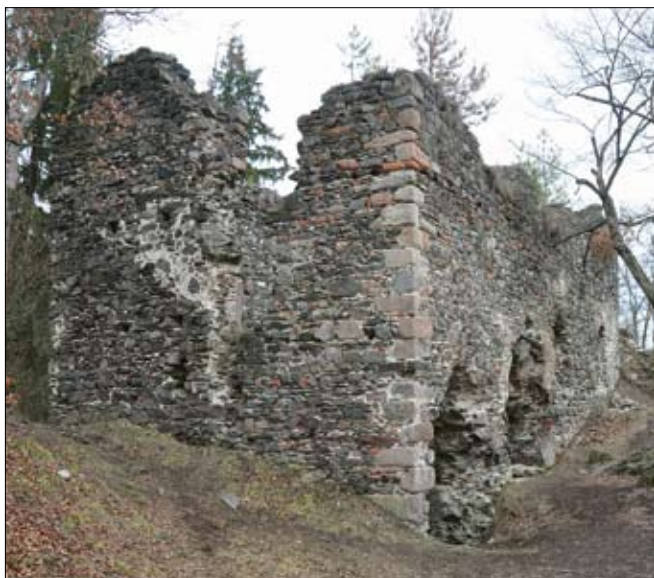
Obr. 12: Budova druhotně vložená do oblouku hradby jádra, celkový pohled od jihozápadu (2016).
