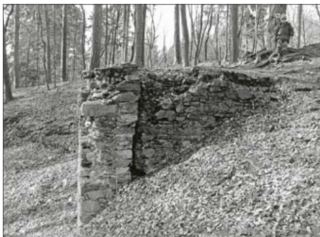
Obr. 42: Zděné předmostí severní brány parkánu v pohledu od východu. Před amatérskou sanací po roce 2000 bylo zřetelné, že boční zeď přiléhala k čelní zdi (srov. obr. 41) na spáru (asi 1999).
