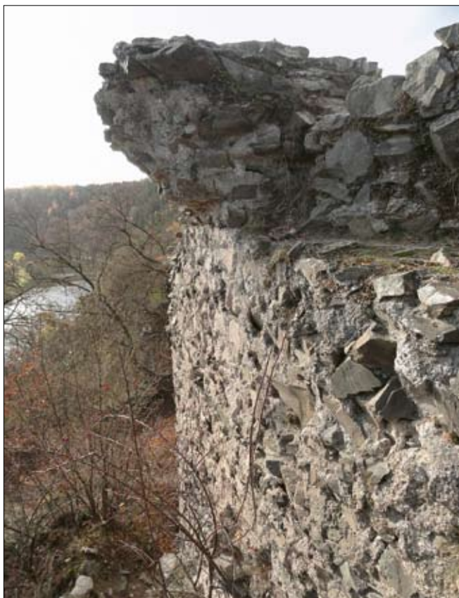
Obr. 25: Budova druhotně vložená do oblouku hradby jádra, detail exteriéru východní zdi, převyšující oblouk hradby (zcela dole). Nerovný povrch zdi přiléhá k vnitřnímu líci hradby, jejíž horní část zanikla (srov. též obr. 7 a 10 nahoře). Nahoře fragment části zdi, která přesahovala nad ochoz hradby (2015).
