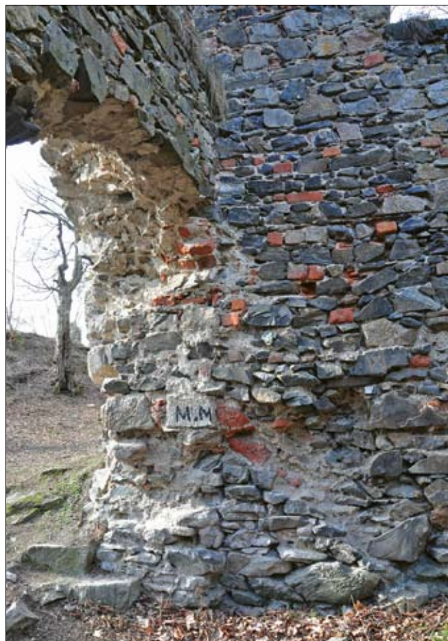
Obr. 21: Budova druhotně vložená do oblouku hradby jádra, západní část interiéru, detail jz. rohu místnosti (srov. obr. 20). Vpravo dole relikt líce původního sestupu do sklepa se stopami cihelné klenby. Samotný vstup vlevo, značně vyšší než ten původní, pochází spolu s okolním zdivem z druhé stavební fáze (2016).
