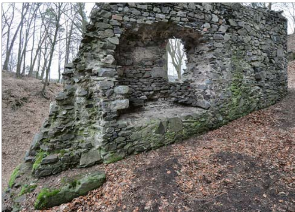
Obr. 39: Severní brána parkánu. Pohled z průjezdu na východní boční zeď. Uprostřed nika sedile s druhotně proraženým otvorem. Vlevo jizva po zaniklé průčelní zdi, pod ní v popředí vodorovný kvádr s lůžkem točnice padacího mostu (2016).
