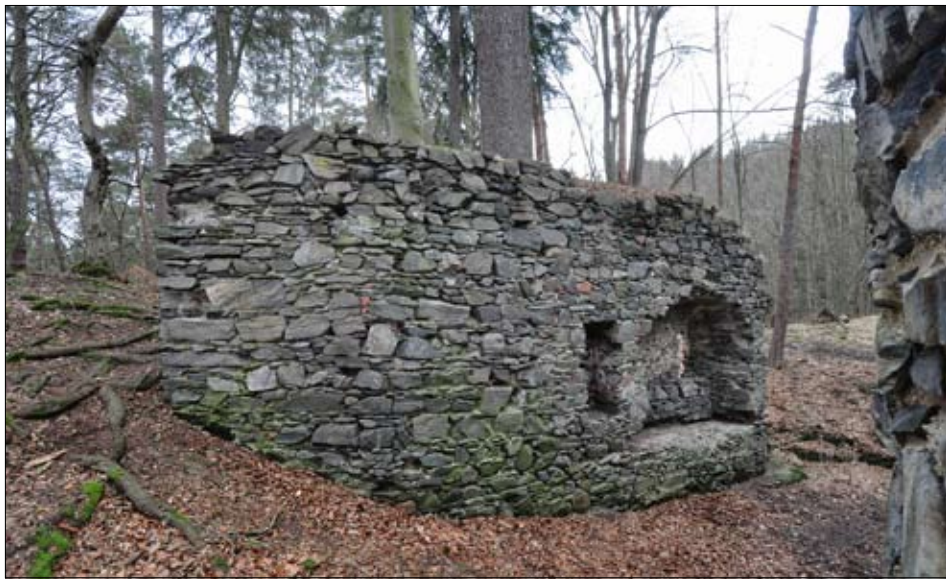
Obr. 40: Severní brána parkánu. Pohled z parkánu na západní stěnu interiéru, v pozadí nika sedile s druhotně proraženým otvorem (vpravo dole od ní druhý vodorovný kvádr s lůžkem točnice padacího mostu), vlevo od něj původní nika. V popředí lze na stěně dobře rozeznat dvě stavební fáze, vzájemně oddělené nepravidelnou svíslou spárou vlevo od niky (2016).
