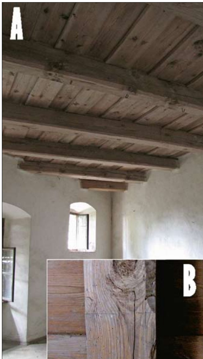
Obr. 15: Hrad Buchlov, Sýpka, 1. patro, A – místnost č. 05, pohled od jihu, B – místnost č. 14, detail ukončení profilace stropního trámu s vyznačenými tesařskými ryskami.
