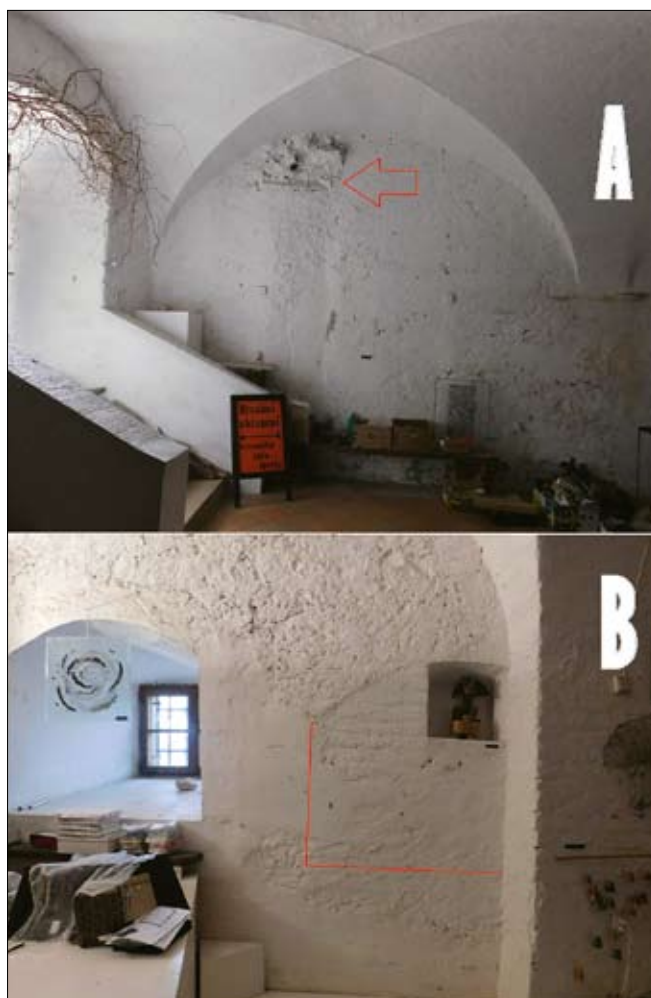
Obr. 12: Hrad Buchlov, Sýpka, místnost č. 01: A – jihovýchodní partie se- verozápadní stěny, šipka označuje svislou anomálii s amorfním zdivem, B – severozápadní stěna s fragmentem střílny; parapet a špaleta vyzna- čeny červenou linkou.
