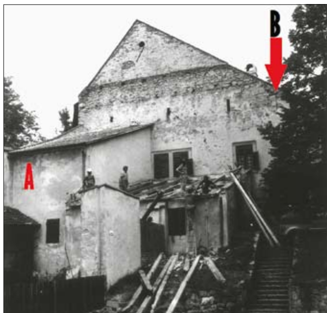
Obr. 18: Hrad Buchlov, Sýpka, jihozápadní průčelí, stav v roce 1956, před pořízením nové omítky; A – přístavba, v jejímž půdním prostoru je dochován zbytek vlašského komínu (srov. obr. 13), B – původní jižní nároží (archív správy SH Buchlov).
