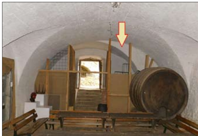
Obr. 14: Hrad Buchlov, Sýpka, místnost č. 02, severovýchodní čelo se starším pasem (označen šipkou) a vstupem do 2. nádvoří.
