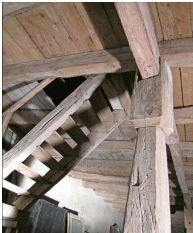
Obr. 16: Hrad Buchlov, Sýpka, 1. patro, místnost č. 17, detail tesařského schodiště a sloupu, podpírajícího jihozápadní průvlak stropního trámu, pohled od východu, stav 2014.
