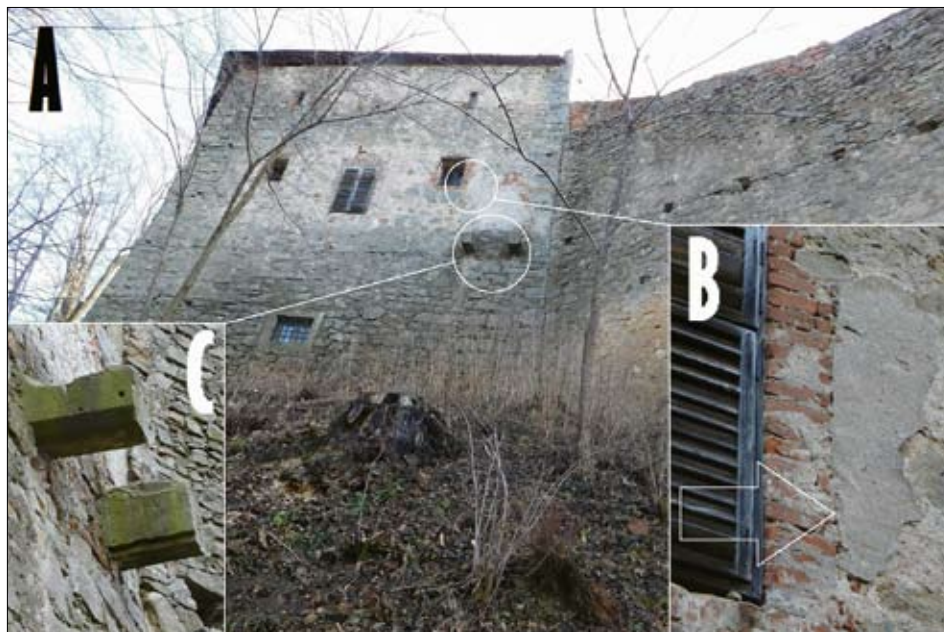
Obr. 3: Hrad Buchlov, Sýpka, západní fasáda objektu; A – celkový pohled od severozápadu, napravo navazuje hradba s klíčovými střílnami (její horní partie je novější), B – detail fasádní omítky, šipka označuje pravděpodobné zbytky výzdoby, C – detail dvojice konzol, vynášejících odstraněný arkýř.
