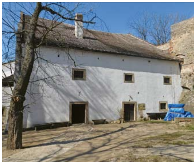
Obr. 9: Hrad Buchlov, Sýpka, jihovýchodní průčelí. Napravo je patrná zeď, vyčleňující prostor severního parkánu, s vynásecím pasem ve spodní části.
