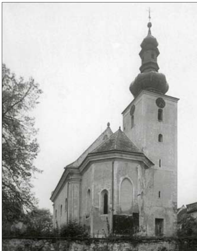
Obr. 1: Popice u Znojma (okres Znojmo) – kostel sv. Zikmunda. Celkový pohled od jihovýchodu. Ve spodních partiích obvodového zdiva je viditelný asfaltový izolační nátěr (b. d. – začátek 80. let 20. stol., fotoarchiv NPÚ ÚOP v Brně, inv. č. 18394).
