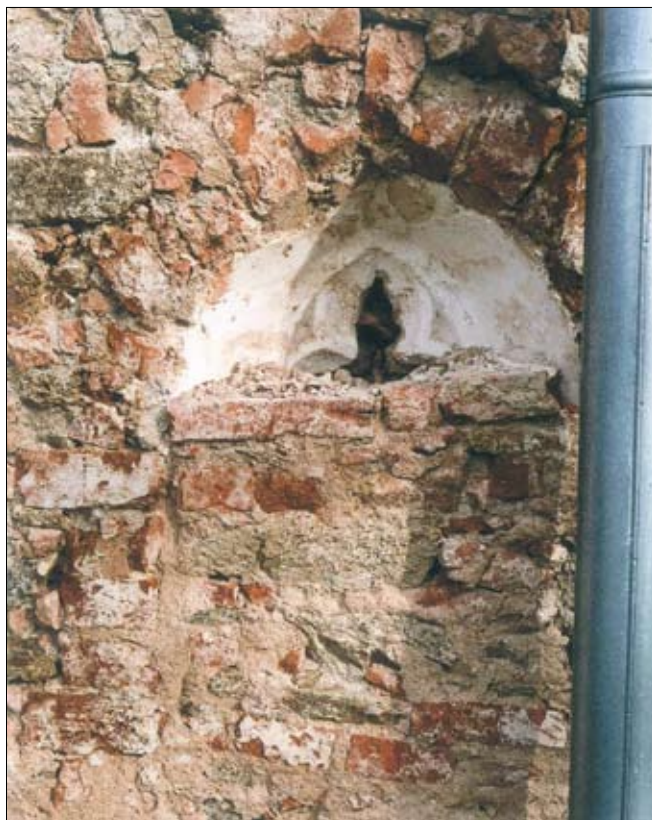
Obr. 8: Popice u Znojma – kostel sv. Zikmunda. Okénko při jižním nároží lodi s odkrytou jeptiškou (foto M. Zavadil, 2010, fotoarchiv NPÚ ÚOP v Brně, inv. č. 149768).
