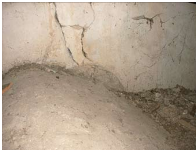
Obr. 11: Popice u Znojma – kostel sv. Zikmunda. Část vrcholu původního okna lodi viditelná v podkroví (foto L. Šabatová, 2009).
