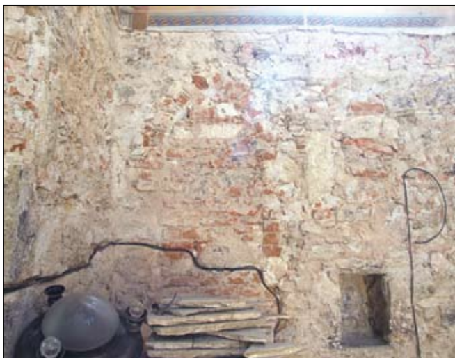
Obr. 7: Popice u Znojma – kostel sv. Zikmunda. Situace se zazděným okénkem při jižním koutě lodi, viditelné jsou rovněž vyplněné jizvy po rohové klenuté konstrukci baldachýnu a odsekaná žebra (foto P. Dohnalová, 2012).
