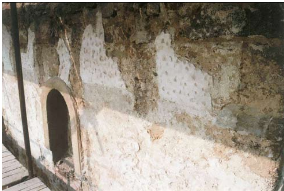
Obr. 4: Popice u Znojma – kostel sv. Zikmunda. Otisk zárážek v koruně zdiva původní kostelní věže, odkrytých v průběhu oprav fasády (foto H. Winklerová, 2009, fotoarchiv NPÚ ÚOP v Brně, inv. č. 149374).
