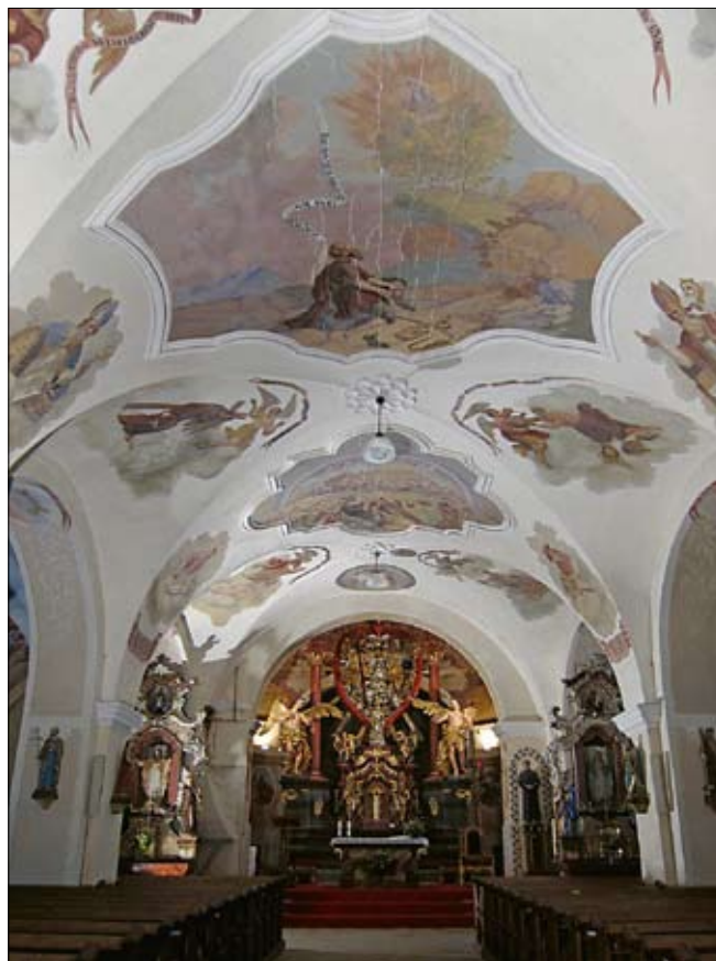
Obr. 3: Kostel Nejsvětější Trojice na Křešně, hlavní loď, stav před restaurováním v roce 2015 (Archiv NPÚ ÚOP Telč, foto A. Hamrlová, 2015).
