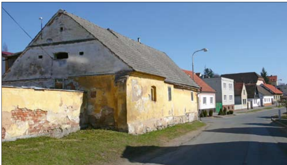
Obr. 18: Merklín – usedlost čp. 19. Pohled od severozápadu na obytné stavení s navazujícími chlévy. Stav v roce 2012.
