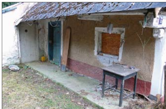
Obr. 3: Dolní Lukavice – stavení čp. 77/E5. Pohled od západu na část severozápadní strany stavby se zápražím a vstupem do síně. Vpravo okenní otvor osvětlující světnici.
