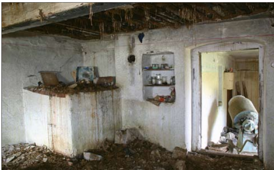
Obr. 12: Vlčice u Blovic – usedlost čp. 11. Světnice při západním průčelí. Pohled od západu východním směrem ke dveřím do síně (vpravo) a na pec, která byla vystavěna v severovýchodní koutové části místnosti. Stav po demontáži krovu, kdy srážková voda odhalila povalový strop, původně zakrytý hliněnými omítkami. Stav v roce 2013.
