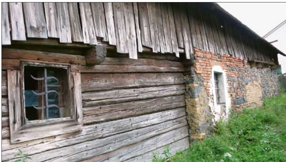
Obr. 11: Vlčice u Blovic – usedlost čp. 11. Severní strana obytného stavení, pohled od východu na roubenou stěnu zadní komory. Kamenné zdivo utváří severní stranu bývalé černé kuchyně ve střední části stavení (na snímku zhruba uprostřed) a severní stěnu přední světnice (na fotografii vpravo). V ploše zděné části stěny lze spatřit segmentovým pasem zaklenutý otvor po chlebové peci, přiléhající ke stavení z vnější strany zcela v souladu se zněním ohňových patentů, vydávaných císařskou kanceláří od poloviny 18. století. Okénko v roubené stěně je vybavené jednoduchou kovanou mříží, vloženou přímo do hraněných kmenů. Stav v roce 2013.
