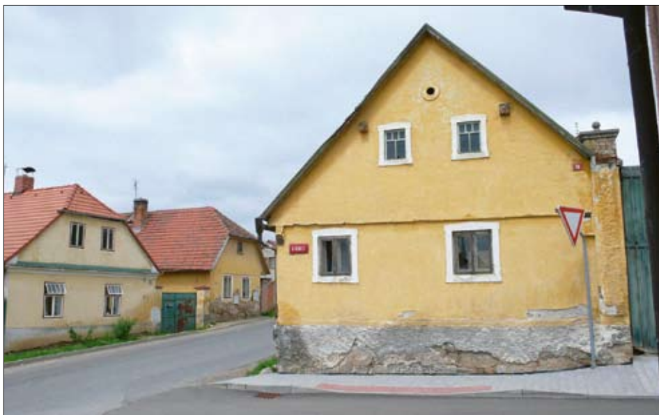
Obr. 17: Merklín (okres Plzeň-jih) – usedlost čp. 19. Pohled od jihu na jihovýchodní průčelí obytného stavení. Stav v roce 2013.
