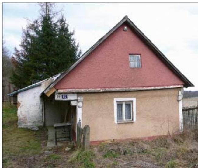
Obr. 2: Dolní Lukavice – stavení čp. 77/E5. Pohled od jihozápadu na průčelí stavby. V levé části snímku lze spatřit dodatečnou přístavbu, která k objektu přilehla od severozápadu.
