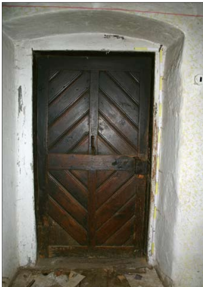
Obr. 13: Vlčice u Blovic – usedlost čp. 11. Přední světnice. Pohled z interiéru na dveře při vstupu do síně, původně osazené ve dveřním otvoru mezi zápražím a síní. Jde o slohový truhlářský výrobek z období klasicismu, dobu před přestavbou objektu na počátku 30. let 19. století nelze vyloučit. Stav v roce 2013.
