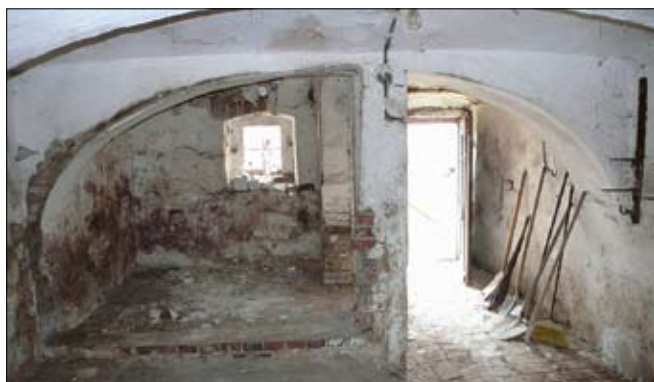
Obr. 21: Merklín – usedlost čp. 19. Chlévy za obytnou částí. Interiér, pohled od jihozápadu severovýchodním směrem ke vstupu na dvůr. Stav v roce 2014.
