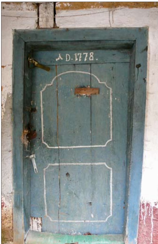
Obr. 4: Dolní Lukavice – stavení čp. 77/E5. Pohled od severozápadu na čelní stranu vstupních dveří do síně, vybavených patrně sekundárně malovaným vročením A. D. 1778.
