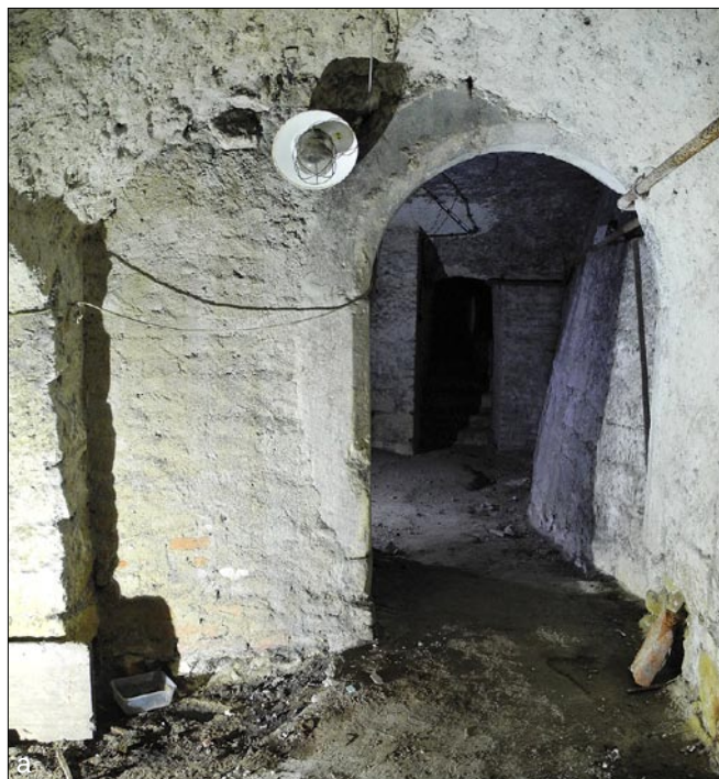
Obr. 10: Mladá Boleslav – dům čp. 28, suterén: a – pohled z kolmé vstupní šíje k portálu do sklepa. Vlevo je druhotně prolomený průchod do prostoru podélné šíje; b – pohled ze sklepa k portálu a vstupní šíji. Nad portálem je zachována špaleta větracího otvoru z bývalého podloubí. Vpravo je viditelná část klenby se stlačeným obloukem a vrcholnicí rovnoběžnou s průčelím.
