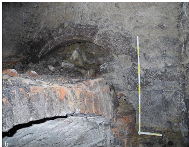
Obr. 6: Mladá Boleslav – dům čp. 28, suterén, prostor pod bývalým podloubím: a – průhled druhotně prolomeným průchodem do prostoru podélné šíje. Vpravo je viditelná část oblouku zaslepeného pískovcového portálu náležející nejstarší fázi. Vlevo v horní části kolmé stěny se slabě rýsuje obrys zazdívky bývalého vstupu propojující obě části podélné šíje. Přístup do spodního sklepa tesaného ve skále s cihelnou segmentovou klenbou byl realizován po zrušení výše uvedených vstupů a připojení k domu čp. 28; b – detail ostění portálu.
