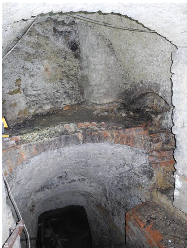
Obr. 6: Mladá Boleslav – dům čp. 28, suterén, prostor pod bývalým podloubím: a – průhled druhotně prolomeným průchodem do prostoru podélné šíje. Vpravo je viditelná část oblouku zaslepeného pískovcového portálu náležející nejstarší fázi. Vlevo v horní části kolmé stěny se slabě rýsuje obrys zazdívky bývalého vstupu propojující obě části podélné šíje. Přístup do spodního sklepa tesaného ve skále s cihelnou segmentovou klenbou byl realizován po zrušení výše uvedených vstupů a připojení k domu čp. 28; b – detail ostění portálu.
