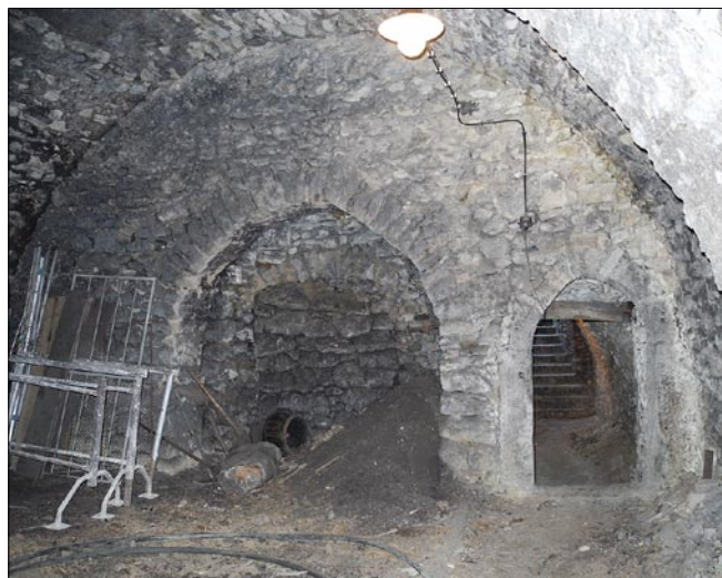
Obr. 9: Mladá Boleslav – dům čp. 29, suterén, pohled k zadnímu sklepu. Ve výklenku uprostřed stěny je částečně viditelný obrys špalety původního vstupu, jehož ostění bylo vyjmuto. Výklenek je součástí dodatečně přizdívky k původní stěně realizované při rozšíření předního sklepa. V pravé části stěny je druhotně prolomený vstup do chodby umožňující přístup do suterénu ze dvora.
