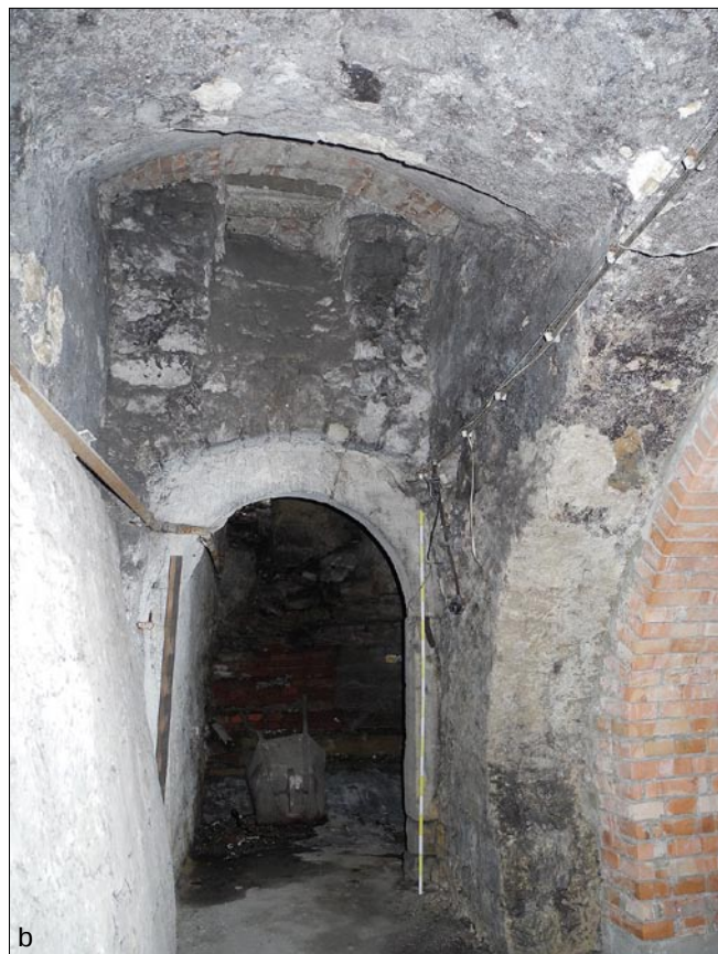
Obr. 10: Mladá Boleslav – dům čp. 28, suterén: a – pohled z kolmé vstupní šíje k portálu do sklepa. Vlevo je druhotně prolomený průchod do prostoru podélné šíje; b – pohled ze sklepa k portálu a vstupní šíji. Nad portálem je zachována špaleta větracího otvoru z bývalého podloubí. Vpravo je viditelná část klenby se stlačeným obloukem a vrcholnicí rovnoběžnou s průčelím.
