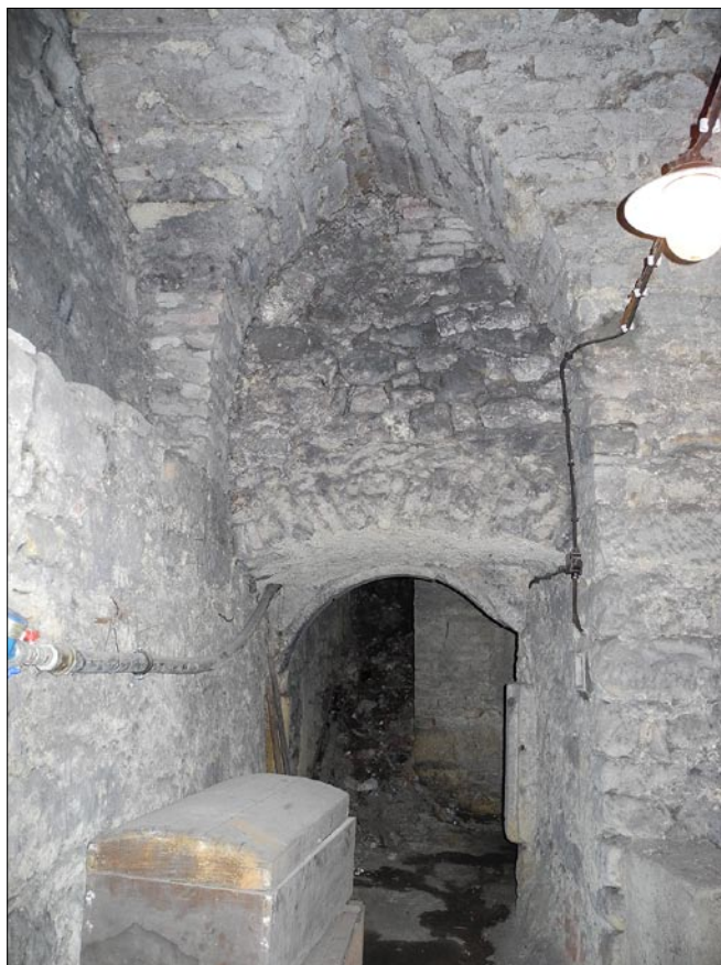
Obr. 8: Mladá Boleslav – dům čp. 29, suterén, přední sklep, pohled ke vstupu s druhotně vloženou klenbou k obvodovým stěnám.
