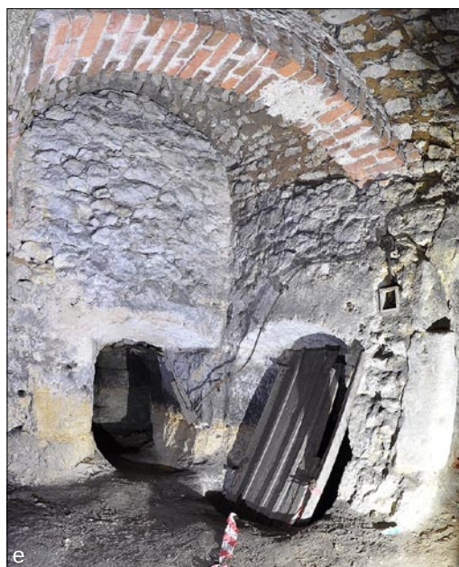
Obr. 7: Mladá Boleslav – dům čp. 29, suterén, prostor pod bývalým podloubím: a – pohled z podélné šje směrem k portálu v dělicí stěně s čp. 28. Vlevo je portál do sklepa pod čp. 29, vpravo ústí kolmá šje. Klenba z lomového pískovce byla při ústí kolmé šje dodatečně přezděna; b – detail patičky ostění portálu v dělicí stěně s čp. 28; c – pohled ze sklepa ke kolmé šji z náměstí, jejíž čelo bylo přezděno zřejmě v souvislosti se zřízením nástupu do spodního sklepa tesaného ve skále; d – portál do sklepa pod čp. 29; e – pohled do čela podélné šje se vstupy do spodních lochů. Zcela vpravo viditelná část ostění portálu do sklepa pod čp. 29 (foto J. Veselý, 2016).
