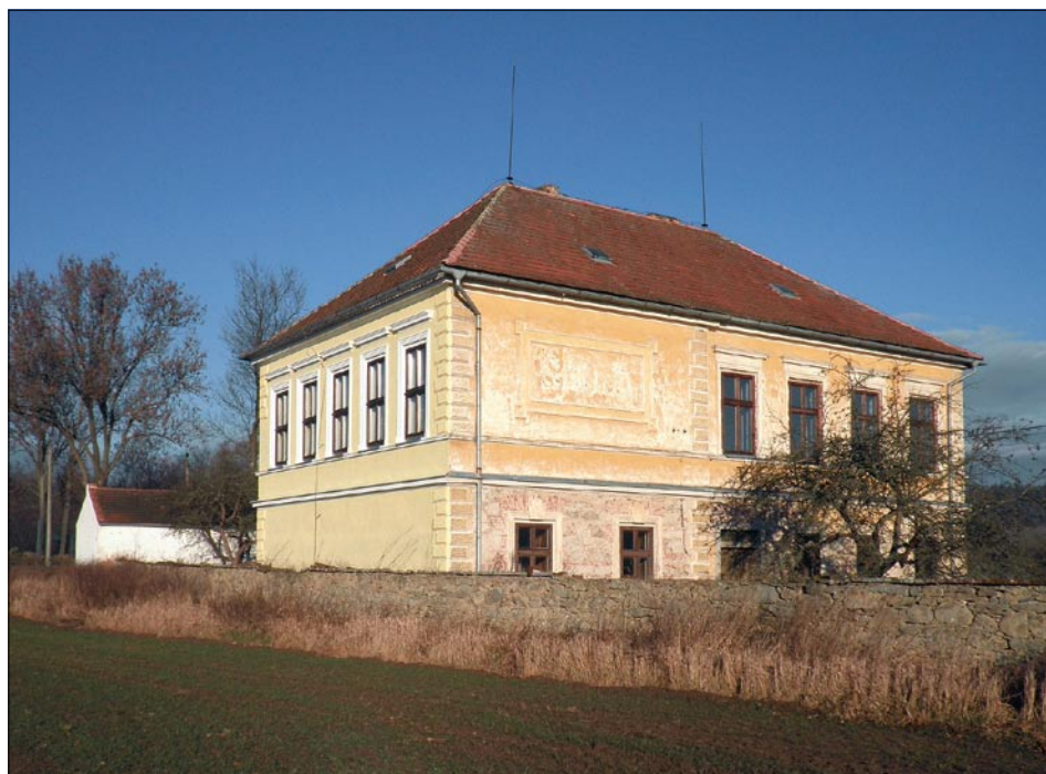
Obr. 14: Defurovy Lažany – stávající pohled na budovu školy čp. 58 od jihu, stav 2013.
