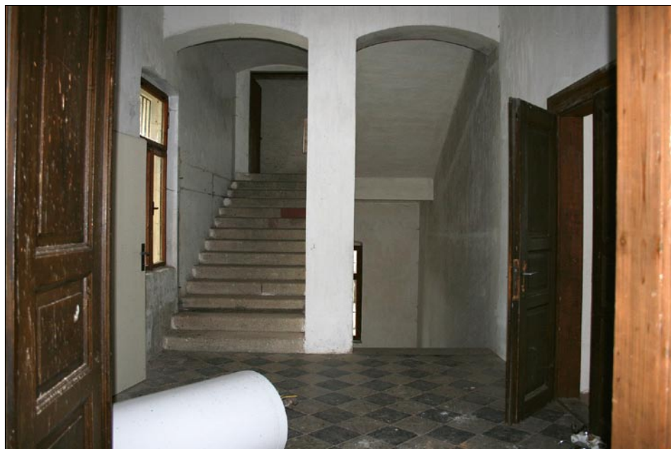
Obr. 15: Defurovy Lázně – interiér školy, patro, pohled k hlavnímu schodišti s původní keramickou dlažbou, žulovými schodišťovými stupni a dochovanými slohovými dveřmi učeben, stav 2013.
