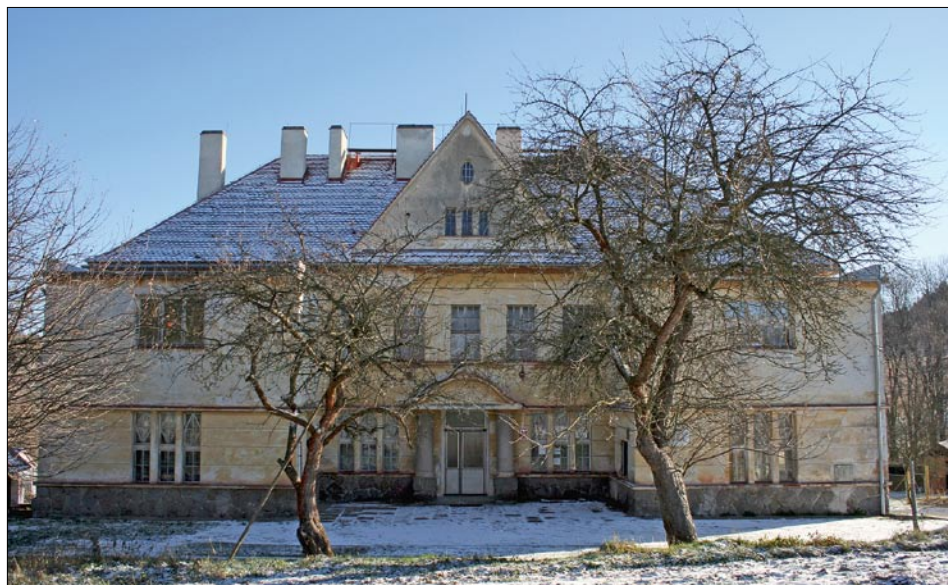
Obr. 22: Kovčín – stávající pohled na vstupní průčelí budovy školy čp. 57 od západu, stav 2013.
