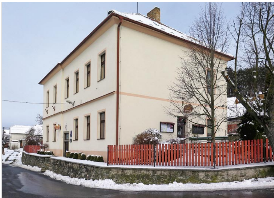
Obr. 7: Hejná – stávající pohled na budovu školy čp. 70 od jihovýchodu, stav 2016.
