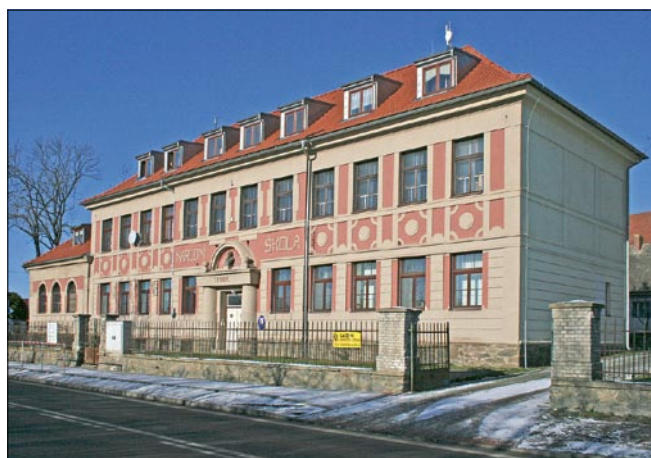
Obr. 29: Hradešice – stávající pohled průčelí budovy školy čp. 81 od jiho-východu, stav 2013.
