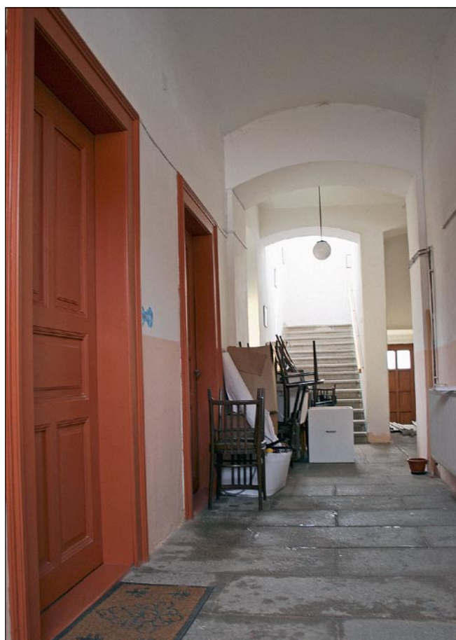
Obr. 4: Slatina – přízemí školy, průhled příčnou chodbou od vstupu do budovy k hlavnímu schodišti. Fotografie dokládá stav dochování některých dobových truhlářsko-řemeslných prvků (dveře), podlahových skladeb (žulové desky) a žulových schodišťových stupňů.
