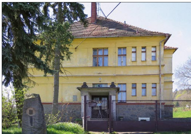
Obr. 32: Ústaleč – vstupní průčelí budovy školy čp. 70 od severu, stav 2016.
