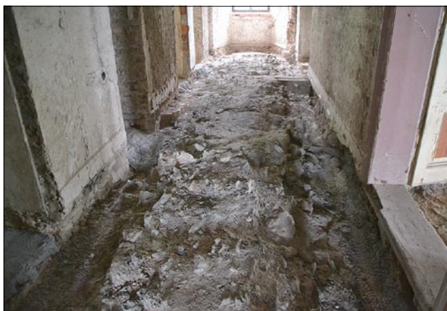
Obr. 10: Žacléř, zámek čp. 1 – rub klenby nad chodbou 1.01 (foto M. Burroň, 2016).
