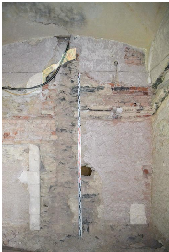
Obr. 14: Žacléř, zámek čp. 1 – jihovýchodní kout chodby 1.02 v místě předpokládaného palácového schodiště s vyznačením fragmentu renesančního portálu a kamenného základku, stav 2016.
