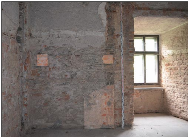
Obr. 16: Žaclěř, zámek čp. 1 – západní obvodová zeď v místnosti 2.04 v prvním patře s vyznačením okna hradního paláce a zazděných kapes po stropních trámech (foto M. Buroň, 2016).
