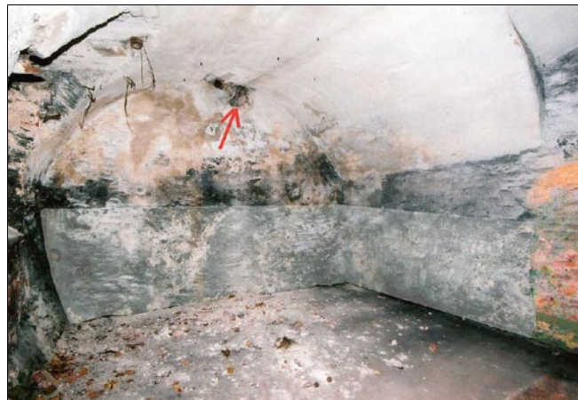
Obr. 17: Žaclěř, zámek čp. 1 – severozápadní sklep 0.02 s vyznačením úrovně snížené podlahy a zazděnou nikou staršího vstupu či schodiště v severní stěně. V západní stěně zazděný renesanční vstup (foto M. Buroň, 2011).
