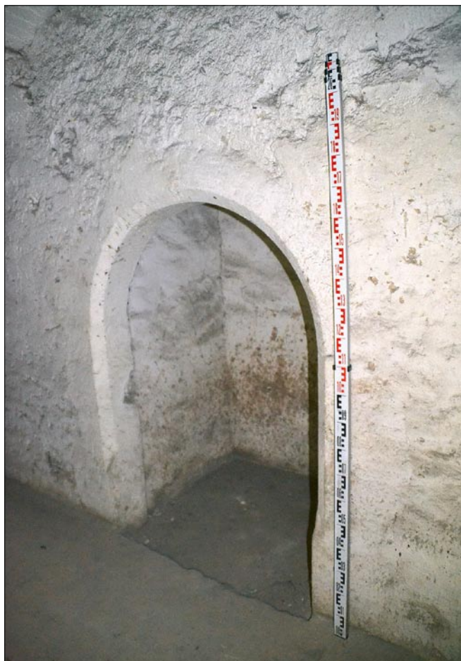
Obr. 18: Žaclěř, zámek čp. 1 – renesanční portál v chodbě sklepa 0.01, stav 2016.
