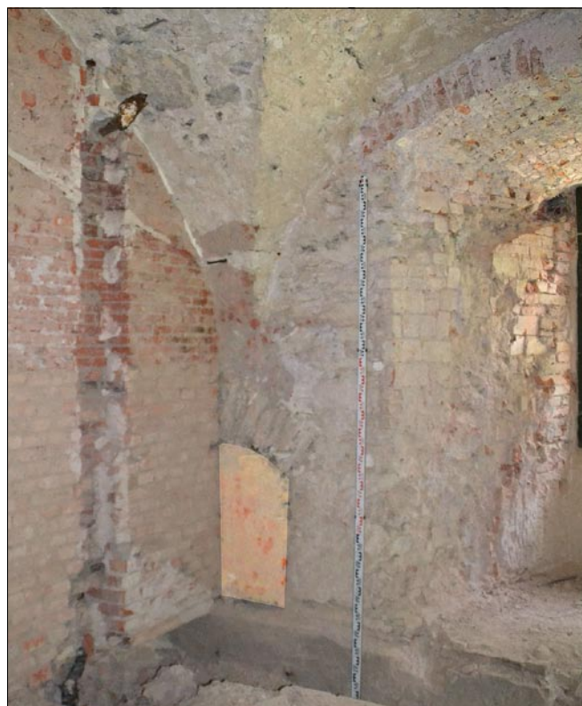
Obr. 13: Žaclěř, zámek čp. 1 – jihovýchodní kout místnosti 1.03 s vyznačeným fragmentem okna hradního paláce, stav 2016.
