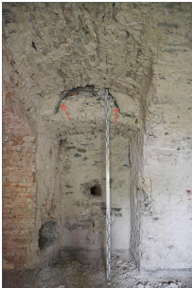
Obr. 15: Žacléř, zámek čp. 1 – nika v jihozápadním koutě místnosti 1.06 se zazděným nadpražím gotického portálu – místo předpokládaného palácového schodiště, stav 2016.
