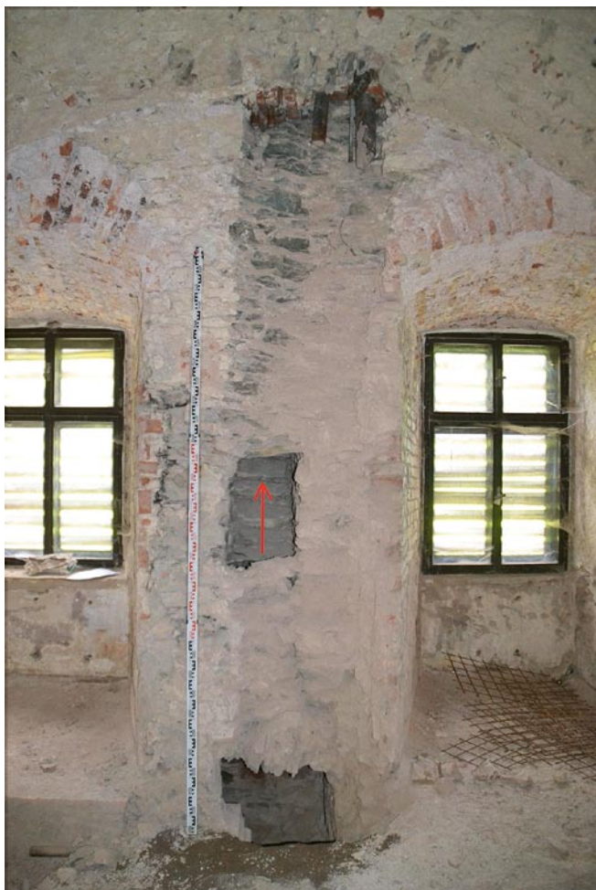
Obr. 11: Žaclěř, zámek čp. 1 – severní stěna místnosti 1.03 v patě s nikou staršího vstupu či schodiště a nad ním se zaústěním průduchu, stav 2016.
