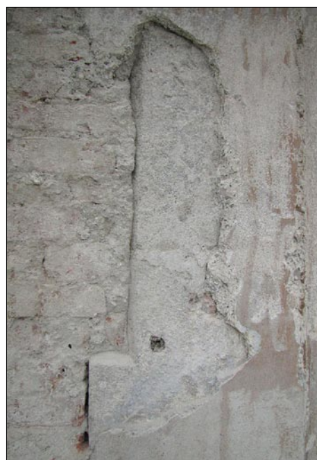
Obr. 13: Holešov, zámek, detail okoseného okenního ostění, odkrytého mezi třetím a čtvrtým oknem od jihozápadní věže v úrovni 2. patra severní fasády.
