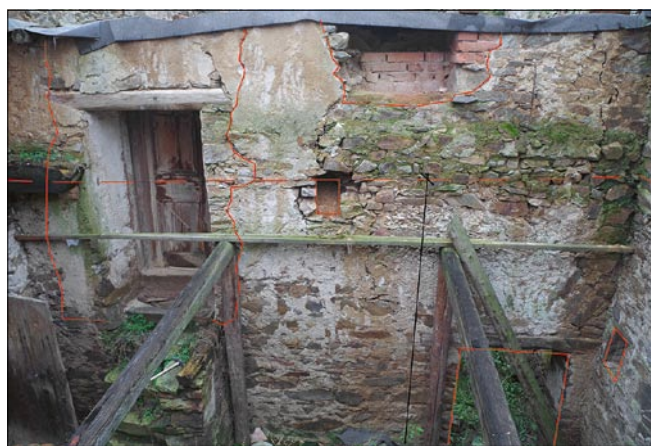
Obr. 12: Radošovice, sýpka usedlosti čp. 9 – červenou linkou je na jižní stěně severního dílu zvýrazněn: vpravo dole původní vstup do komorové (jižní) části; vlevo nad ním dva dodatečně vybourané otvory do obou horních podlaží místo uložení a linie stropu severního dílu sýpky (foto a zákres D. Šnejd, 2015).
