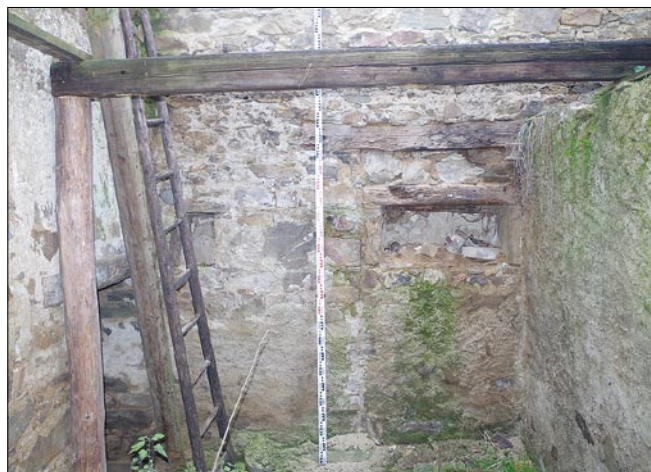
Obr. 16: Radošovice, sýpka usedlosti čp. 9 – pohled na západní stěnu severního dílu s dodatečně zmenšenou nikou.
