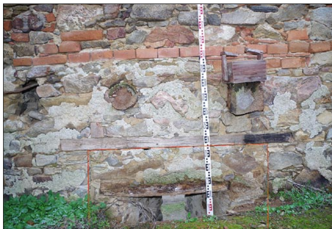
Obr. 10: Radošovice, sýpka usedlosti čp. 9 – červenou linkou zvýrazněný obrys původní okenní niky (horní část nad novodobým stropem do traverz) ve východní stěně přízemí severní části, nad fošnovým překladem, jsou vidět zhlaví trámů původního stropu (foto a zákres D. Šnejd, 2015).
