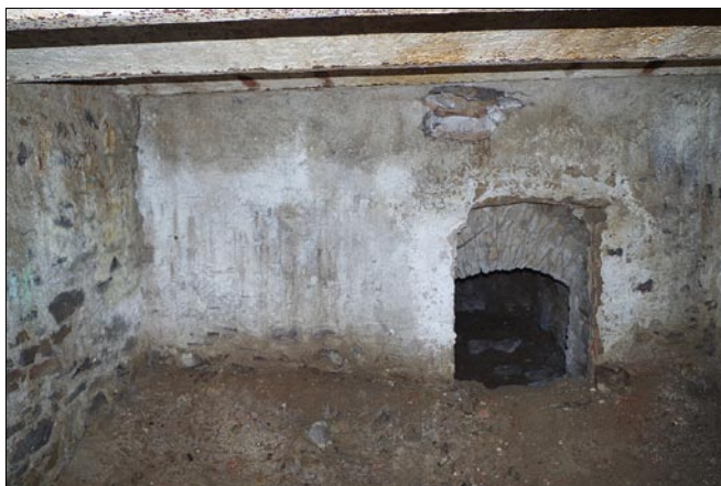
Obr. 13: Radošovice, sýpka usedlosti čp. 9 – západní stěna severního dílu sýpky se vstupem do sklepa.
