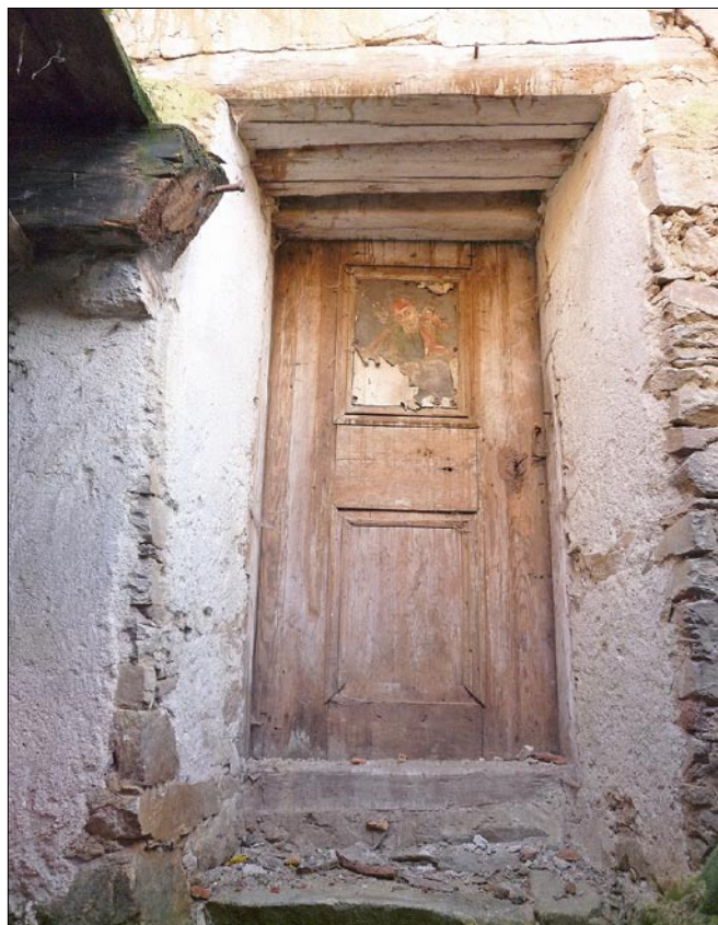
Obr. 18: Radošovice, sýpka usedlosti čp. 9 – výplň dodatečně probouraných dveří do patra komorového bloku.
