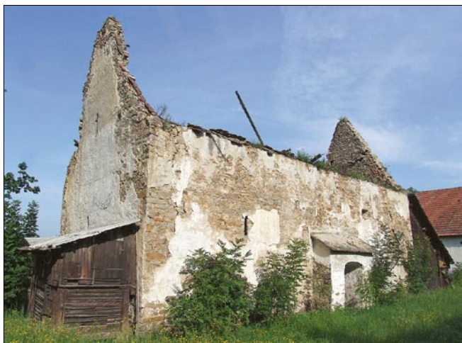
Obr. 6: Radošovice, sýpka usedlosti čp. 9 – stav po destrukci krovu (foto J. Skořepová, 2011).
