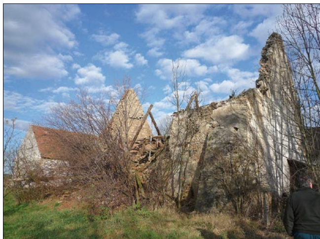
Obr. 7: Radošovice, sýpka usedlosti čp. 9 – stav západní stěny sýpky těsně po destrukci krovu (foto Č. Luhan, 2009).
