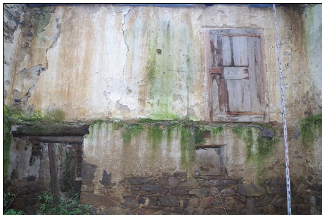
Obr. 22: Radošovice, sýpka usedlosti čp. 9 – severní stěna komorového bloku.
