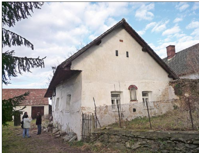
Obr. 5: Radošovice, dům usedlosti čp. 9 – pod přízdívkou obvodových stěn světnice se ukrývá roubení, výrazný náklon boční stěny směrem do interiéru naznačuje možný náběh roubení do klenby (foto Č. Luhan, 2009).
