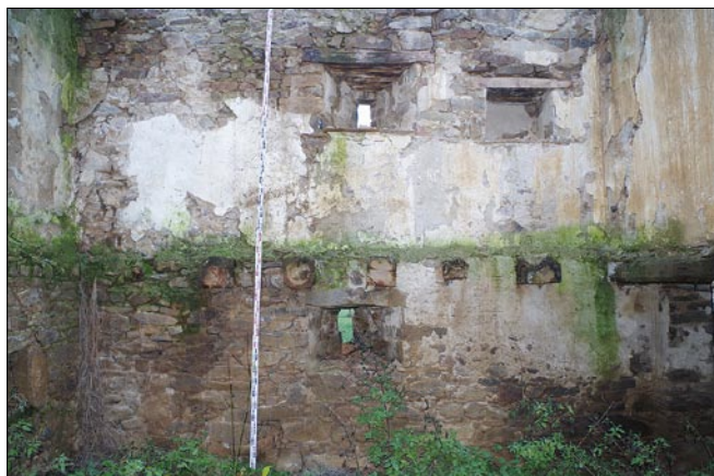
Obr. 21: Radošovice, sýpka usedlosti čp. 9 – západní stěna komorového bloku.
