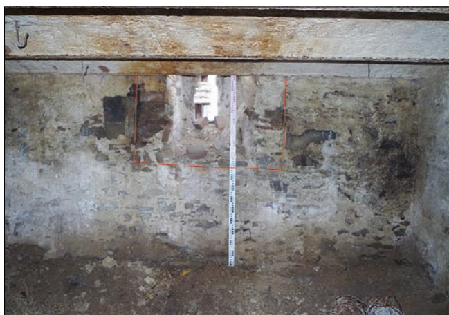
Obr. 9: Radošovice, sýpka usedlosti čp. 9 – červenou linkou zvýrazněný obrys původní okenní niky ve východní stěně přízemí severní části (foto a zakres D. Šnejd, 2015).
