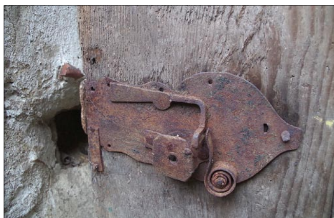
Obr. 17: Radošovice, sýpka usedlosti čp. 9 – druhotně použitý zámek dveří vstupu do sýpky.
