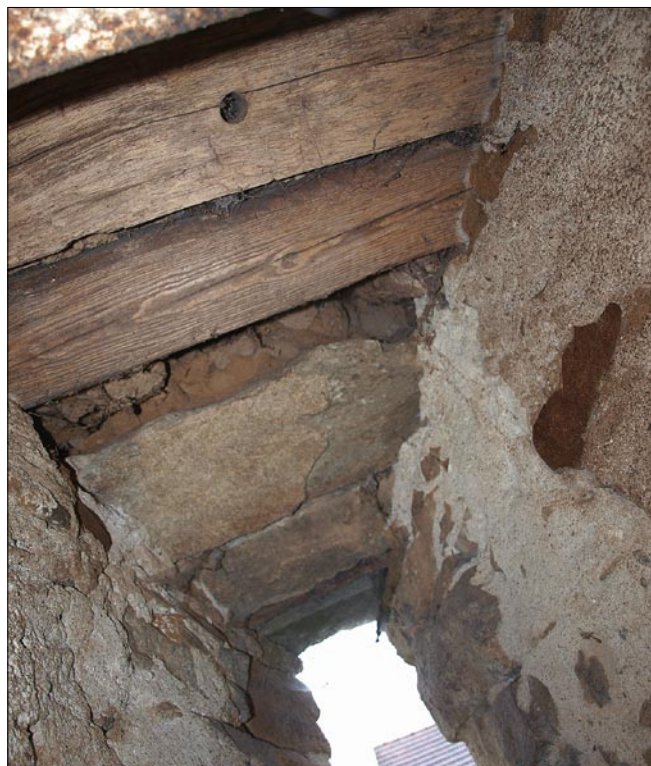
Obr. 11: Radošovice, sýpka usedlosti čp. 9 – pohled do okenní niky ve východní stěně přízemí severní části, podle rozdílných druhů omítek i svislé spáry je dobře čitelné dodatečné zazdění niky, v krajním překladu je vrtaný otvor mříže (foto a další snímky D. Šnejd, 2015).
