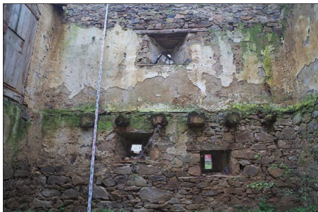
Obr. 19: Radošovice, sýpka usedlosti čp. 9 – východní stěna komorového bloku.
