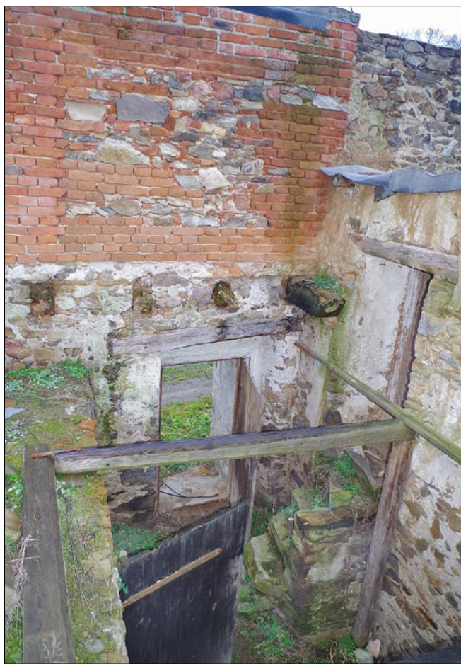
Obr. 14: Radošovice, sýpka usedlosti čp. 9 – pohled na vnitřní niku hlavního vstupu do objektu.
