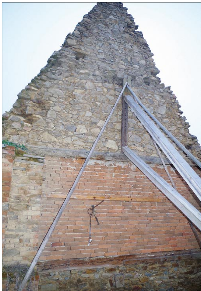
Obr. 15: Radošovice, sýpka usedlosti čp. 9 – pohled na vnitřní stranu dochovaného severního štítu, je na něm čitelný otisk krovu i prostupy pro vaznice propojující krov se štítem.
