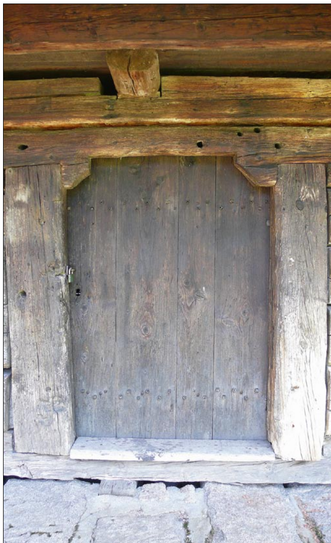
Obr. 11: Chanovice (okres Klatovy), Expozice lidové architektury – dveře roubené kůlny se stodůlkou, původně z Měčina čp. 9. Dřevo užitě na zárubní pochází z roku 1560, ostatní dřevo pro stavbu bylo kácené v letech 1613–1618 (foto K. Foud, 2016).
