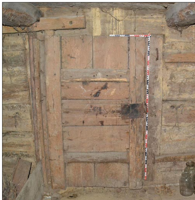
Obr. 3: Třebýčinka (okres Klatovy) – sýpka u čp. 12, pohled na rubovou stranu točnicových dveří, vpravo na roubené stěně je patrná situace se třemi dřevěnými závory, ze kterých se dochovala jen spodní (foto S. Plešmíd, červenec 2016).
