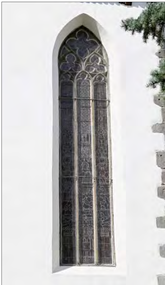
Obr. 18: Sedlčany, kostel sv. Martina – východní okno na jižní straně lodi, detail (stav 2015).
