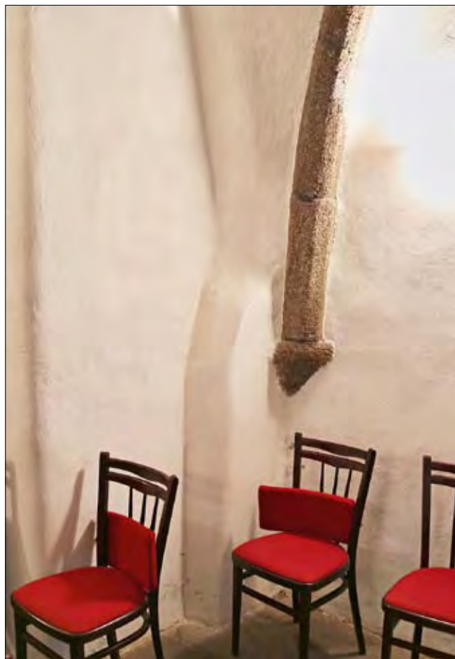
Obr. 7: Sedlčany, kostel sv. Martina – jihozápadní kout středního pole pod raně gotickou tribunou s patrným torzem staršího zdiva vybíhajícího k východu.
