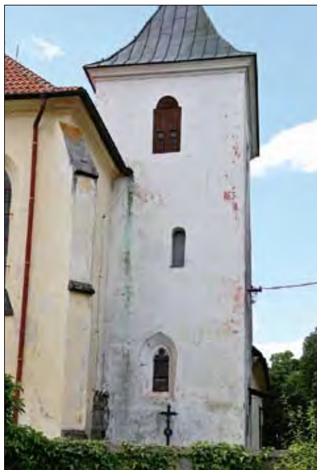
Obr. 41: Střeziměř, kostel sv. Havla – východní strana věže s oknem sakristie dole.
