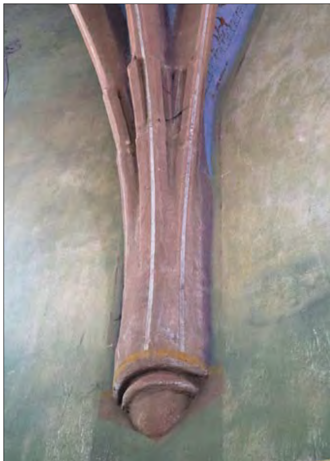
Obr. 44: Živohošť, kostel sv. Fabiána a Šebestiána – původní konzola klenby presbytáře na jižní straně s výběhy prvotně plánovaných klínových, na bocích vyžlabených žebířů.
