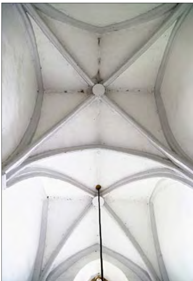
Obr. 22: Sedlčany, kostel sv. Martina – klenba sakristie-kaple sv. Kateřiny.
