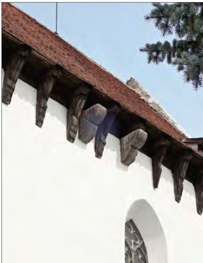
Obr. 24: Sedlčany, kostel sv. Martina – koruna jižní zdi lodi s kamennými krakorci a dřevěnými závlačemi (stav 2015).
