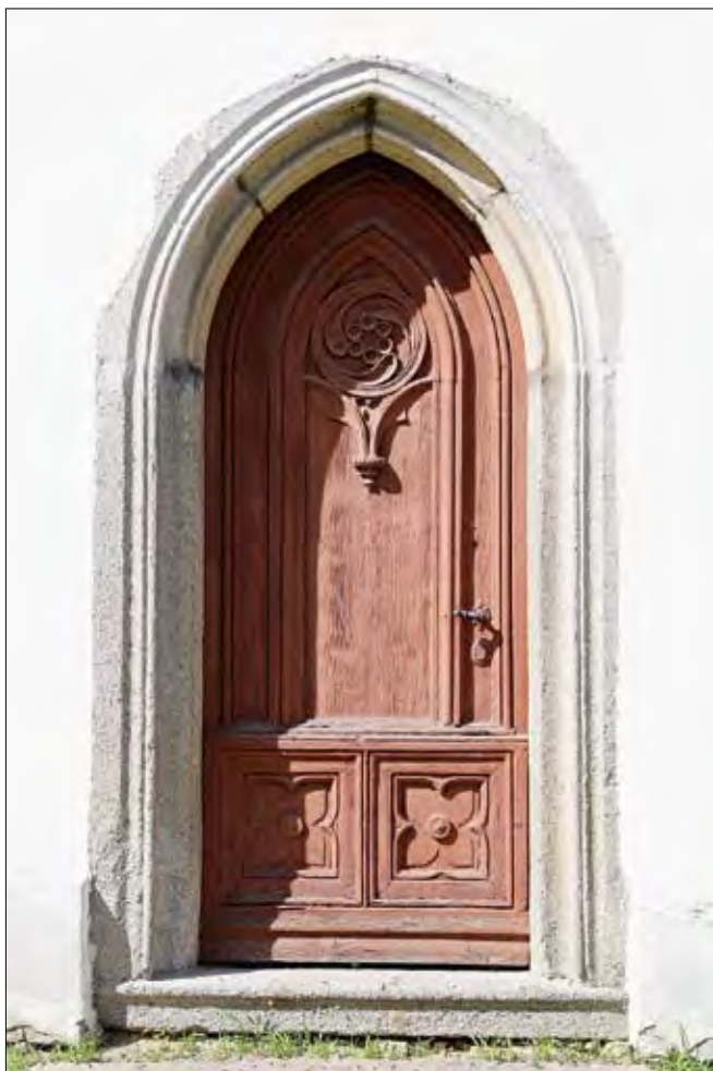
Obr. 17: Sedlčany, kostel sv. Martina – jižní portál lodi (stav 2015).
