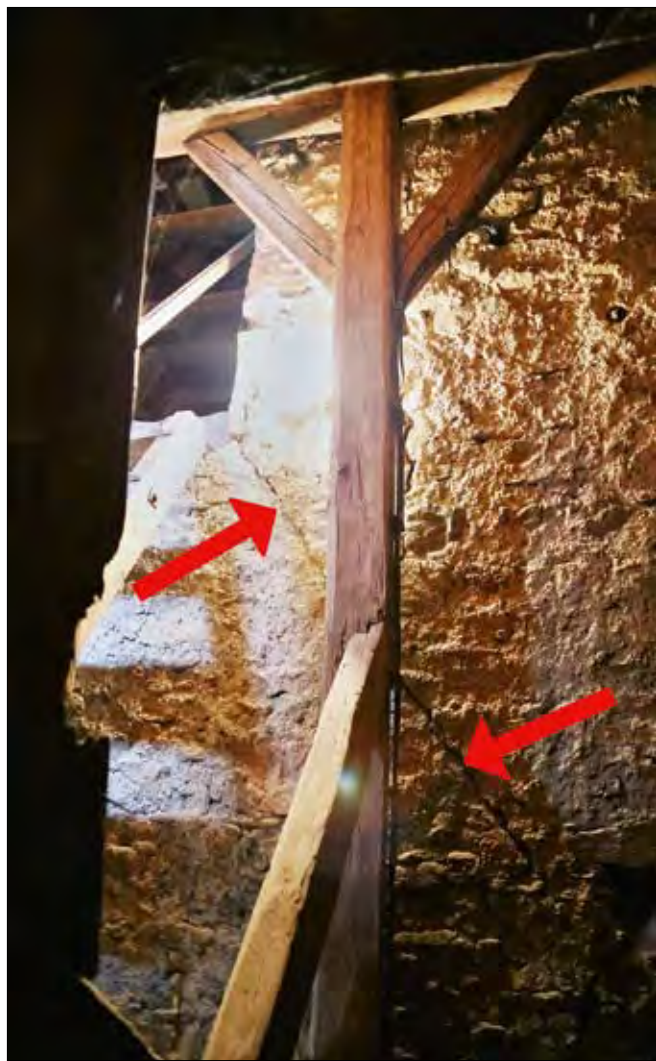
Obr. 8: Sedlčany, kostel sv. Martina – západní štít lodi v pohledu od západu s patrnou dilatační spárou (vyznačena šipkami) oddělující starší raně gotický a mladší pozdně gotický štít.
