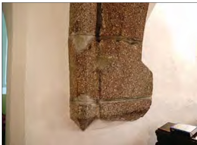
Obr. 6: Sedlčany, kostel sv. Martina – podchycení čelní arkády raně gotické tribuny a klenebního žebra na severní straně.
