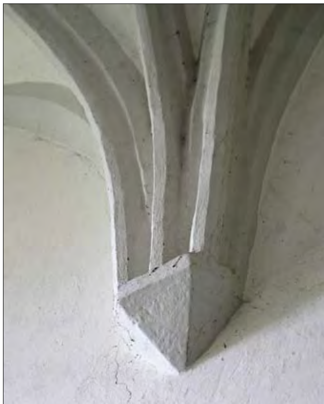
Obr. 23: Sedlčany, kostel sv. Martina – konsola klenby v sakristii-kapli sv. Kateřiny uprostřed jižní zdi.
