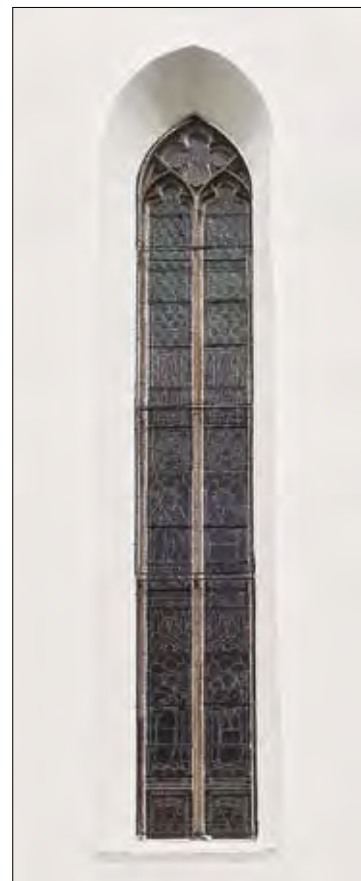
Obr. 16: Sedlčany, kostel sv. Martina – střední okno na jižní straně korpusu (stav 2015).
