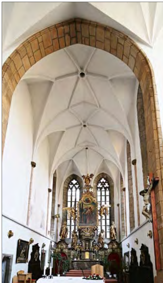
Obr. 31: Soběslav (okres Tábor), kostel sv. Petra a Pavla – pohled do presbytáře, dnes s pozdně gotickou klenbou, která nahradila původní klenutí z konce 3. čtvrtiny 14. století.
