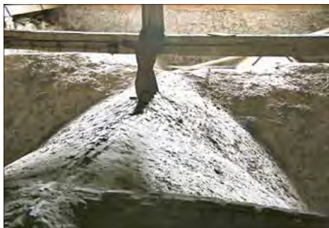
Obr. 20: Sedlčany, kostel sv. Martina – rub cihlové klenby presbytáře v podkroví, pohled k východu.
