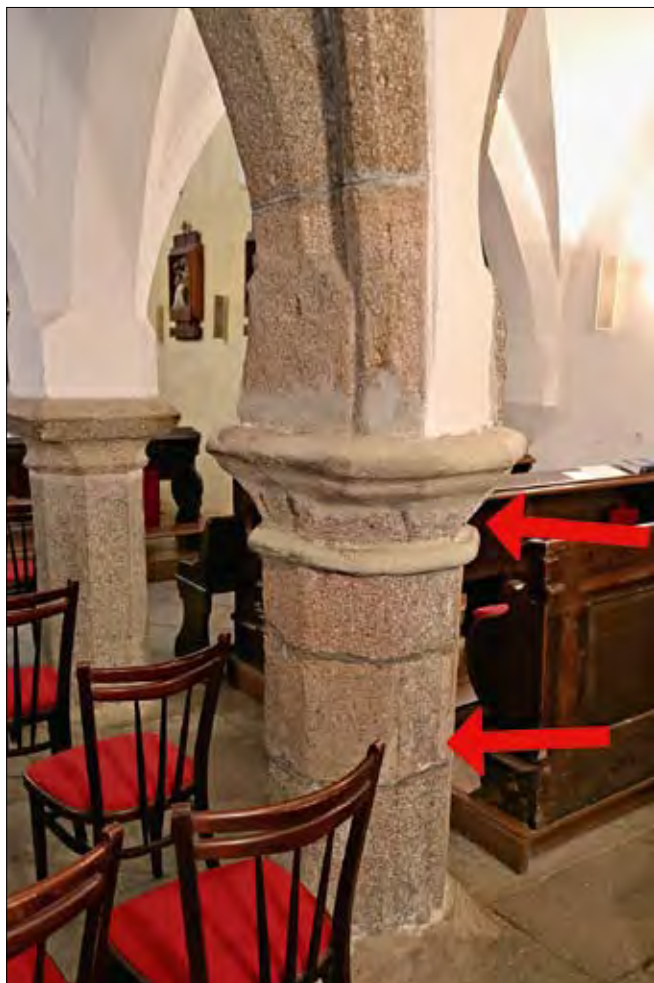
Obr. 5: Sedlčany, kostel sv. Martina – raně gotický pilíř pod tribunou na rozhraní středního a jižního pole, pohled od severozápadu; patrná je absence žebra dělicího obě pole, ale i stopy odtesané přípory s hlavicí (vyznačeno šipkami).
