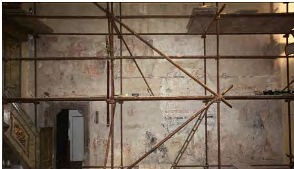
Obr. 6: Sedlčany, kostel sv. Martina, nástěnná malba Klanění tří králů po odkrytí maleb, zkoušky tmelení defektů (foto M. Pavlíková).
