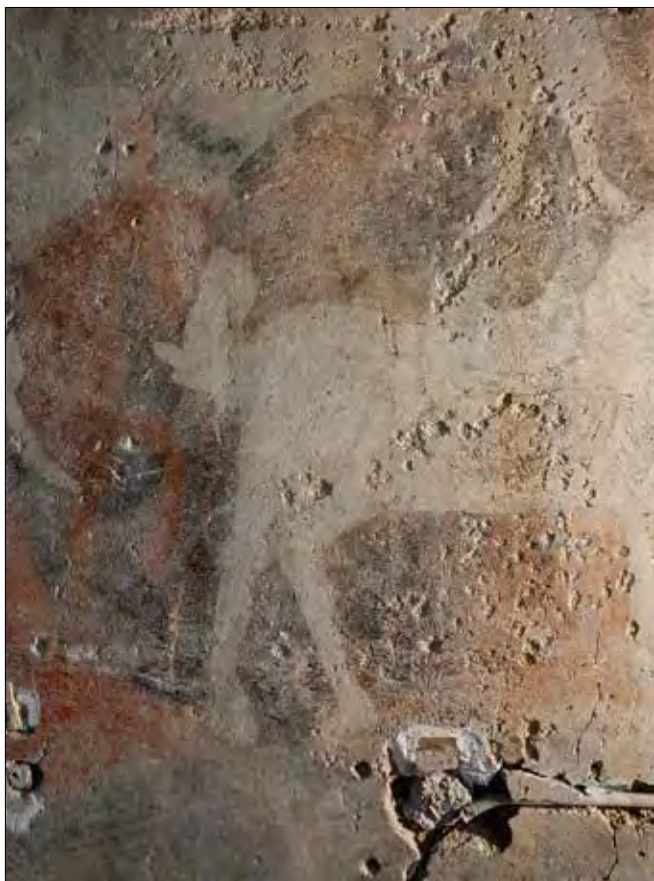
Obr. 5: Sedlčany, kostel sv. Martina, nástěnná malba Klanění tří králů, razantní osvětlení zvýraznilo mechanické defekty v omítkové vrstvě (foto M. Pavlíková).
