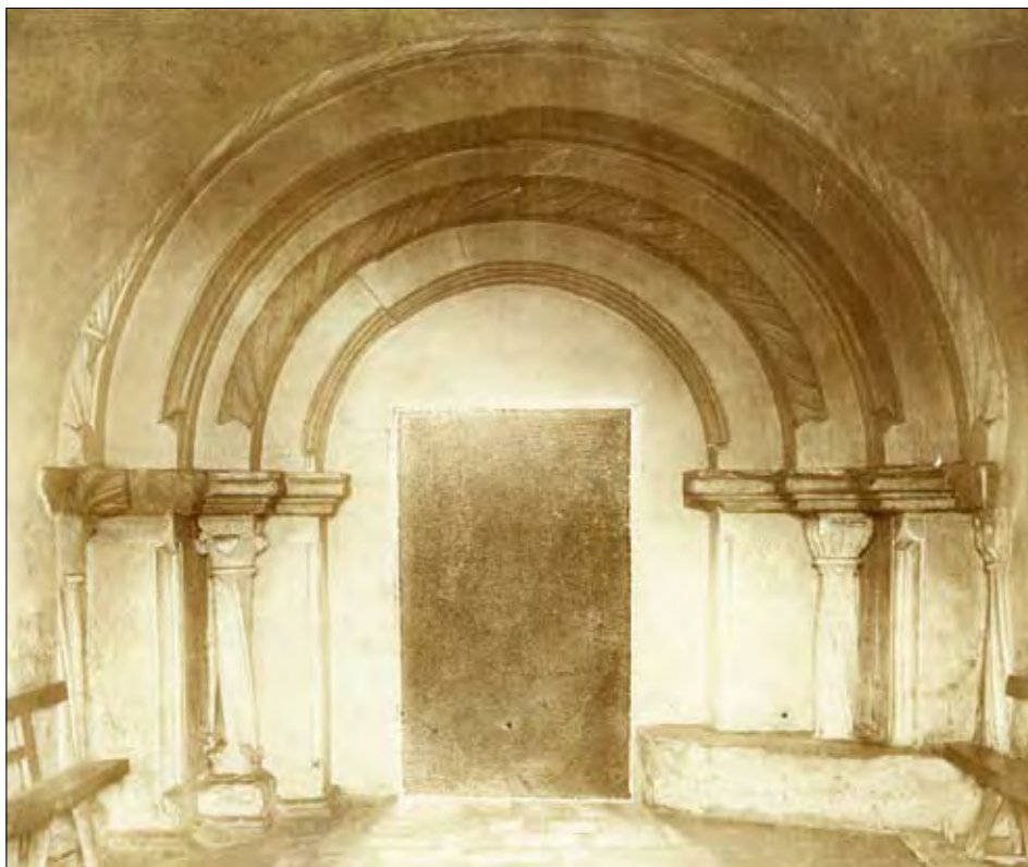
Obr. 36: Hulín, kostel sv. Václava, románský severní portál před očištěním a uvolněním vnějšího páru sloupků, tj. před rokem 1908. Za pozornost stojí úroveň podlahy v předsíni, později snižená, zděný stupeň při západním ostění portálu i pokrytí portálu patrně dvoubarevným nátěrem (fotografie uložena v archivu NPÚ ÚOP v Kroměříži).
