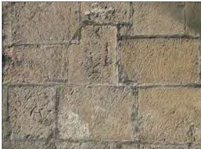
Obr. 5: Hulín, kostel sv. Václava, detail románských kvádrů s původním opracováním povrchu a vyrytým písmenem „A“ poblíž jihozápadního nároží lodi. Patrná je i neorganická vazba bloků a novodobé cementové spárování.
