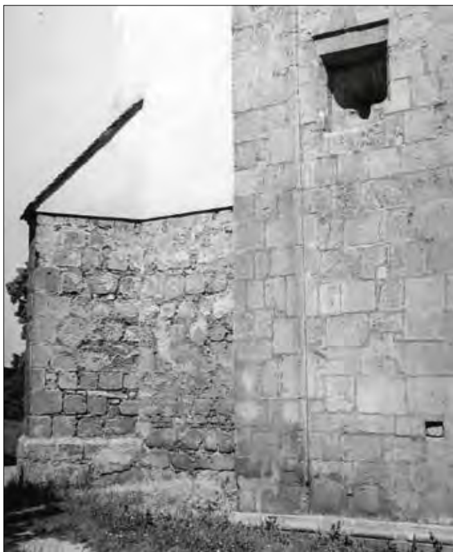
Obr. 25: Hulín, kostel sv. Václava, zdivo renesanční věže, zbudované z druhotně použitého materiálu věže románské (vlevo). Vpravo jihozápadní nároží románské lodi (fotografie patrně z 60. – 70. let 20. století, uložena v archivu NPÚ ÚOP v Kroměříži).
