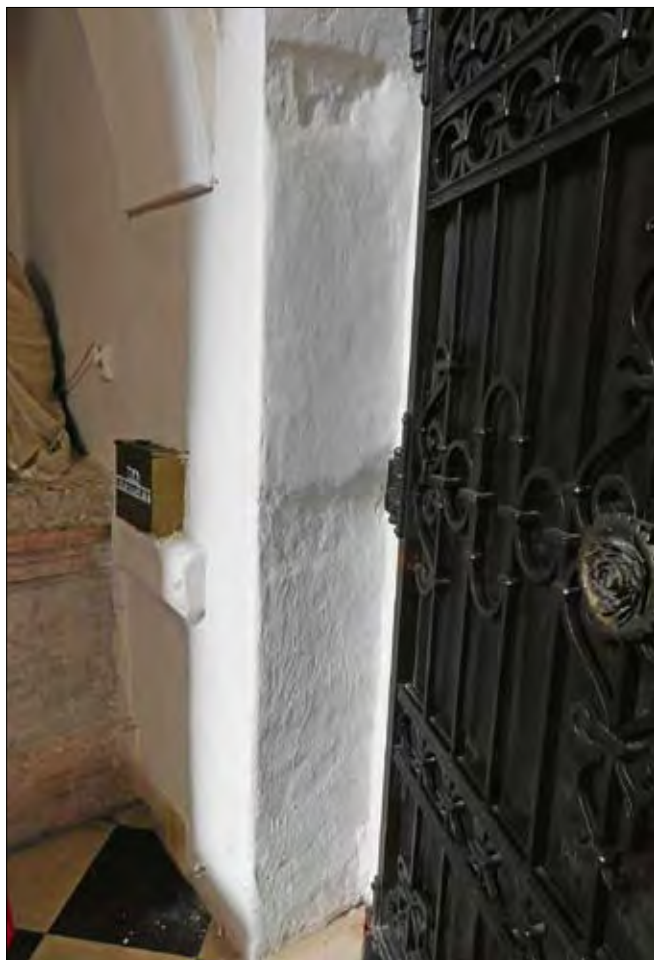
Obr. 11: Hulín, kostel sv. Václava, interiérový líc severní zdi lodi s předpokládanou pateční římsou románské empory (vlevo) a výběhem záklenku klasicistní kruchty (vlevo nahoře). Vpravo interiérová špaleta románského portálu se zřetelnými stopami opotřebení, vzniklými dlouhodobým otvíráním starších, odlišně konstruovaných dveří.
