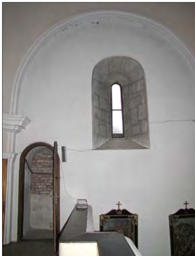
Obr. 12: Hulín, kostel sv. Václava, románské detaily v západní partii severní zdi lodi – okno a půlkruhově završený průchod na emporu, do nějž ústí chodbička v tloušce severní zdi.
