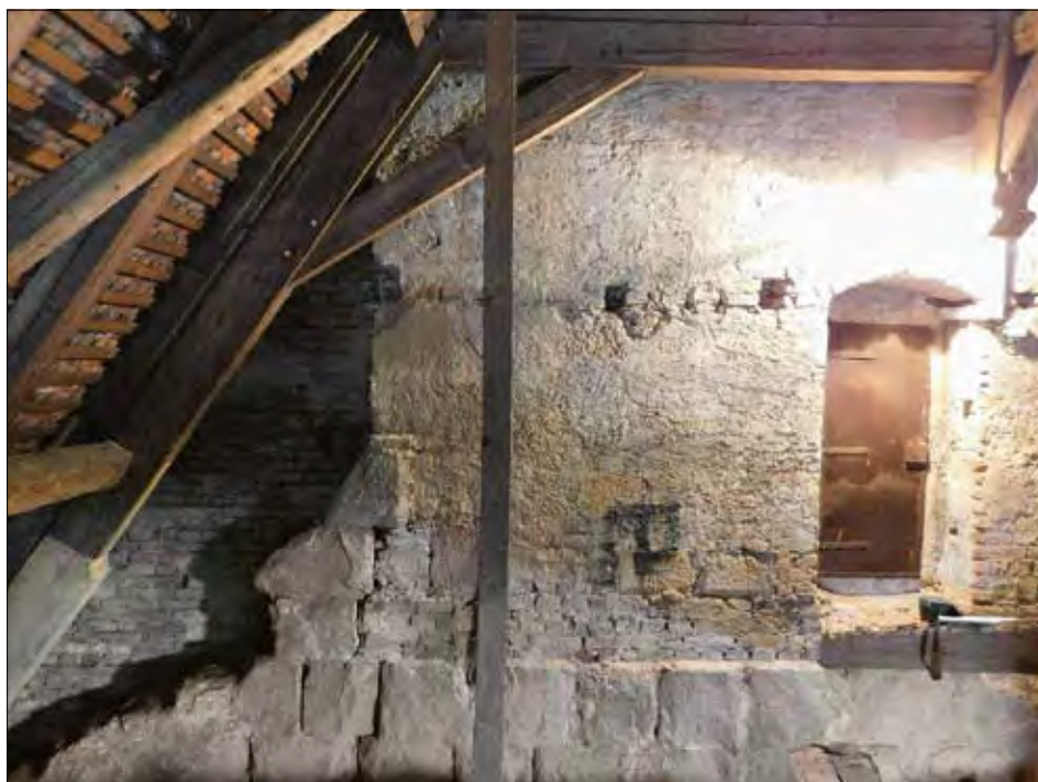
Obr. 26: Hulín, kostel sv. Václava, pozůstatky jižní části střešního štítu západního průčelí lodi. Štítu náleží kvádrové zdivo (vlevo), zčásti ponechané i po výstavbě renesanční věže, z níž je patrné hrubě omítané zdivo s dveřním otvorem (na snímku uprostřed a vpravo).
