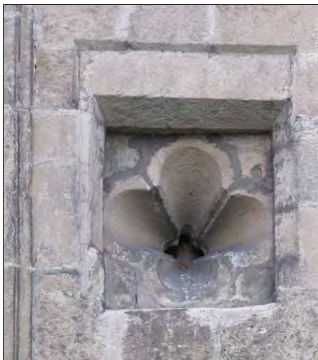
Obr. 9: Hulín, kostel sv. Václava, detail románského čtyřlístového okénka při jihozápadním nároží lodi, původně vedoucího na emporu. Vlevo profilovaná hrana lizény na jihozápadním nároží lodi.
