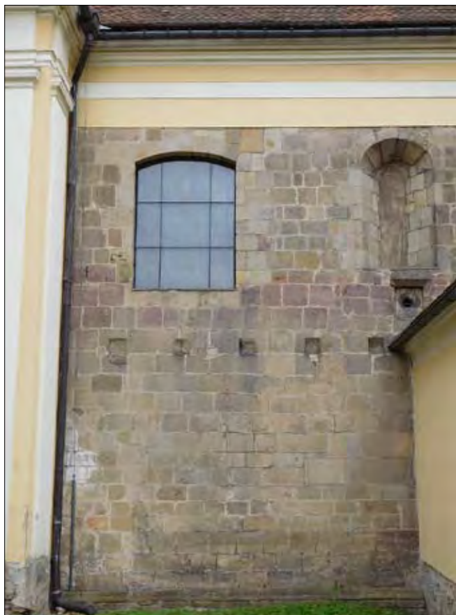
Obr. 33: Hulín, kostel sv. Václava, současná podoba východního úseku severní zdi románské lodi s pozůstatky románských, gotických, raně a pozdně barokních i novodobých stavebních úprav.
