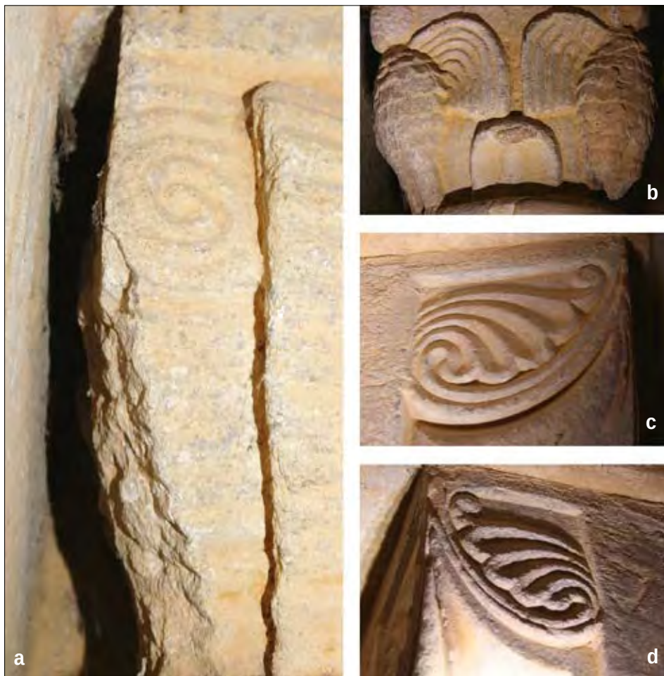
Obr. 22: Hulín, kostel sv. Václava, detaily architektonického členění severního portálu: a – nedotesaná, do ústupku orientovaná část hlavice vnitřního ústupku v západním ostění portálu; b – hlavice vnějšího sloupku západního ostění, zdobená dvojicí orlů (levý je originální, pravý je vyjma křídel novodobou kopií); c, d – ornament na drápkovitě ukončení profilace vnějšího ústupku západního ostění portálu (foto L. Melichová, 2017).
