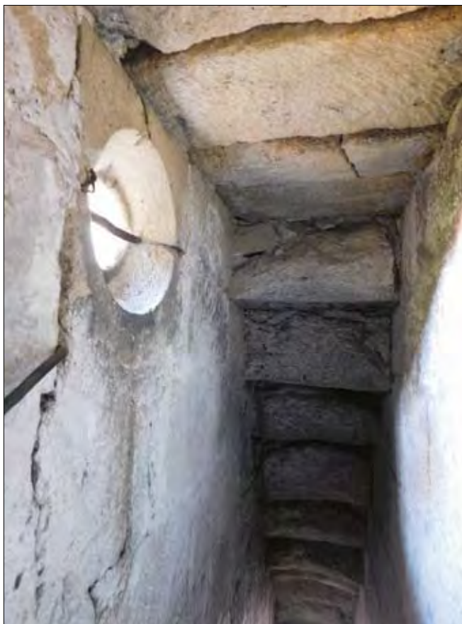
Obr. 13: Hulín, kostel sv. Václava, východní úsek chodbičky v tloušťce severní zdi lodi. Vlevo kruhové okénko, zřetelná je i konstrukce stropu z kamenných desek a velké kamenné bloky, využité pro zastropení schodiště.
