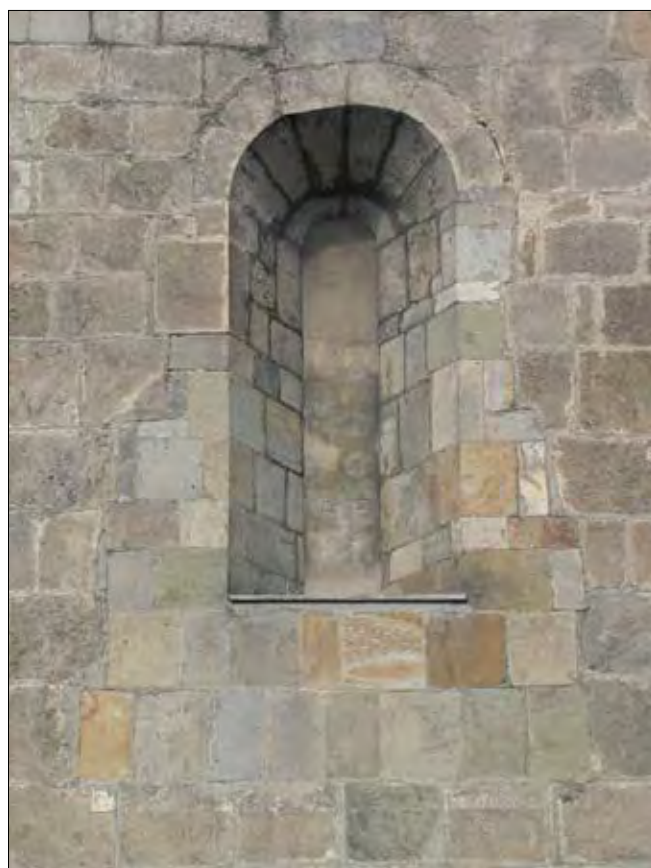
Obr. 10: Hulín, kostel sv. Václava, románské okno uprostřed jižní zdi lodi, pod jehož parapetem zůstala slabě patrná část omítkové pasparty mladšího okna (dole). Spárořez a odlišný druh kamene zřetelně vymezují novodobou dozdívkou kvádrového obkladu, která zacelila otvor po pozdně renesančním či raně barokním oknu.
