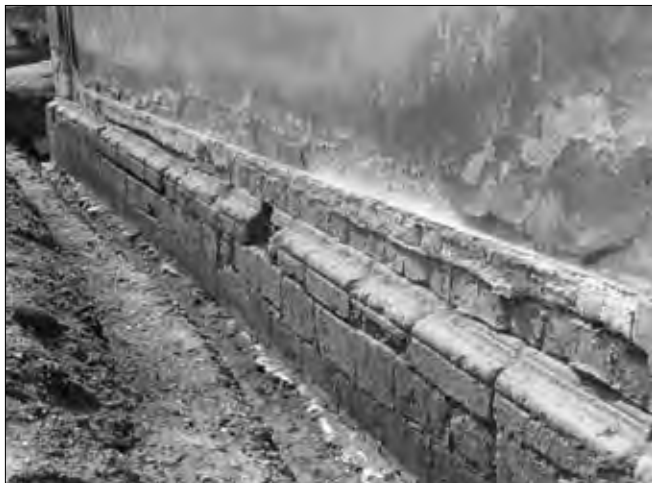
Obr. 4: Hulín, kostel sv. Václava, odkrytý sokl završený profilovanou římsou na jižní straně lodi nasedá na mírně předsazený základ z lomového zdiva (fotografie patrně z let 1947–1948, uložena v archivu NPÚ ÚOP v Kroměříži).
