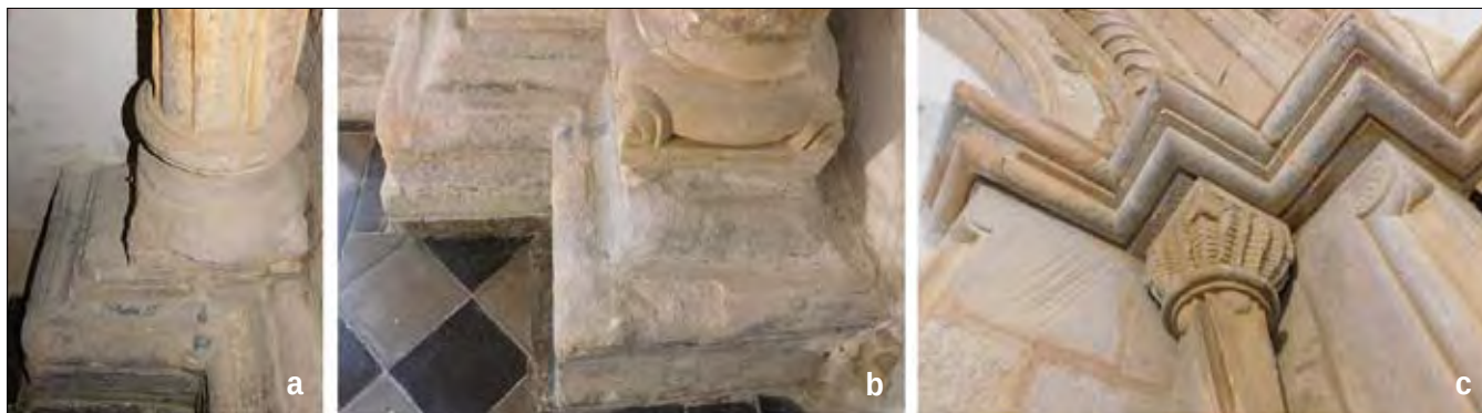
Obr. 23: Hulín, kostel sv. Václava, konstrukční nesrovnalosti románského portálu v severní zdi lodi: a – nesoulad vztahu soklu a vnějšího sloupku východního ostění; b – tatáž situace u vnějšího sloupku západního ostění; c – nepřesné osazení vnitřního sloupku do ústupku v západním ostění portálu.
