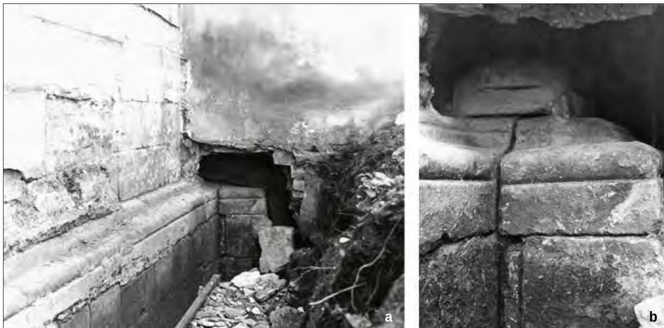
Obr. 20: Hulín, kostel sv. Václava, detaily románského soklu severní zdi lodi a jeho návaznosti na východní ostění severního portálu: a – celkový pohled na sondu do zdiva renesanční předsíně, krujícího styk soklu lodi a portálu; b – detail téhož, z něž je patrná konstrukční provázanost soklu lodi a portálu (fotografie patrně z let 1947–1948, uložená v archivu NPÚ ÚOP v Kroměříži).
