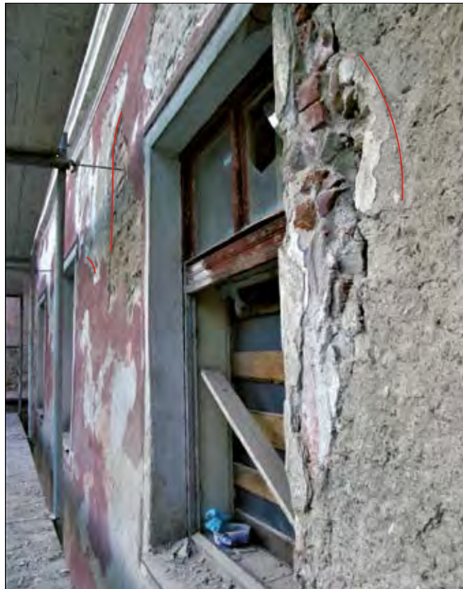
Obr. 47: Český Krumlov, Latrán čp. 74, průčelí domu, zákres sondážně zachycených okenních otvorů v lichoběžníkové sestavě (foto a zákres J. Bloch).
