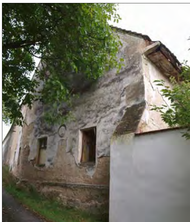
Obr. 34: Radostice (Kamenný Újezd, okres České Budějovice) – usedlost čp. 3, průčelí obytného stavení.
