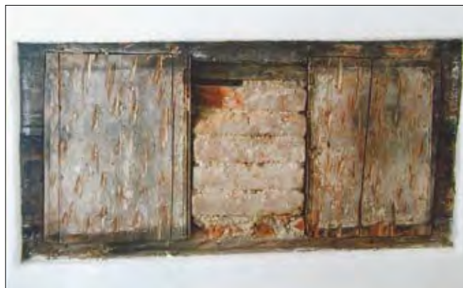
Obr. 39: Český Krumlov, Plešivec čp. 115, jižní stěna světnice, detail pravého spodního okénka s posuvnými okenicemi (foto J. Bloch).
