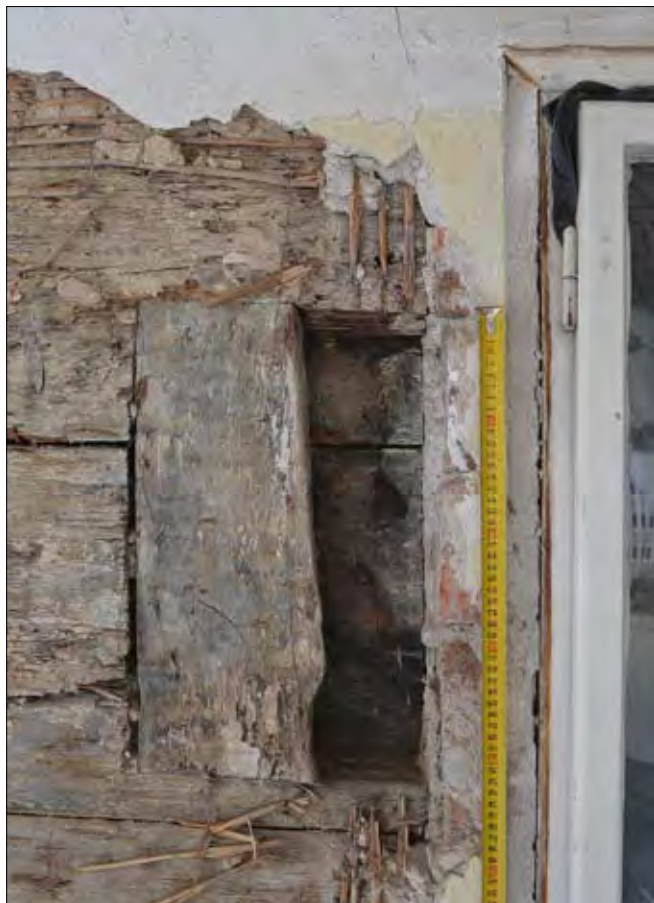
Obr. 22: Vyšší Brod, dům čp. 24, interiér roubené světnice, detail dochovaného fragmentu krycí desky pouzdra okenice okna v dolní řadě, zcela upravo (foto J. Bloch).
