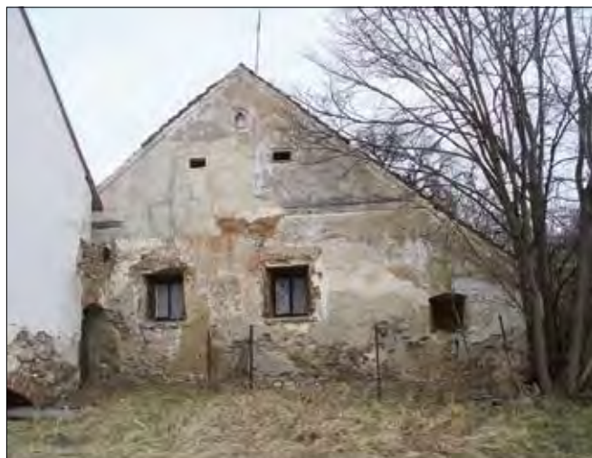
Obr. 35: Záluží (Dolní Třebonín, okres Český Krumlov) – usedlost čp. 6, průčelí obytného stavení.
