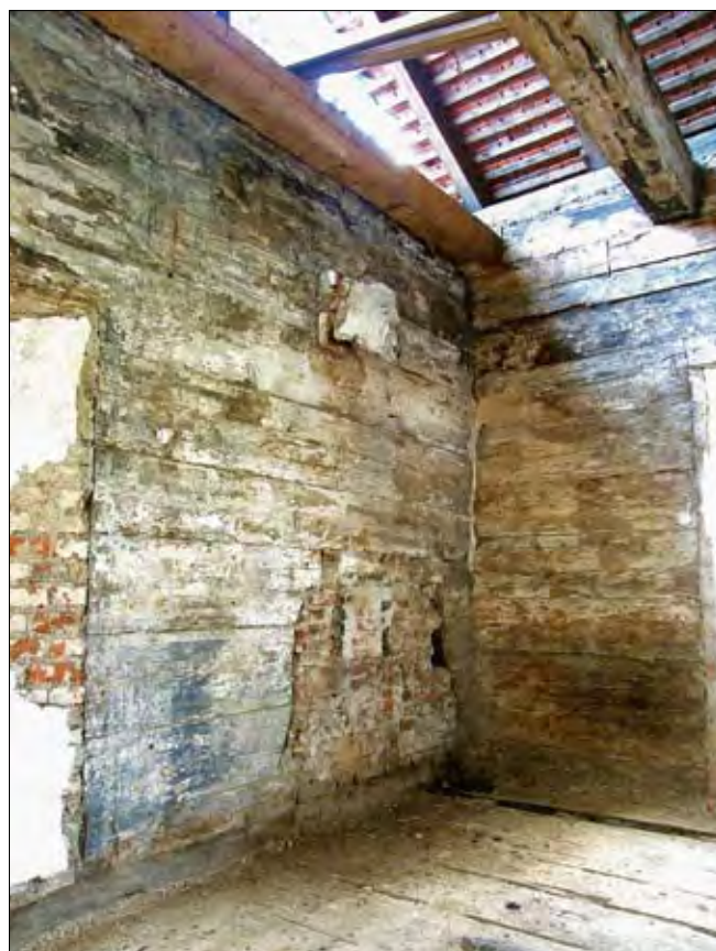
Obr. 43: Český Krumlov, Latrán čp. 74, zadní roubená světnice v patře domu, západní stěna s cihelnou zazdívkou otopného zařízení (foto J. Račák).
