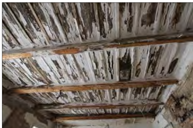
Obr. 14: Vyšší Brod, dům čp. 24, interiér roubené světnice, pohled na trámový strop, mezi trámy uprostřed obrázku je druhotně použitou okenicí zakrytý kruhový otvor pro odvod kouře (foto J. Bloch).
