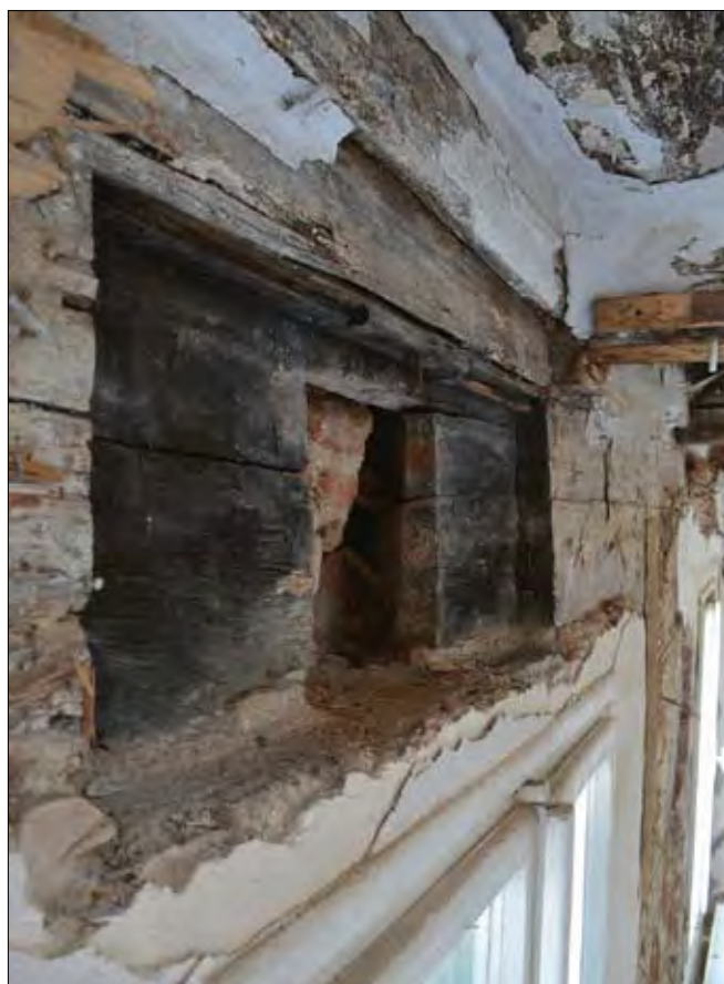
Obr. 20: Vyšší Brod, dům čp. 24, interiér roubené světnice, horní okénko situované těsně pod stropem v západní obvodové stěně (foto J. Bloch).
