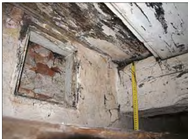
Obr. 53: Český Krumlov, Široká čp. 77, okénko situované těsně pod záklopem stropu ze 16. století (foto D. Šnejdl).
