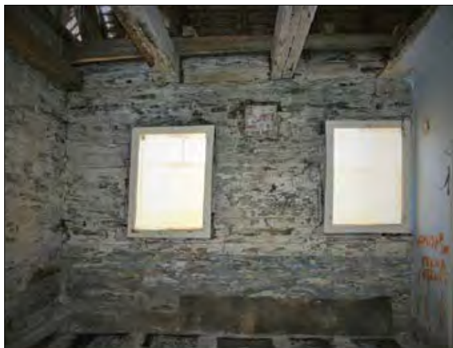
Obr. 44: Český Krumlov, Latrán čp. 74, zadní roubená světnice v patře domu, levá část jižní stěny s fragmenty dvou dolních okenních otvorů a horního okénka (foto J. Bloch).
