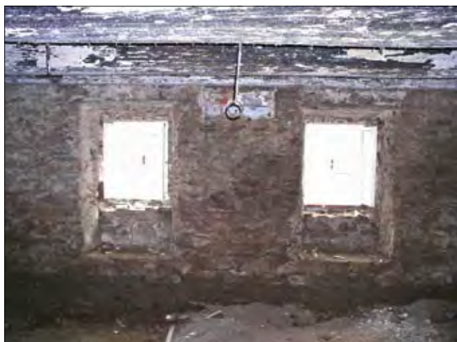
Obr. 30: Hořice na Šumavě – městský dům čp. 15, světnice v přízemí s trojúhelnou sestavou oken, horní okénko zčásti zakryto druhotně sniženým stropem.
