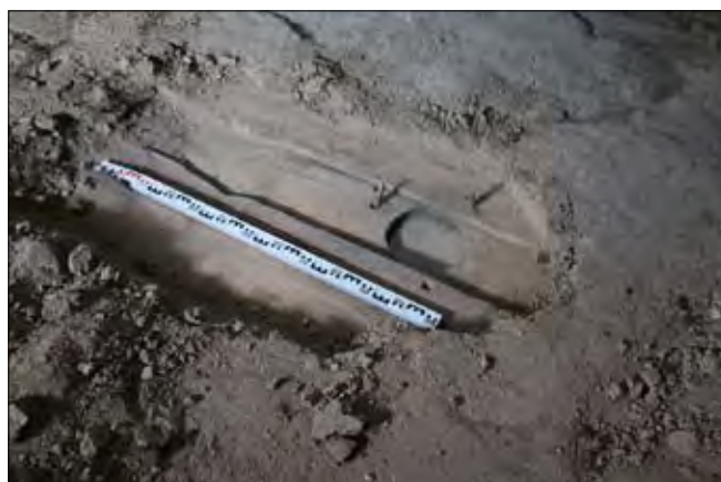
Obr. 17: Vyšší Brod, dům čp. 24, pohled na rubovou stranu záklopu světnice s odkrytým kruhovým otvorem pro odvod kouře (foto J. Bloch).
