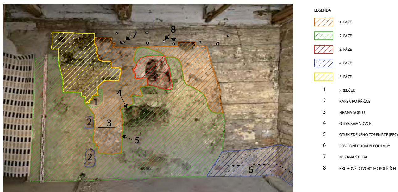
Obr. 13: Vyšší Brod, dům čp. 24, interiér roubené světnice, pohled na východní stěnu se zákresem náleзовé situace (foto J. Bloch; zákres D. Šnejd, V. Babická).
