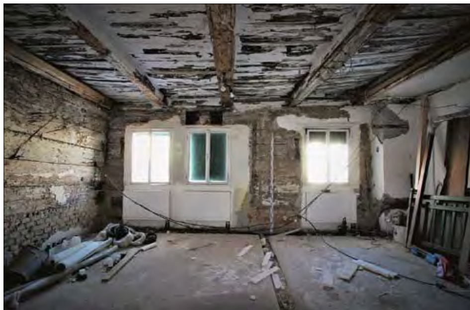
Obr. 11: Vyšší Brod, dům čp. 24, interiér roubené světnice, pohled na západní stěnu s částečně dochovanými původními okénky ve spodní řadě a kompletně dochovaným (bez okenice) horním oknem. Zcela vpravo svislý sloupek ukončující na této straně roubení (foto J. Bloch).
