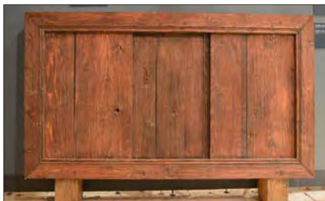
Obr. 41 a, b, c: Volná replika okénka s posuvnými okenicemi zhotovená na základě nálezů v domě čp. 115 na Plešivci v Českém Krumlově.
