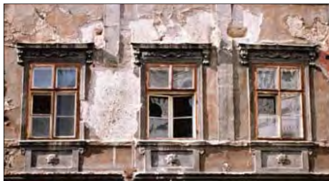
Obr. 54: Český Krumlov, Soukenická čp. 42, v patře průčelí nad stávajícími okny sondážně odkryty dva drobné okenní otvory (foto J. Bloch).
