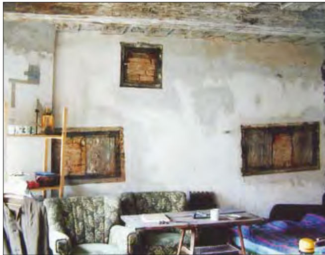
Obr. 38: Český Krumlov, Plešivec čp. 115, jižní stěna světnice s nálezy původních oken (foto J. Bloch).
