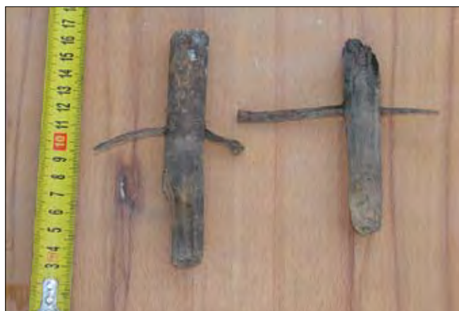
Obr. 18: Vyšší Brod, dům čp. 24, detail konců dřevěných prutů vytažených z otvorů v pravidelných rozestupech kolem kruhového otvoru v záklopu pro odvod kouře. Pruty jsou pravděpodobně pozůstatkem zavěšeného dřevohlinitého osvětlovacího koše (foto J. Bloch).
