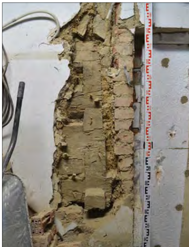
Obr. 23: Vyšší Brod, dům čp. 24, vnější strana roubené světnice, pohled na jižní stěnu z průjezdu, pod novodobou omítkou je dochovaná lepenice propojená s roubením pomocí dřevěných kolíků. Vlevo je viditelná stojka rámu vysoké dřevěné brány se segmentovým nadpražím (foto J. Bloch).
