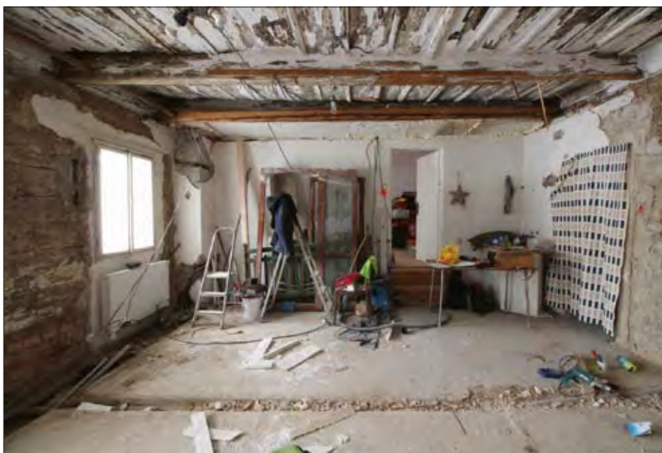
Obr. 10: Vyšší Brod, dům čp. 24, interiér roubené světnice, pohled na severní stěnu z plynosilikátu, která nahradila původní kamennou stěnu komory, její původní šířku dokládá pilíř, který zůstal zachován v levém rohu (foto J. Bloch).
