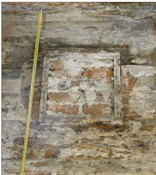
Obr. 45: Český Krumlov, Latrán čp. 74, zadní roubená světnice v patře domu, levá část jižní stěny, detail horního větracího okénka (foto J. Bloch).
