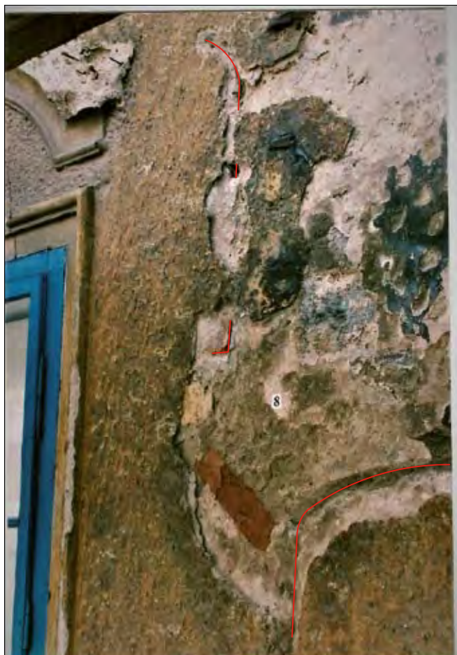
Obr. 51: Český Krumlov, Široká čp. 72, průčelní fasáda, sondážně odkrytá část horního větracího okénka v patře objektu (foto J. Bloch, 2004).
