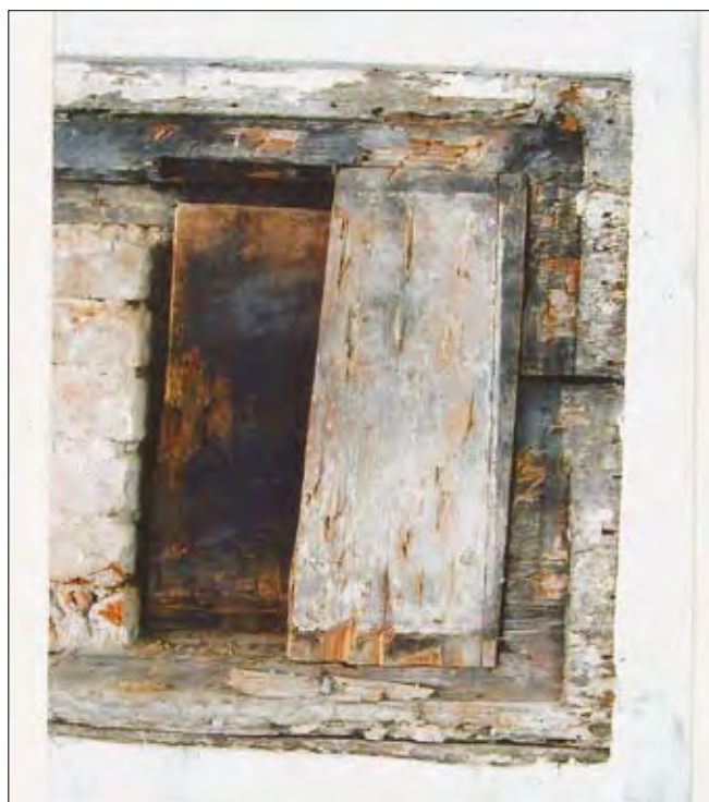
Obr. 40: Český Krumlov, Plešivec čp. 115, východní stěna světnice, detail části spodního okénka s posuvnými okenicemi (foto J. Bloch).
