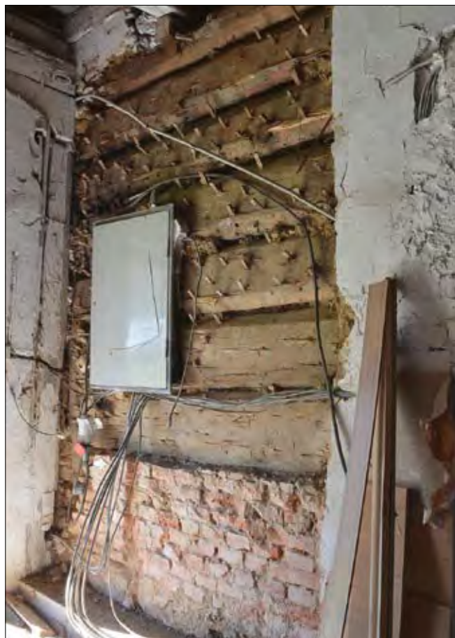
Obr. 23: Vyšší Brod, dům čp. 24, vnější strana roubené světnice, pohled na jižní stěnu z průjezdu, pod novodobou omítkou je dochovaná lepenice propojená s roubením pomocí dřevěných kolíků. Vlevo je viditelná stojka rámu vysoké dřevěné brány se segmentovým nadpražím (foto J. Bloch).
