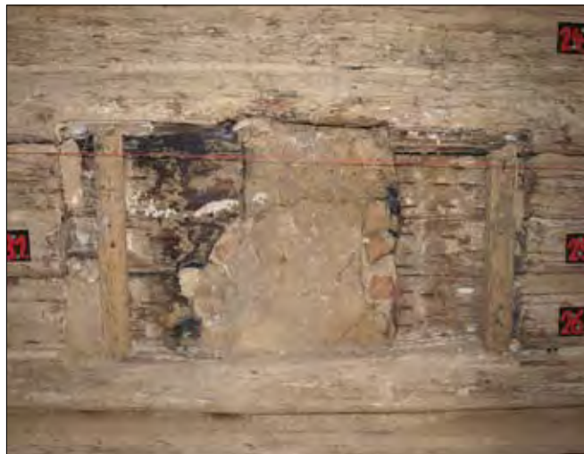
Obr. 27: Mirkovice (okres Český Krumlov) – usedlost čp. 1, okénko s posuvnými okenicemi v jizbě.
