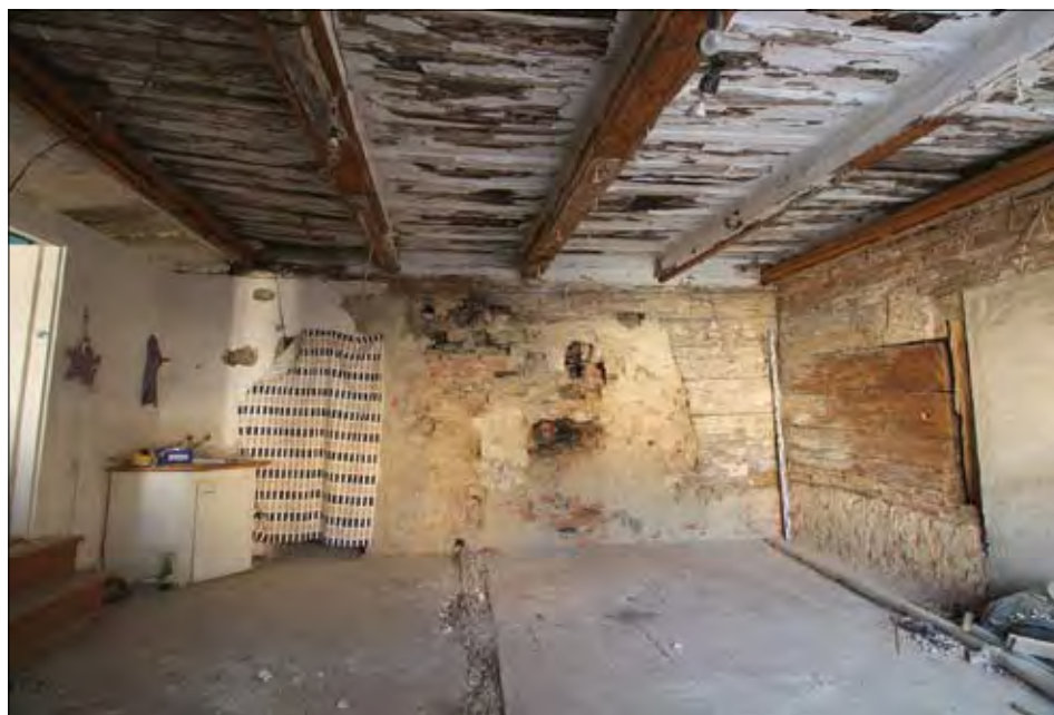
Obr. 12: Vyšší Brod, dům čp. 24, interiér roubené světnice, pohled na východní stěnu s vloženým zděným blokem s řadou postupů topenišť do sousední (nedochované) černé kuchyně (foto J. Bloch).
