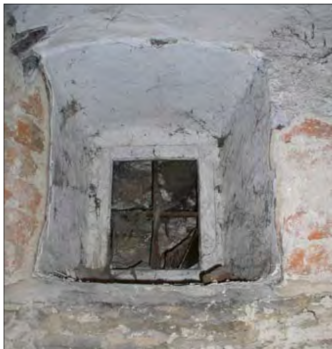
Obr. 32: Michnice – tvrz čp. 1, přízemní místnost, detail horního okénka s mříží.
