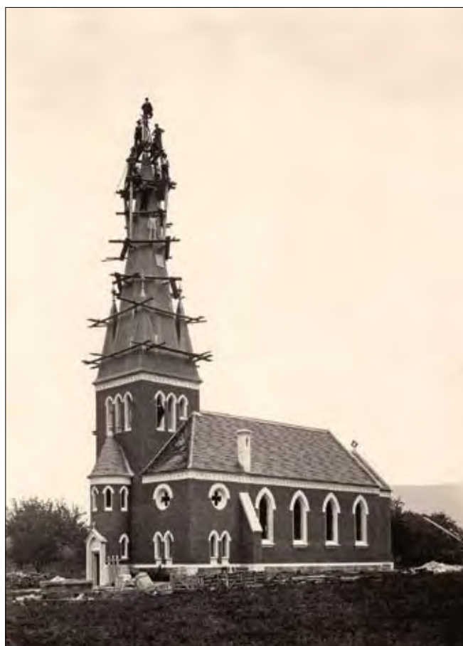
Obr. 11: Kadaň – dokončovací práce na stavbě evangelického kostela na dobovém snímku, 1903 (Oblastní muzeum v Chomutově).
