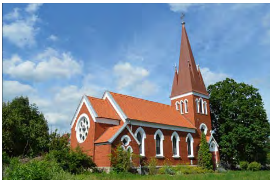
Obr. 12: Kadaň – současný stav evangelického kostela (foto V. Zeman, 2016).
