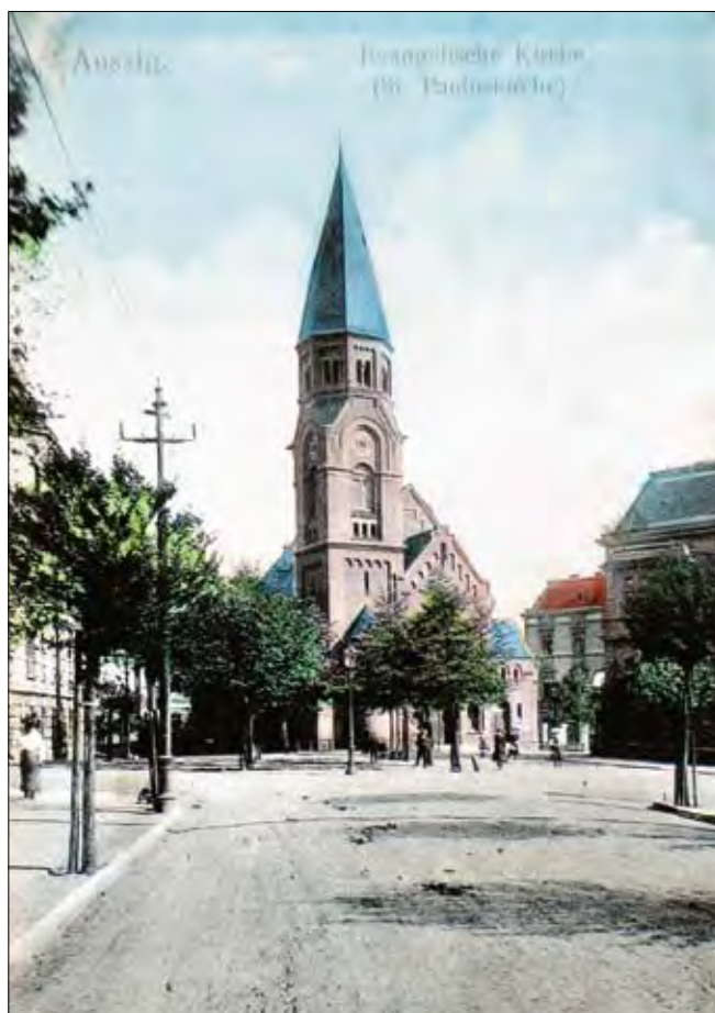
Obr. 20: Evangelický kostel v Ústí nad Labem na pohlednici z počátku 20. století (AM Ústí nad Labem).
