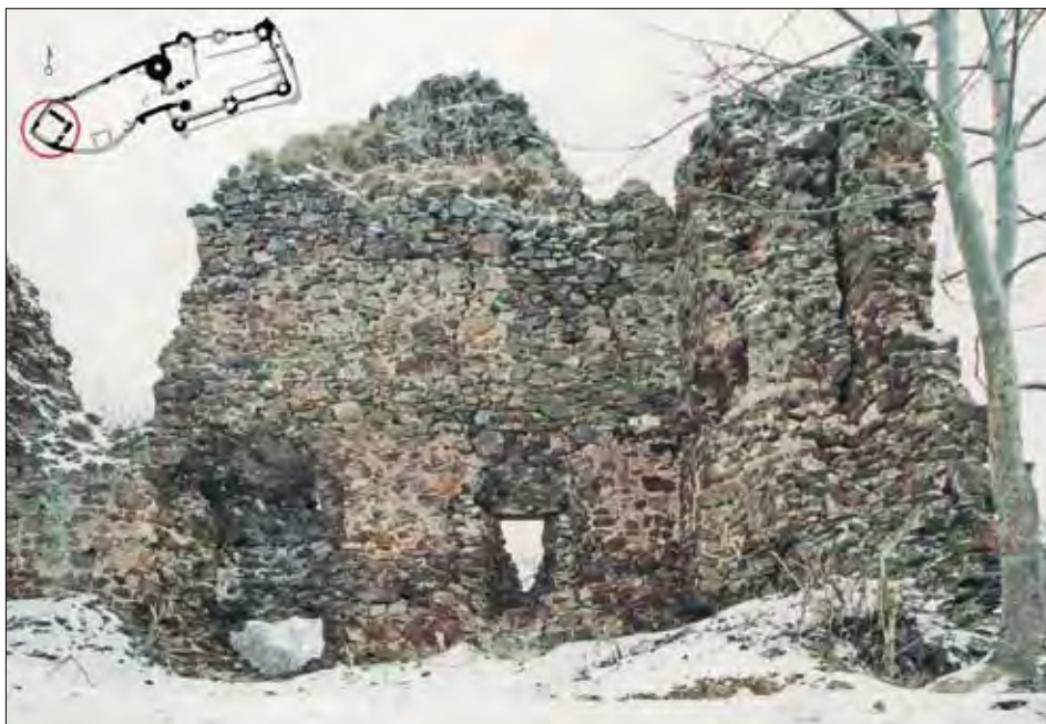
Obr. 1: Hrad Týřov (okres Rakovník) – interiér věžového paláce v pohledu od SZ, stav v roce 2001. Vpravo JZ zeď, zčásti rozdělená vnitřní svislou spárou. Zdivo vlevo od spáry se v roce 2015 zřítílo (srov. obr. 5), včetně kapes po stropních trámech přízemí. Vlevo nahoře situační plánec hradu s vyznačenou polohou paláce (všechny snímky autor, není-li uvedeno jinak).
