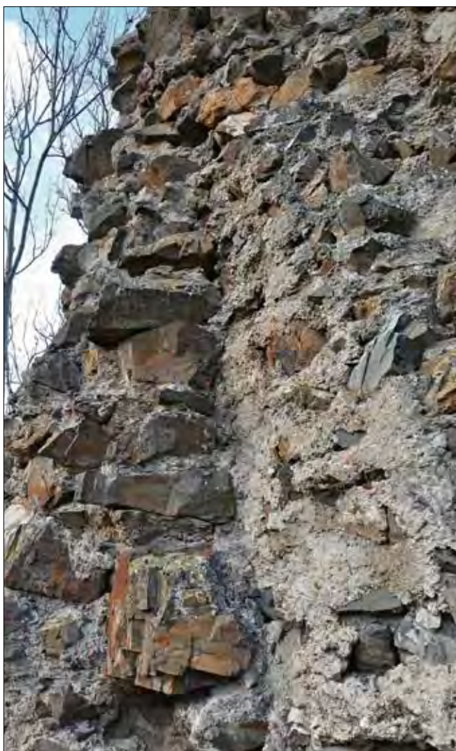
Obr. 9: Detail situace na obr. č. 8 – spára mezi starší částí JZ zdi (vlevo, s dochovanými většími kameny vnitřního líce) a mladší částí JV zdi. Snímek 2015.
