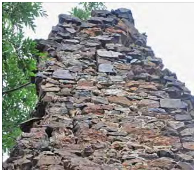
Obr. 7: Detail vnější strany zubu cimbuří (vpravo od svislé spáry), zazdívky proluky (vlevo od svislé spáry) a nadezdívky (nahore; srov. obr. 6). Stav 2015, po destrukci zdíva na vnitřní straně.
