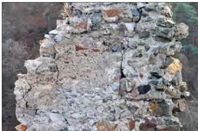
Obr. 6: Detail vnitřní strany zubu cimbuří s pozdější nadezdívkou a zazdívkou proluky (srov. obr. 5). Snímek 2015.
