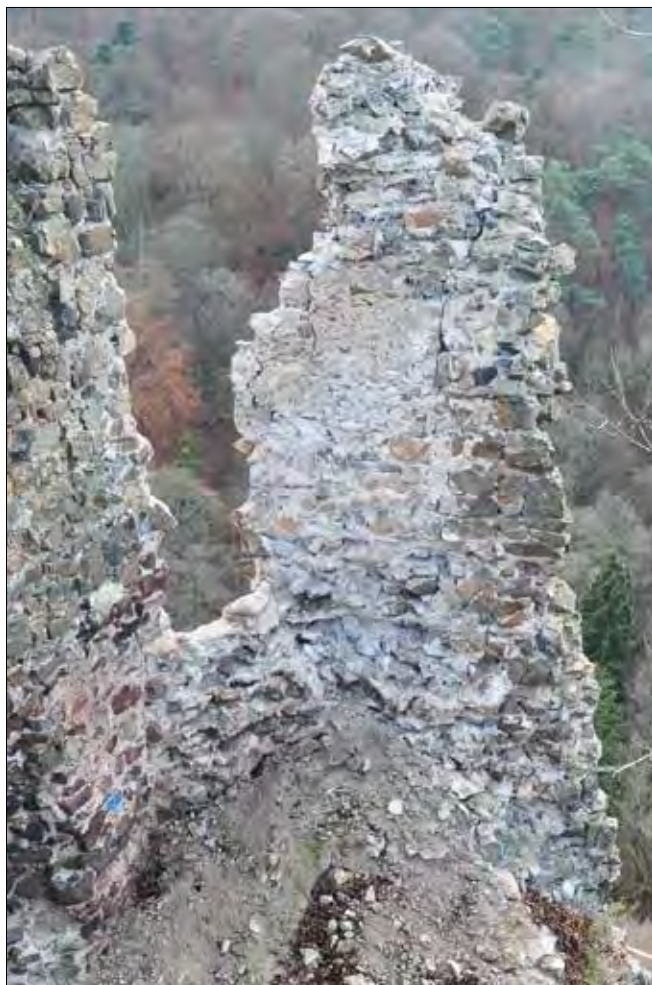
Obr. 5: Pohled z interiéru paláce na JZ stěnu, stav po destrukci v roce 2015. Uprostřed líc předprsň zídky se zubem cimbuří. V proluce cimbuří (vpravo) a nad zubem pozdější nelicované zdivo – součást druhé stavební fáze, která cimbuří zrušila (srov. obr. 3 dole a 6). Snímek 2015.
