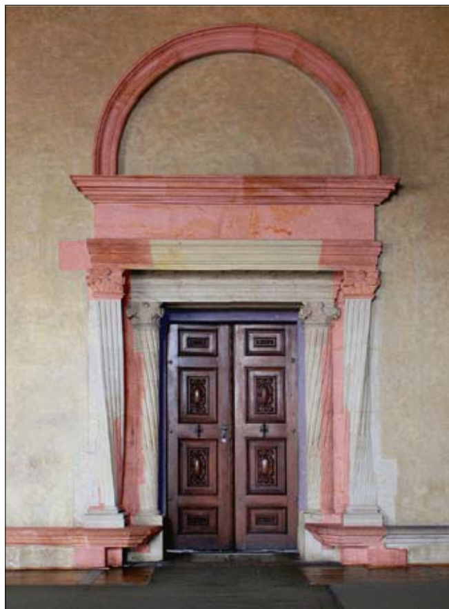
Obr. 15: Pražský hrad, Vladislavský sál, portál do Sněmovny, rozlišení původnosti: červená – původní prvky; modrá – přesunutá ostění; bez barvy – prvky obnovené za K. Fialy.
