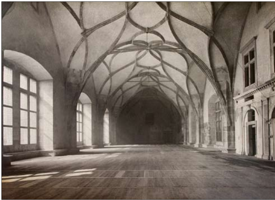
Obr. 11: Pražský hrad, Vladislavský sál, stav po roce 1928/29 (APH, Sběrka fotografií Stavební správy PH, inv. č. 114, foto J. Štenc, 1928/29, Archiv Štenc Praha).
