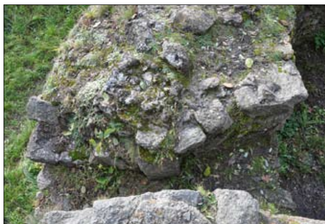
Obr. 15: Bašta na Hrádku, věž, pohled shora do spodní části jihovýchodní střílny. Uprostřed stojka průstřelnice.
