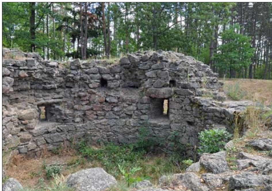
Obr. 14: Bašta na Hrádku, věž, pohled do interiéru od jihozápadu. Dvě takřka kompletní střílny, vpravo dolní část třetí ze střílen. Nad střílnami negativy stropních trámů, v úrovni parapetů střílen několik kapes nejasného účelu.
