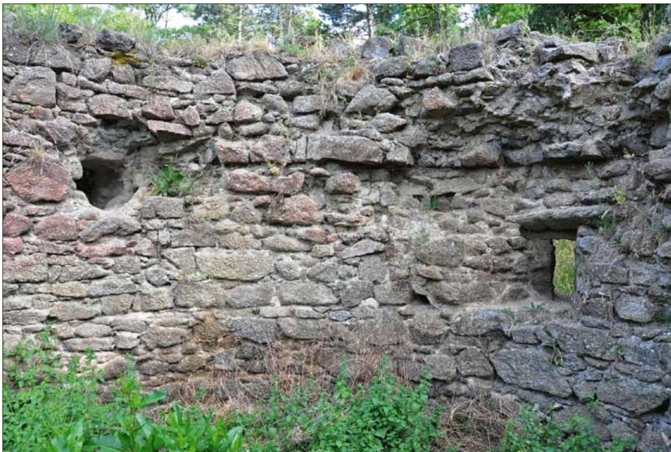
Obr. 16: Bašta na Hrádku, věž, pohled do interiéru od jihu. Vpravo střílna, vlevo poškozené vnitřní ústí uvažovaného vrhacího otvoru.
