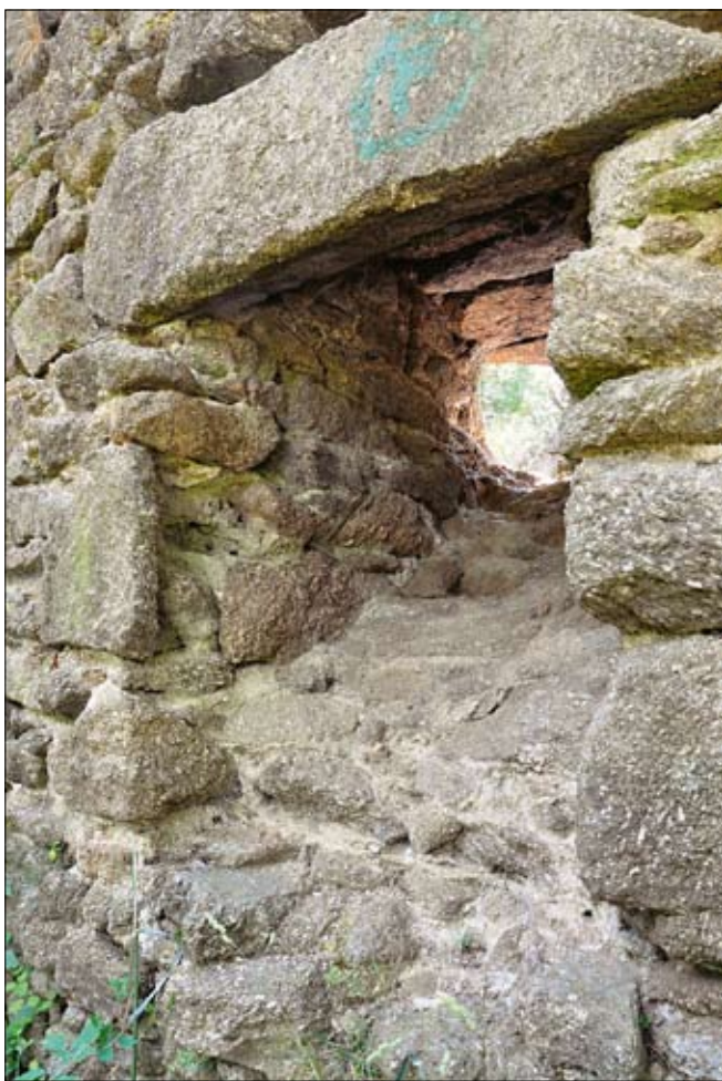
Obr. 12: Bašta na Hrádku, věž, detail vnějšího ústí uvažovaného vrhacího otvoru v pohledu od jihozápadu. Dole v popředí odlomená koncová část „skluzné“ plochy, původně snad zakončená římsou. Tato plocha byla podle dochovaných stop zřejmě zarovnána maltovým potěrem.
