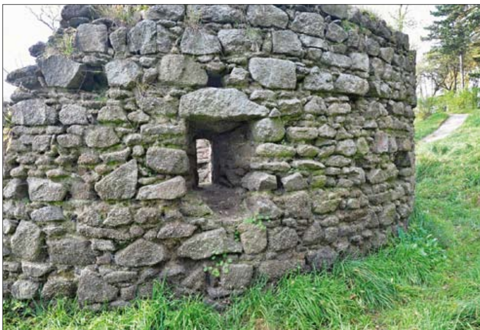
Obr. 11: Bašta na Hrádku, věž, detail vnějšího ústí střílny na severovýchodě (srov. obr. 7, vlevo).
