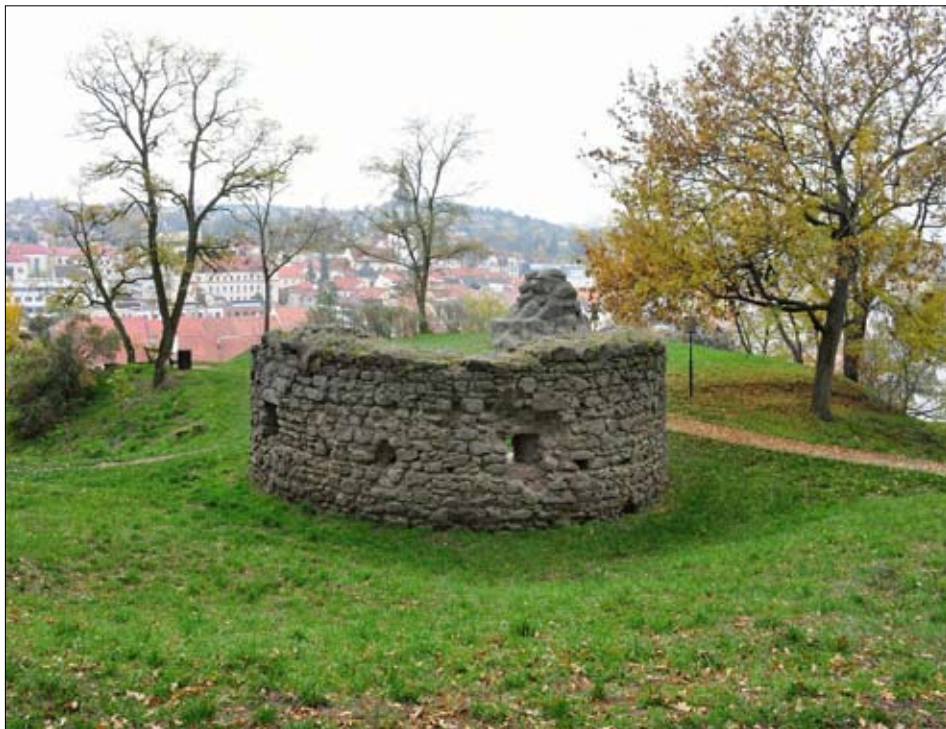
Obr. 7: Bašta na Hrádku v pohledu od severovýchodu. V popředí věž, v pozadí hlavní část bašty (s novodobou kamennou mohylou, srov. obr. 10). Před věží a po jejích stranách deprese příkopu, přerušená cestami.
