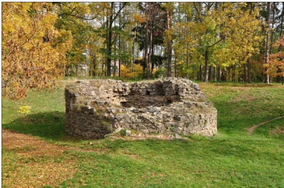
Obr. 9: Bašta na Hrádku, pohled na věž od jihozápadu, z prostoru hlavní části bašty. Vpředu uprostřed segmentové vybrání v plášti zdiva – stopa druhotného napojení na obvodovou hradbu hlavní části bašty. Za věží část čelního průkopu.
