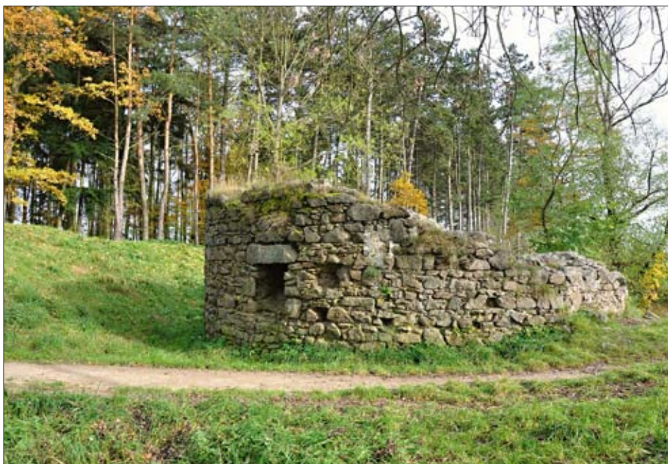
Obr. 8: Bašta na Hrádku, pohled na věž od západu. Vlevo vrhací otvor, vpravo segmentové vybrání v plášti zdiva – stopa druhotného napojení na obvodovou hradbu hlavní části bašty. Vlevo od věže zbytek příkopu.
