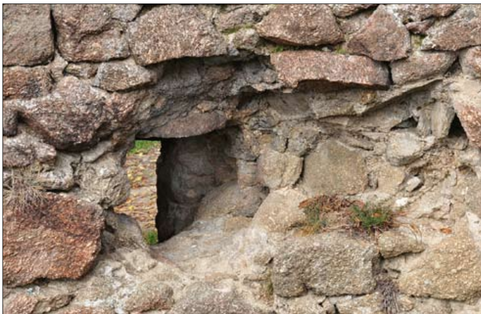
Obr. 17: Bašta na Hrádku, věž, detail vnitřního ústí uvažovaného vrhacího otvoru (srov. obr. 16 vlevo).
