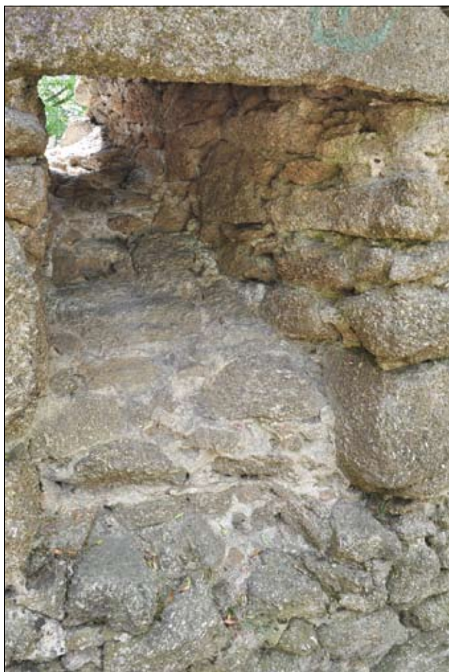
Obr. 13: Bašta na Hrádku, věž, detail vnějšího ústí uvažovaného vrhacího otvoru v pohledu od severozápadu.
