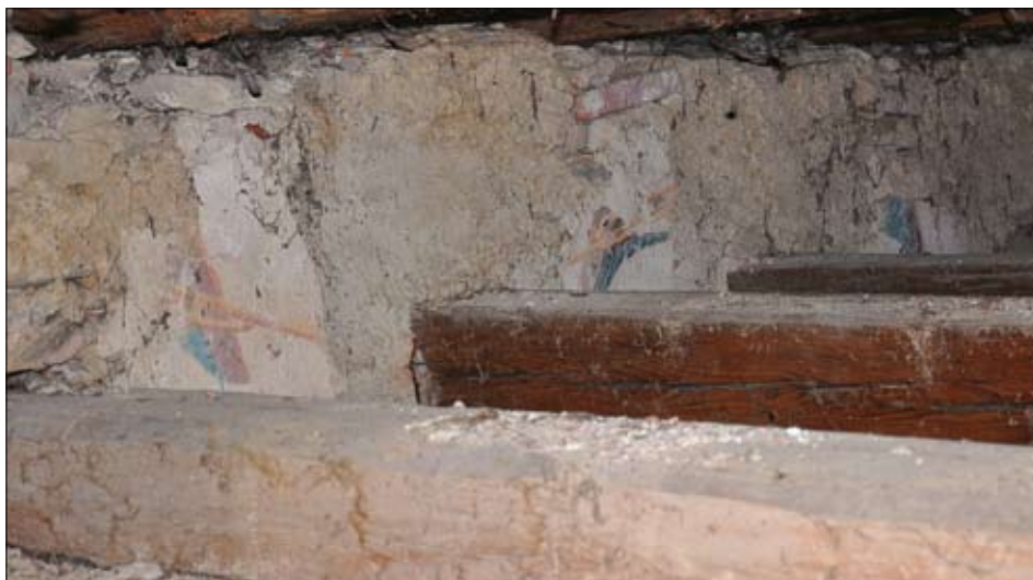
Obr. 11: Křištín, kostel sv. Matouše, jižní strana půdního prostoru lodi mezi stropy, fragment nástěnné malby andělů patrně ve scéně Posledního soudu, kolem roku 1500.
