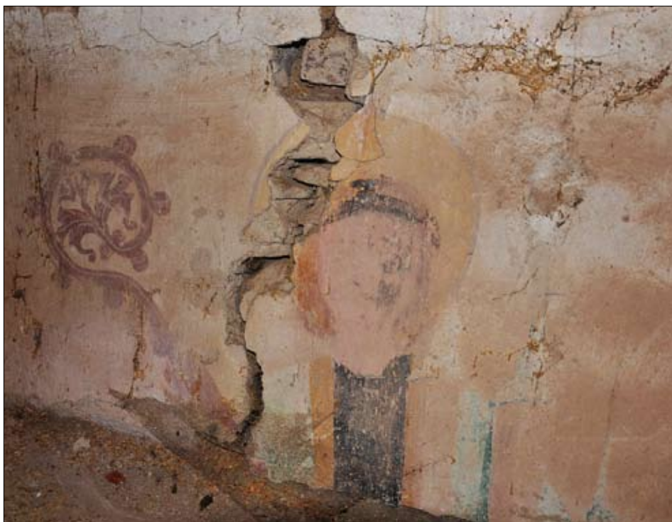
Obr. 5: Křištín, kostel sv. Matouše, východní strana půdního prostoru lodi mezi stropy, fragment nástěnné malby světce, kolem roku 1500.
