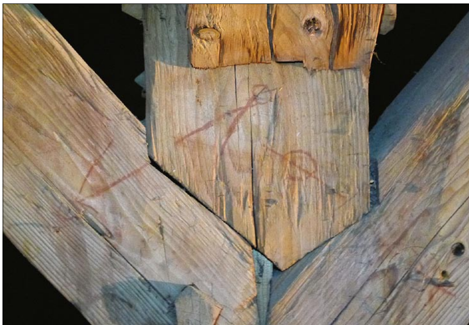
Obr. 7: Polička, kostel sv. Michaela – detail montážního číslování krovu nad presbytářem.
