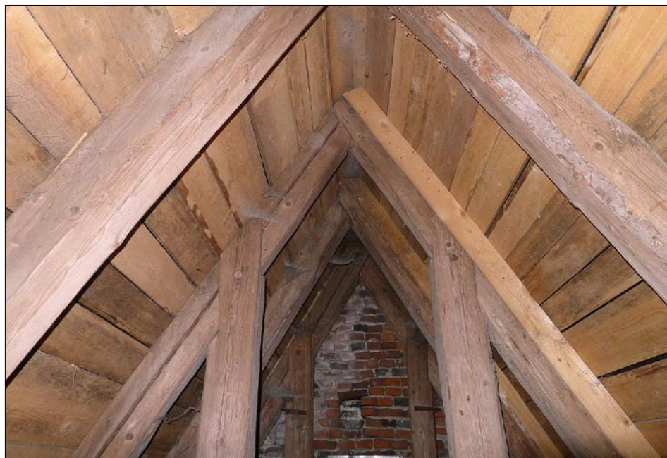
Obr. 5: Polička, kostel sv. Michaela – vrcholová část krovu nad trojlodím.
