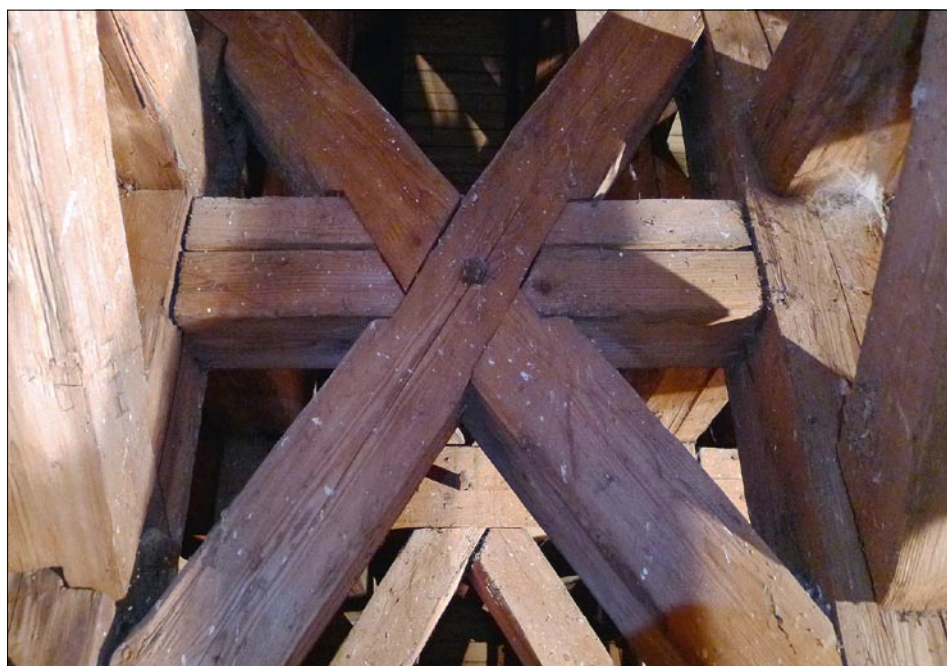
Obr. 6: Polička, kostel sv. Michaela – detail trojitěho přeplátování v krovu nad trojlodím.
