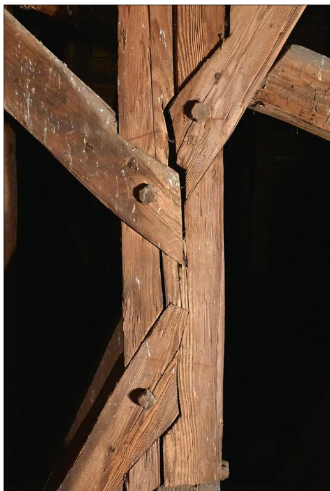
Obr. 8: Polička, kostel sv. Michaela – detail plátových spojů na sloupku v krovu nad trojlodím.
