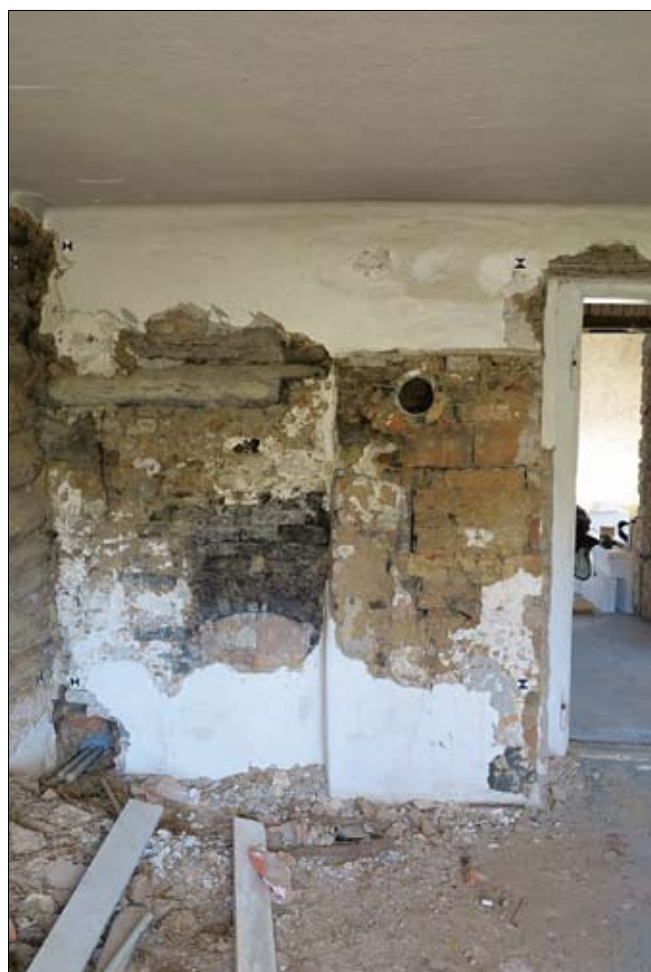
Obr. 10: Stříbro, Ruská ulice, dům čp. 305. Severní stěna místnosti A s relikty topenišť.
