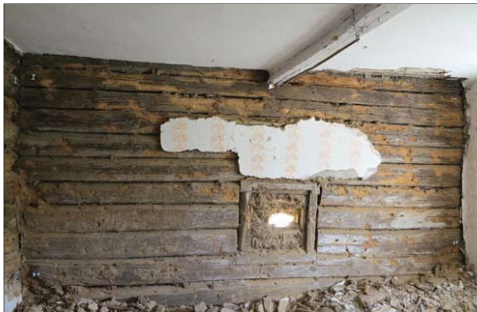
Obr. 12: Stříbro, Ruská ulice, dům čp. 305. Východní stěna místnosti B s okénkem.
