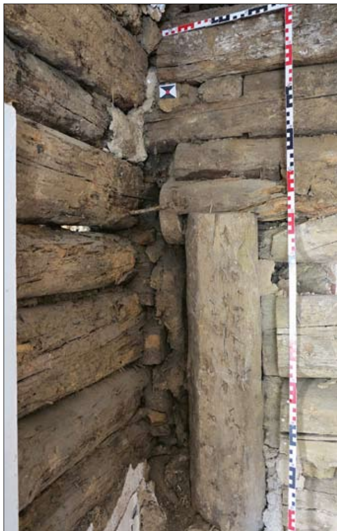
Obr. 13: Stříbro, Ruská ulice, dům čp. 305. Severozápadní nároží místnosti B.
