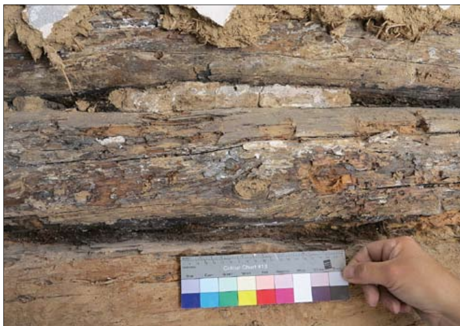
Obr. 11: Stříbro, Ruská ulice, dům čp. 305. Východní stěna místnosti A s detaily vymazání spár a povrchovými úpravami.
