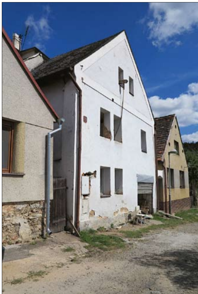
Obr. 4: Stříbro, Ruská ulice, dům čp. 305. Hlavní uliční průčelí domu, stav srpen 2016 (všechny snímky autorka).
