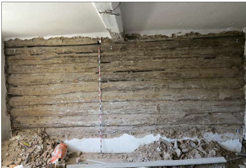
Obr. 8: Stříbro, Ruská ulice, dům čp. 305. Západní roubená stěna v patře v místnosti A.
