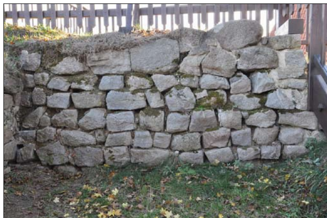
Obr. 2: Hrad Zvíkov, úsek západního líce severní části štítové zdi ze sbíraného kamene (foto J. Varhaník, 2015).
