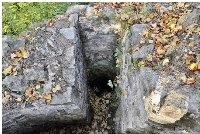
Obr. 3: Hrad Velešín, výklenek s odpadní jímkou v dochované spodní části válcové věže (foto J. Varhaník, 2017).
