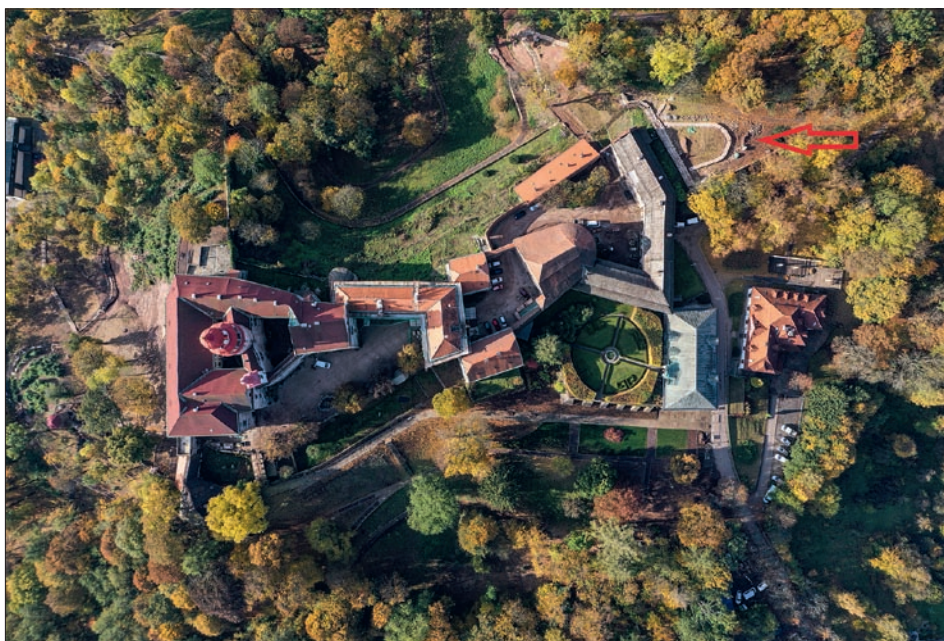
Obr. 4: Náchod, zámek. Letecký pohled, pozice předsunuté bašty označena šipkou, snímek pořízen po obnově a památkové prezentaci objektu nadzemním zdívem (foto T. Kravciv).
