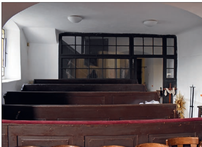
Obr. 38: Poděbrady, kostel Povýšení sv. Kříže. Přízemní oratoř na jižní straně, pohled z presbytáře. Zadní prosklená stěna u schodiště do patra realizována mezi lety 1888–1891 (stav 2024).
