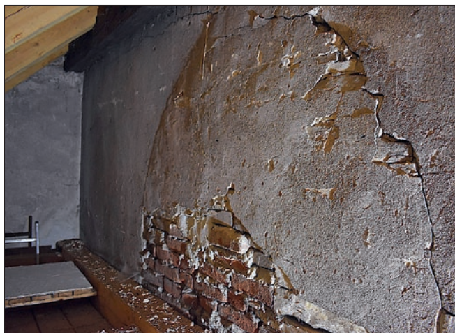
Obr. 39: Poděbrady, kostel Povýšení sv. Kříže. Zazděné gotické okno patrné z podstřeší jižní oratoře (stav 2024).
