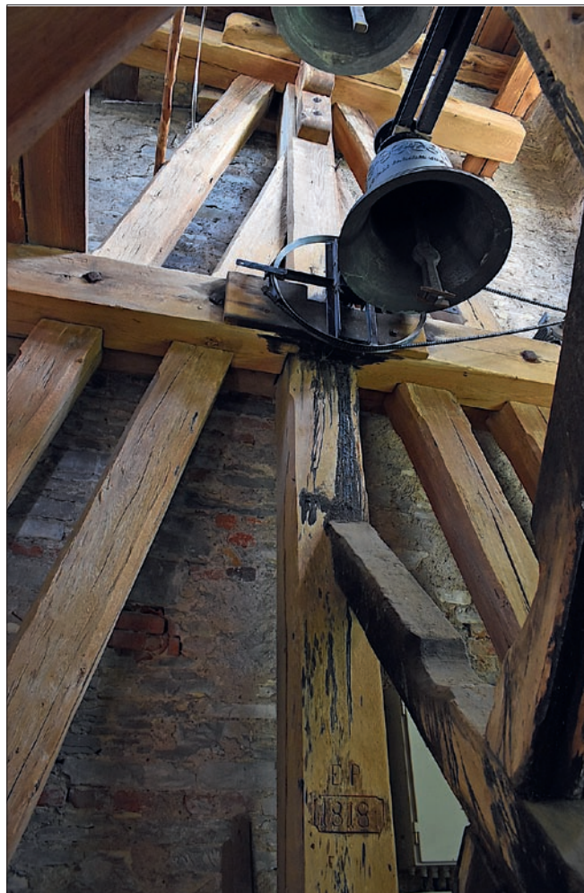
Obr. 35: Poděbrady, kostel Povýšení sv. Kříže. Východní vazba zvonové stolice s monogramem E.P. a letopočtem 1818 (stav 2024).
