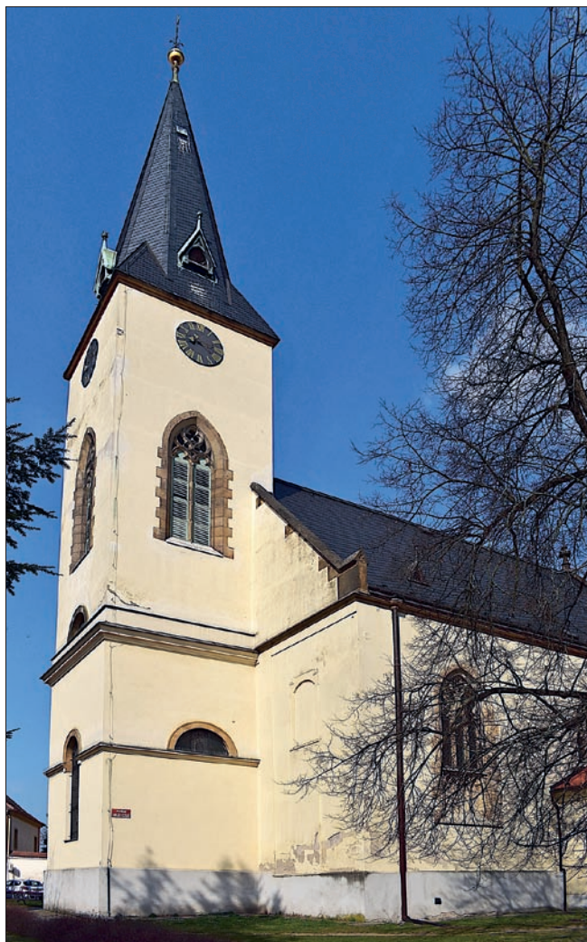
Obr. 32: Poděbrady, kostel Povýšení sv. Kříže od jihozápadu. Věž je až po úroveň oken hodinových ciferníků z roku 1818. Vpravo pod štítem zazděné barokní okno (stav 2024).
