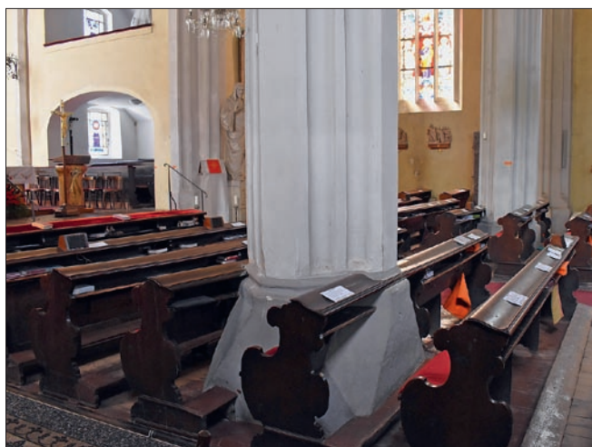
Obr. 8: Poděbrady, kostel Povýšení sv. Kříže. Střední pilíře trojlodí, v předě včetně soklu (stav 2024).
