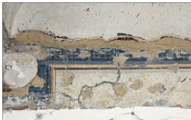
Obr. 24: Františkovy Lázně, dům čp. 5, nástěnná malba při vstupu do lázeňské koupelny v přízemí (foto L. Zeman, 2024).
